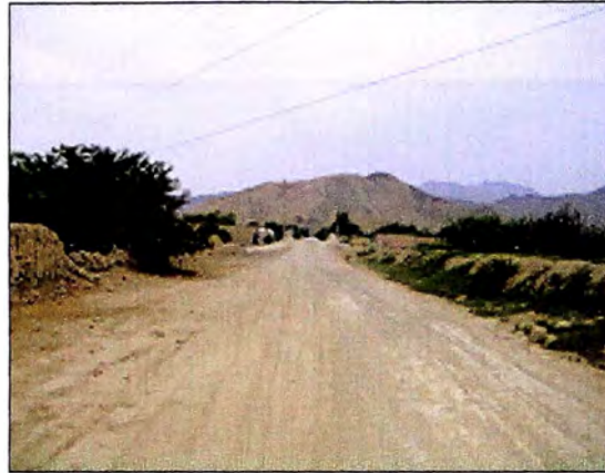
Vía principal y única del anexo.
