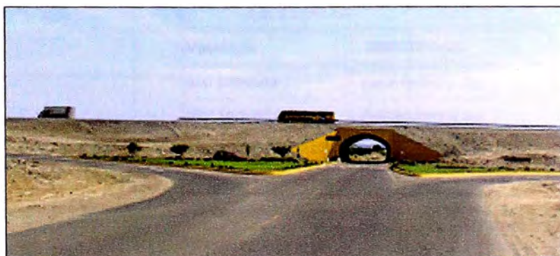
Foto 3.18 - Vista del by pass ubicado en el km 101 de la Panamericana Sur (lado izquierdo)
