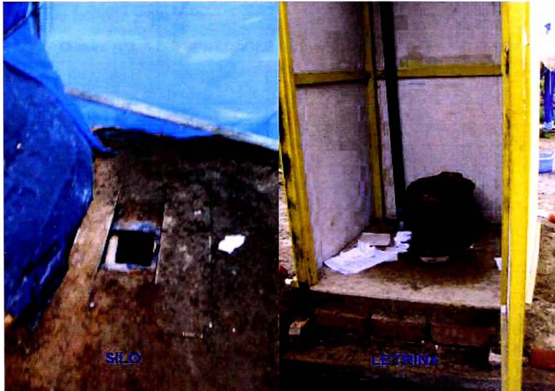
Figura N° 5 SILOS Y LETRINAS EN LOS C.P. LA FLORIDA Y EL DESIERTO
