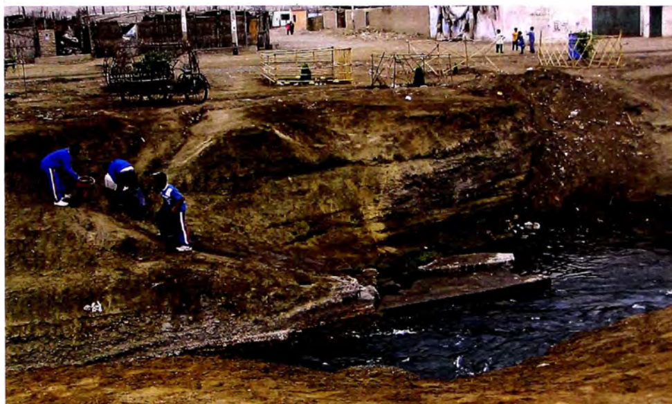
Figura N° 4 ABASTECIMIENTO DE AGUA EN LA FLORIDA DEL CANAL DE RIEGO
