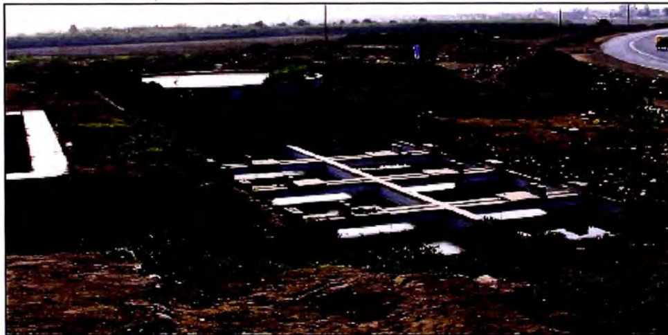
Gráfico N°2. 5 PLANTA DE TRATAMIENTO DE AGUAS SERVIDAS
