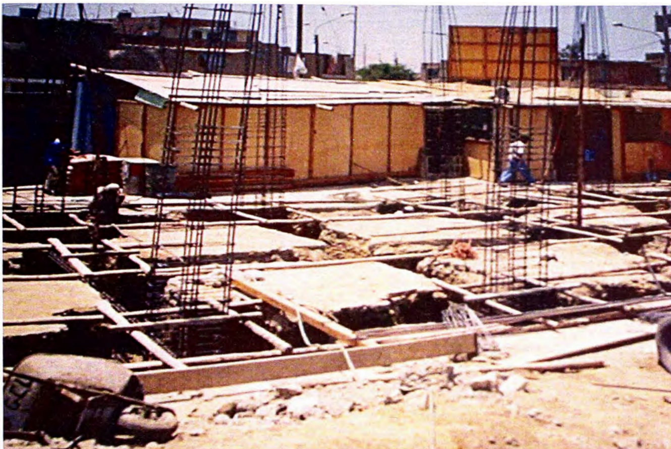
FOTO No. 11: VISTA DE EXCAVACIONES E IZADO DE COLUMNAS Y PLACAS
