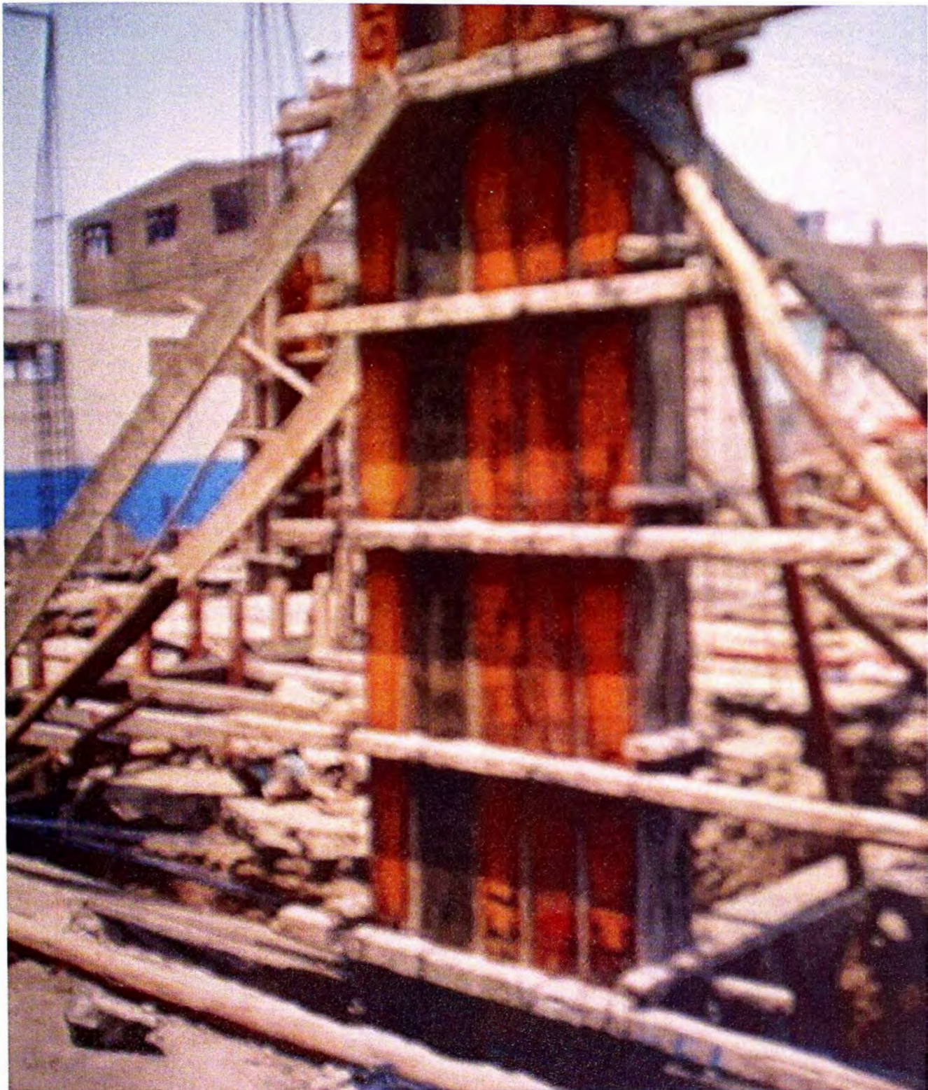
FOTO No. 15: VISTA DE ENCOFRADO Y VACEADO DE COLUMNA
