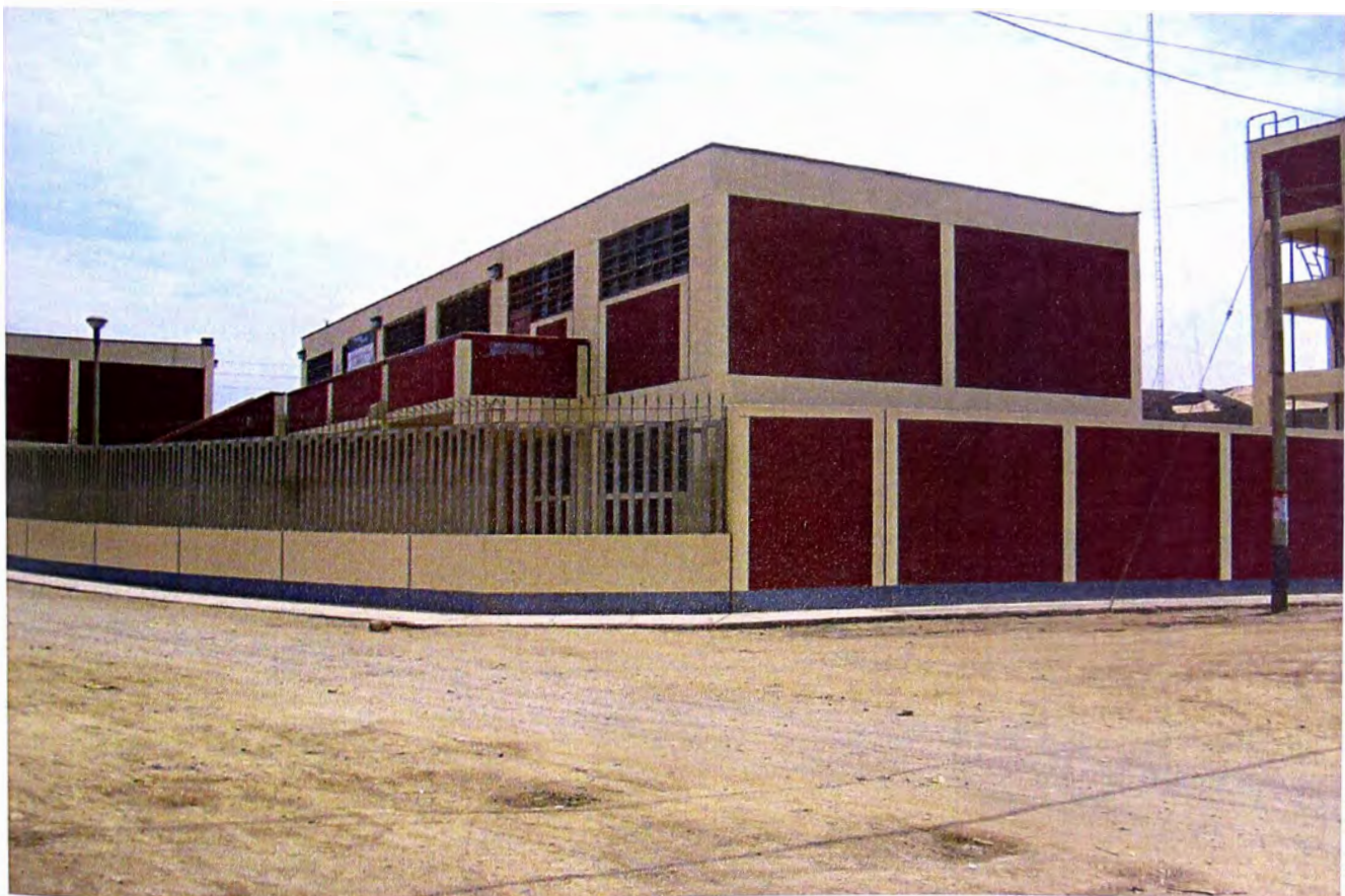
FOTO No. 48: FACHADA LATERAL DEL C.E. No. 89013 SAN ISIDRO - CONCLUIDA
