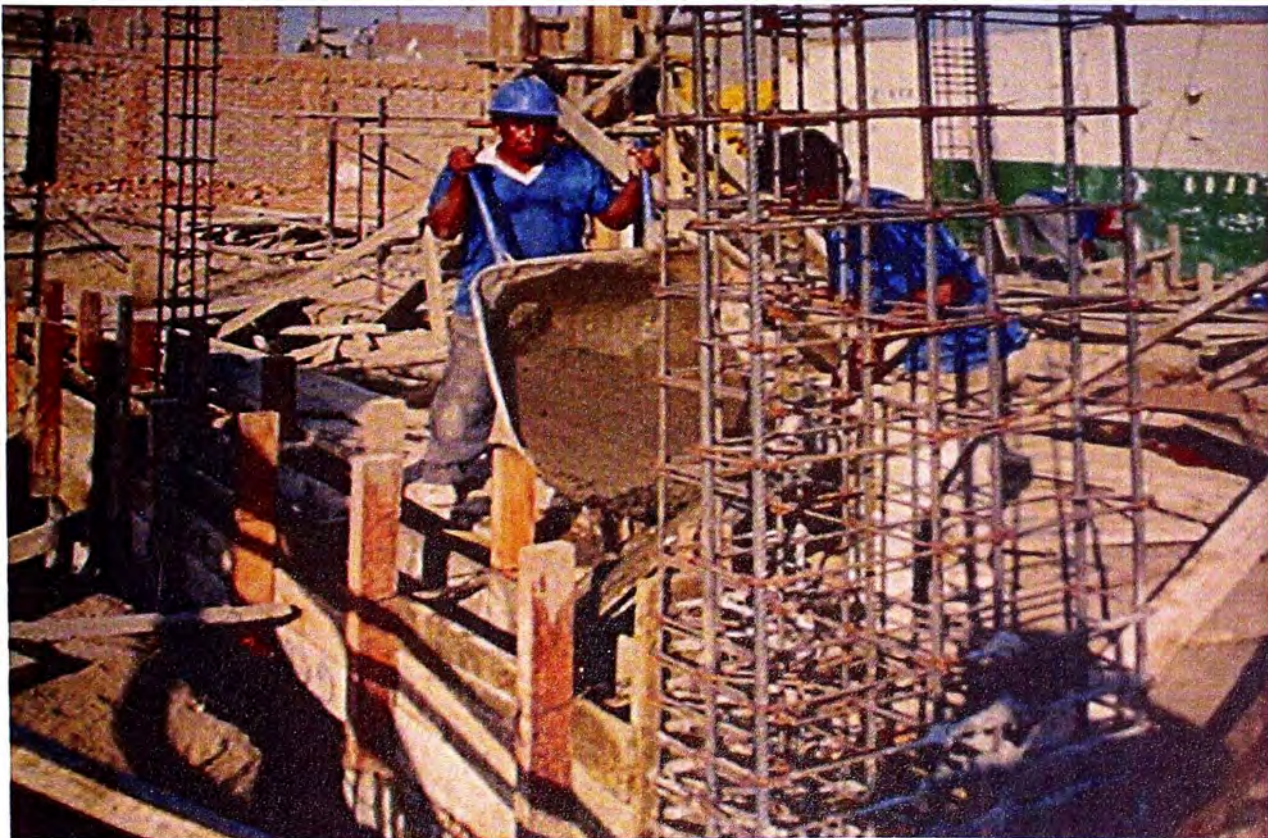
FOTO No. 14: VISTA DE VACEADO DE CIMENTACIONES
