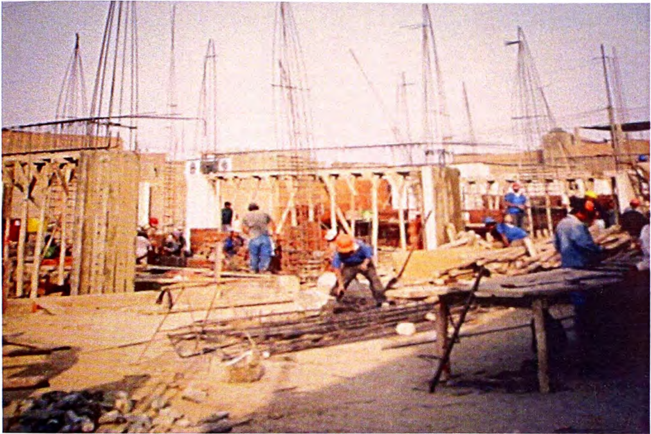
FOTO No. 23: VISTA DE PLACAS VACEADAS Y ENCOFRADO DE FONDO DE VIGAS
