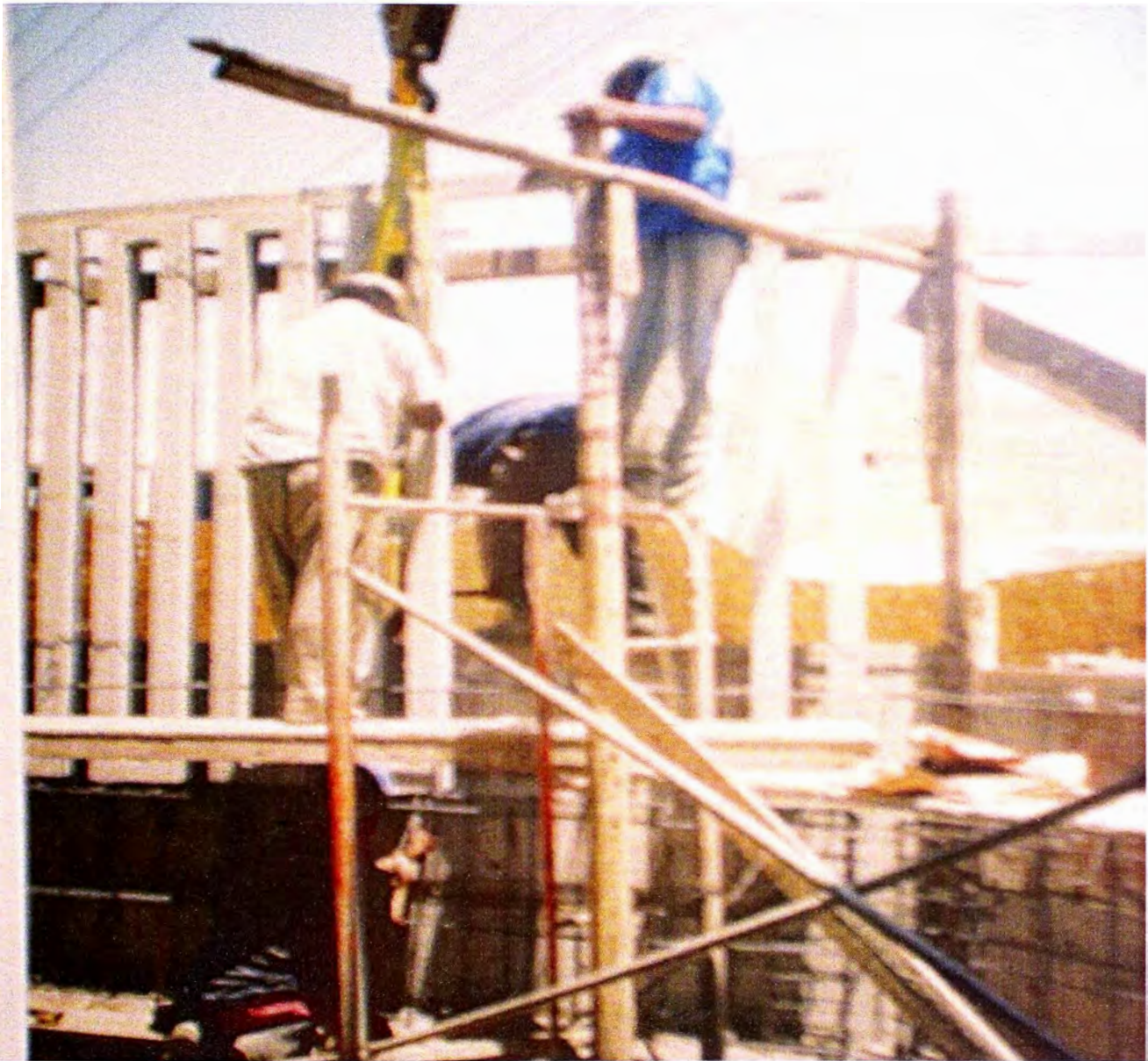
FOTO No. 46: VISTA DE IZADO DE COLUMNETAS EN CERCO PERIMETRICO
