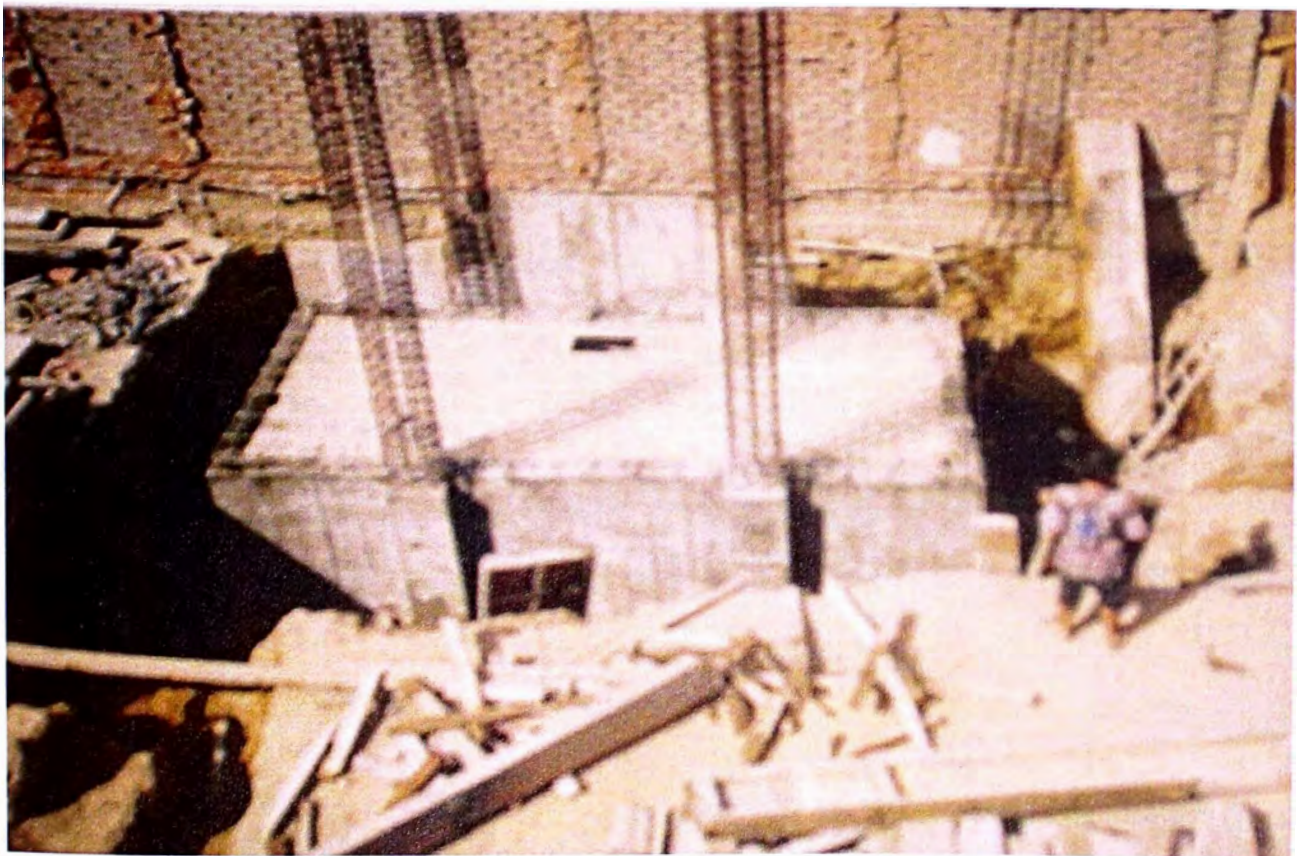
FOTO No. 41: VISTA DE CISTERNA CONCLUIDA E INICIO DE TANQUE ELEVADO
