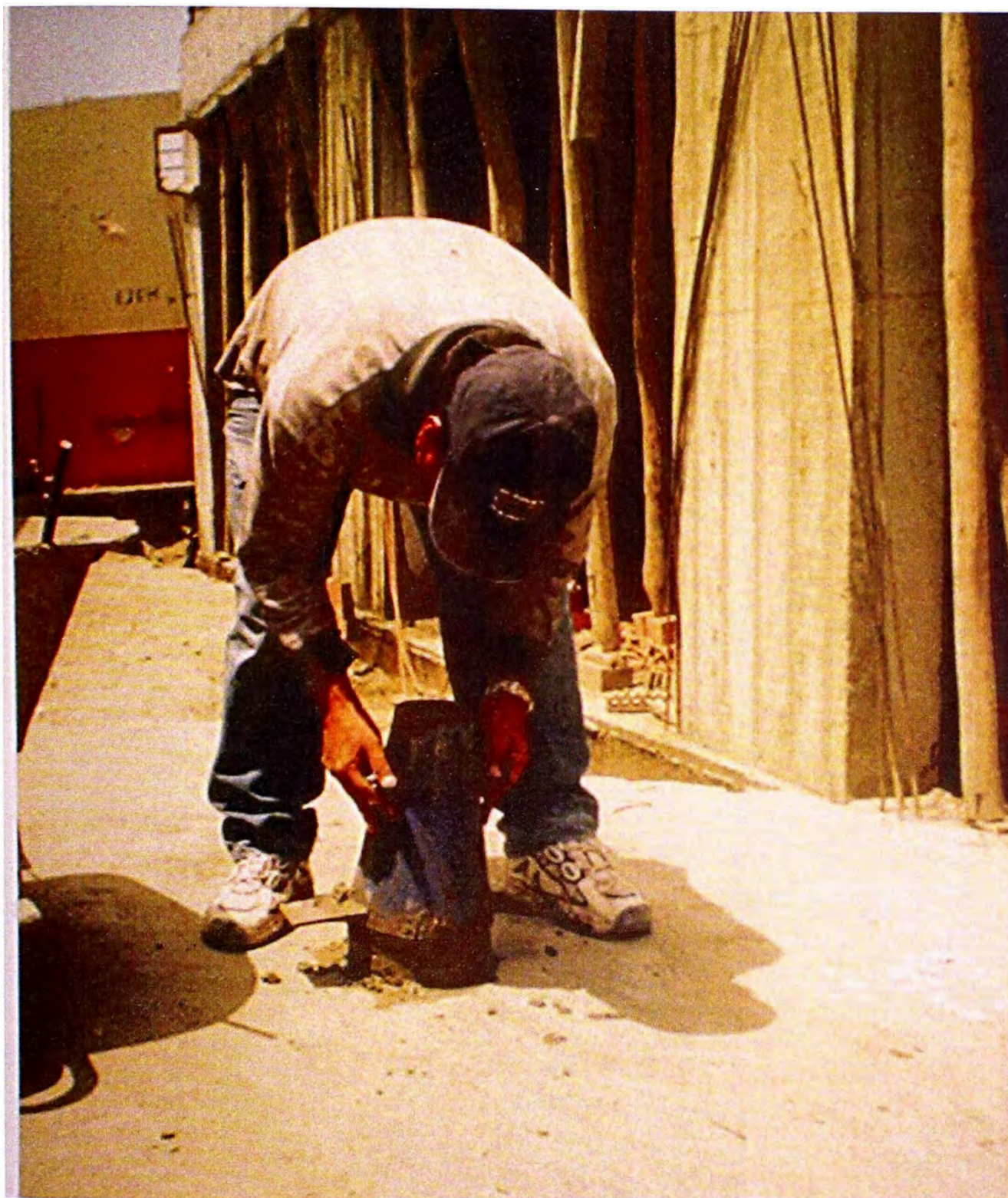
FOTO No. 19 : VISTA DE PRUEBA DE MEDICION DEL SLUMP DEL CONCRETO
