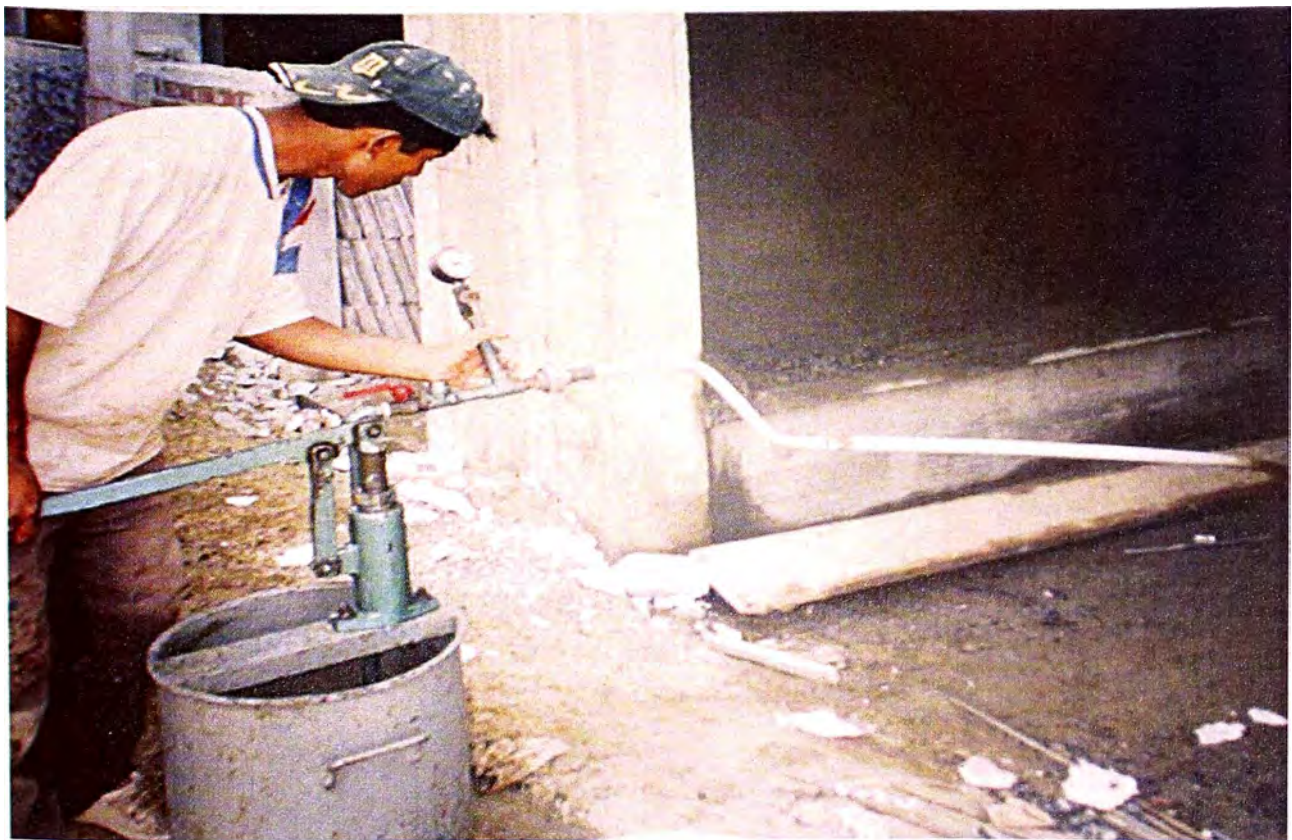
FOTO No. 38: VISTA DE PRUEBA HIDRAULICA EN TUBERIAS
