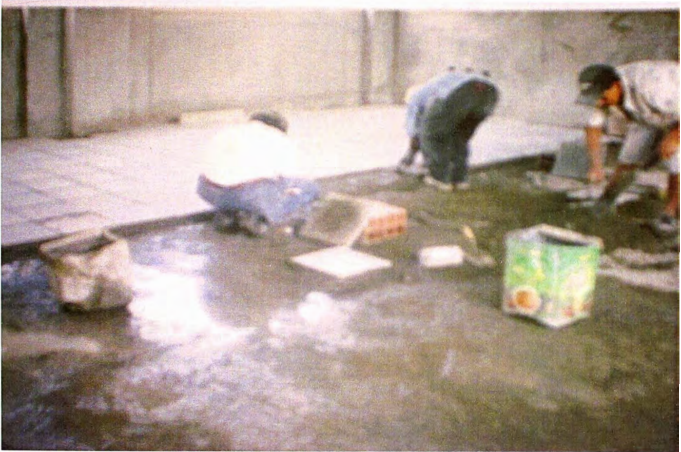
FOTO No. 33: VISTA DE COLOCACIÓN DE LOSETAS EN PISO
