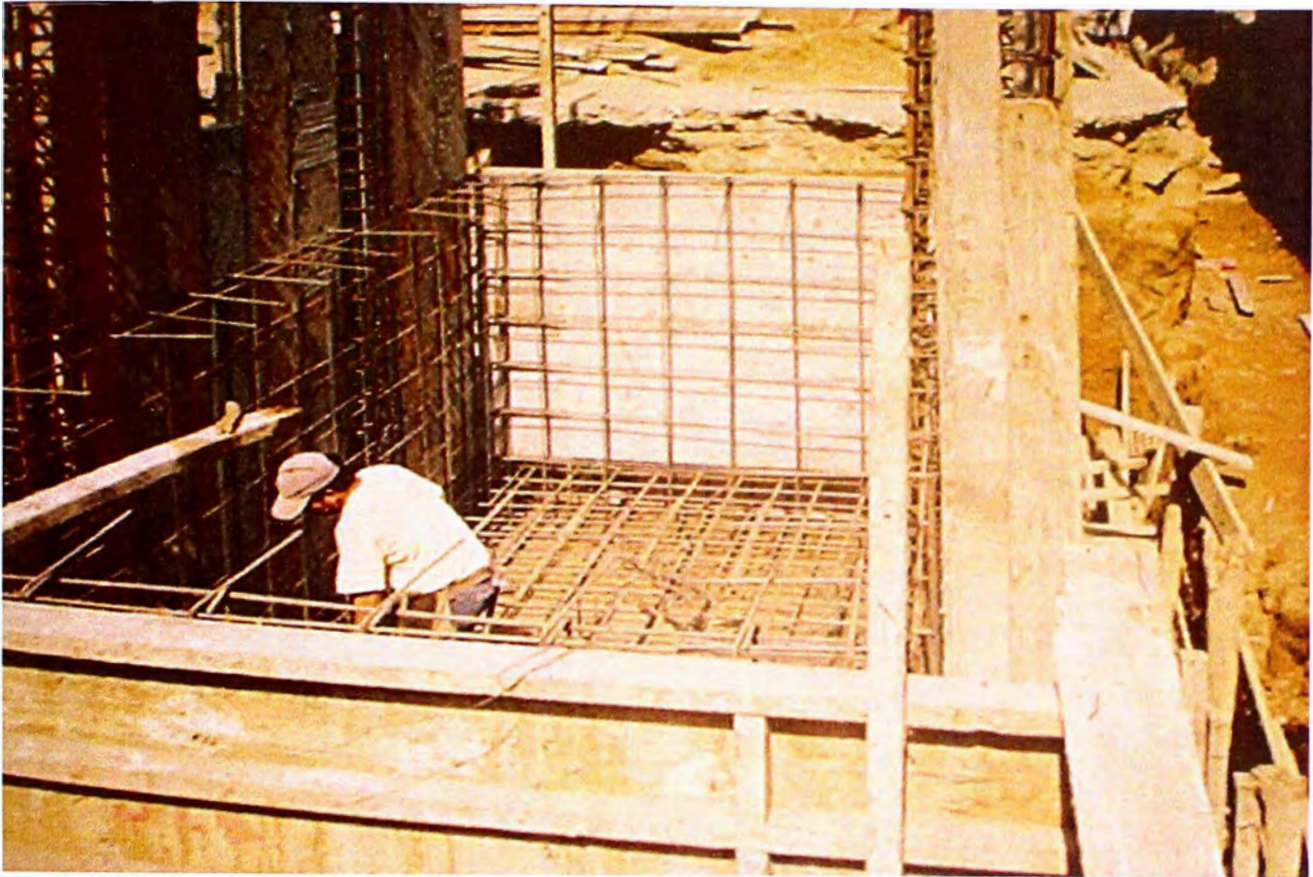
FOTO No. 40: ENCOFRADO Y ARMADURA DE PAREDES Y FONDO DE CISTERNA
