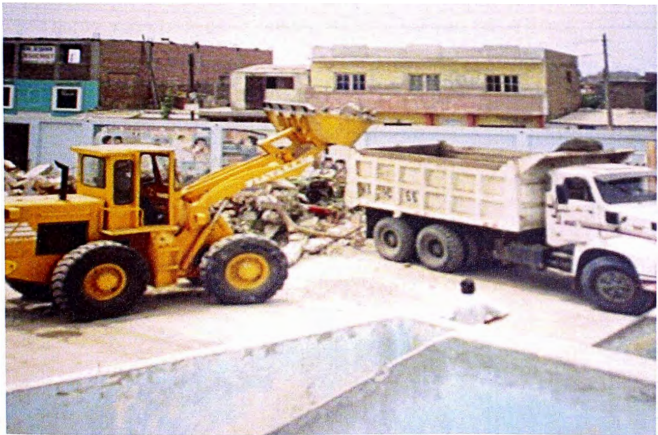
FOTO No. 08: ELIMINACION DE MATERIAL EXCEDENTE
