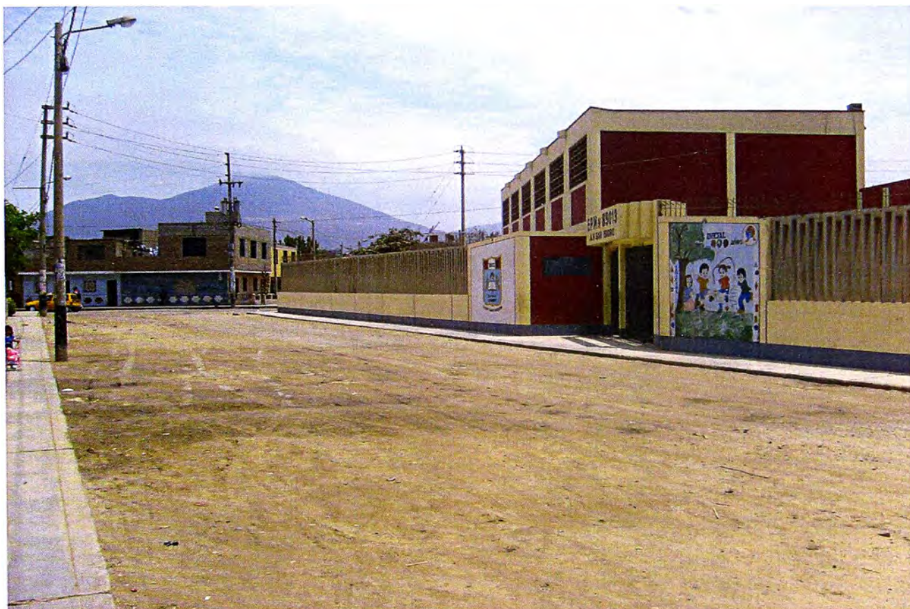
FOTO No. 49: FACHADA LATERAL DEL C.E. No. 89013 SAN ISIDRO - CONCLUIDA
