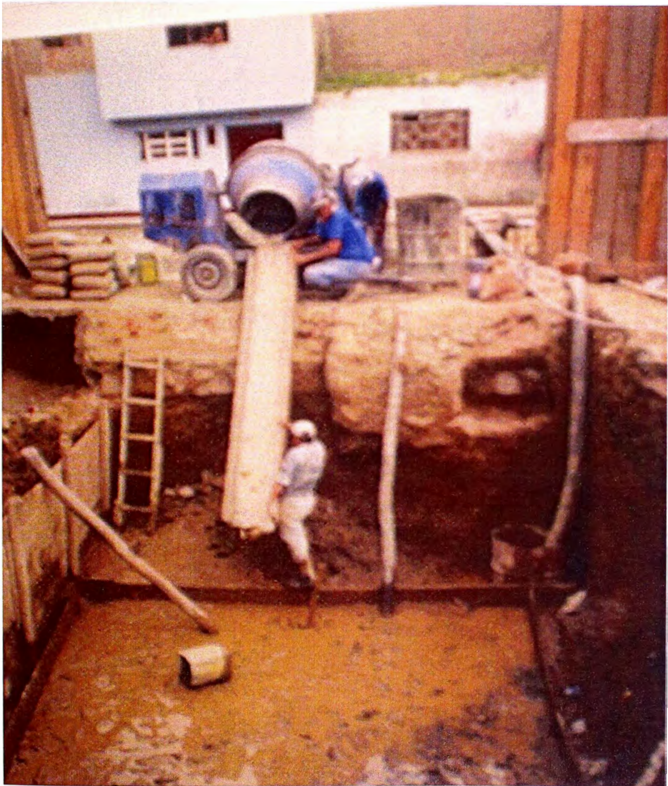
FOTO No. 39: VISTA DE VACEADO DE SOLADO EN CISTERNA
