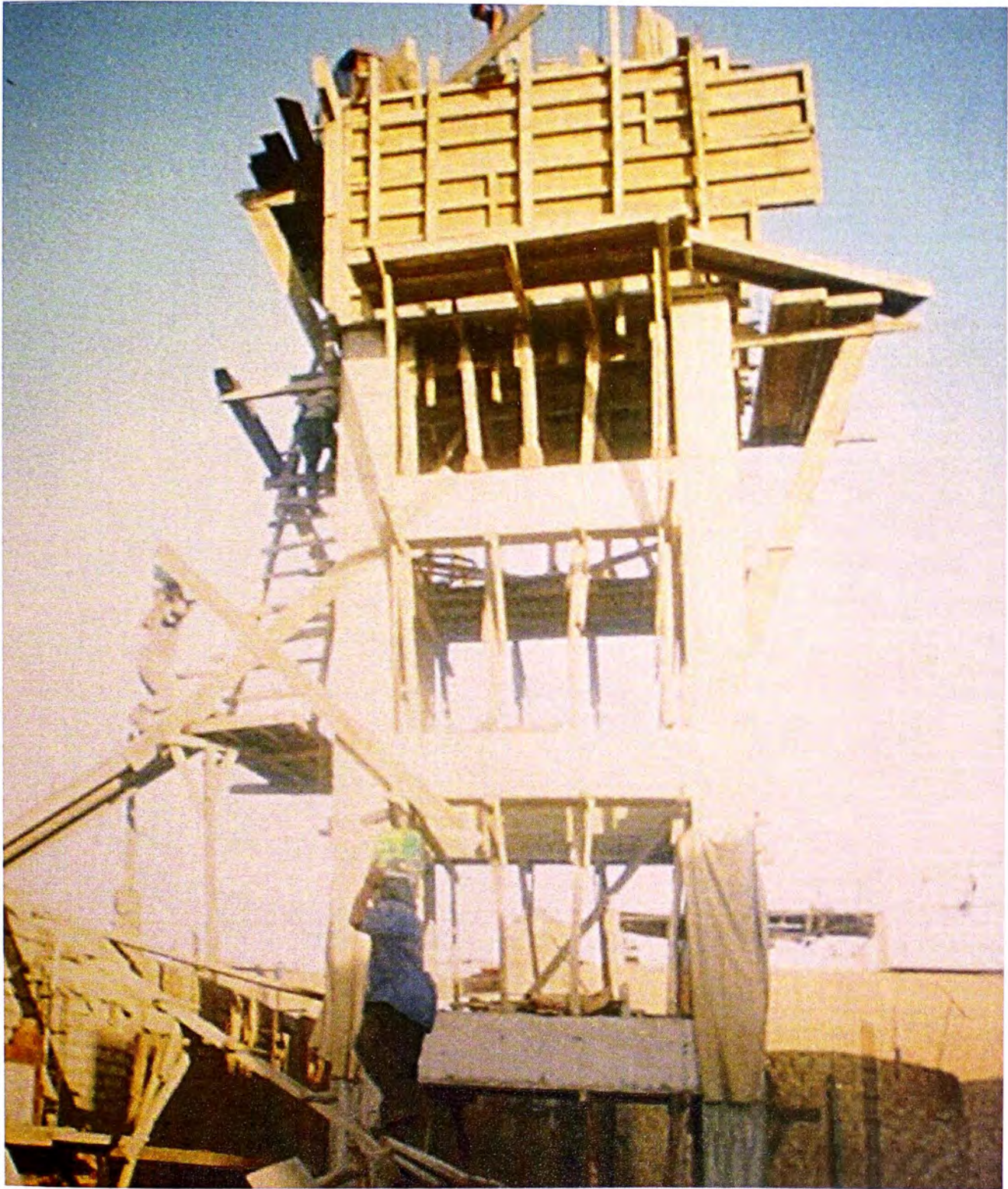
FOTO No. 43: VISTA DE ENCOFRADO Y VACEADO DE TANQUE ELEVADO
