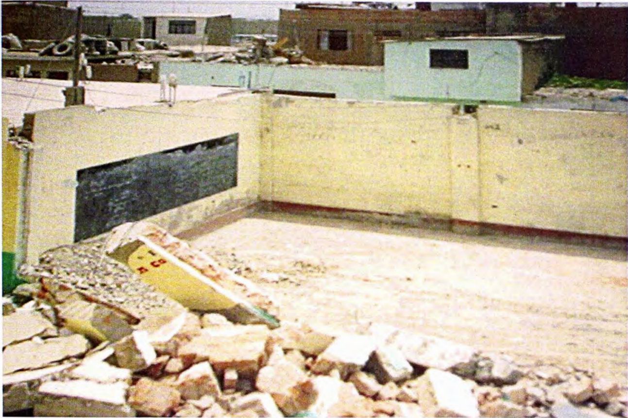
FOTO No. 07: AMONTONAMIENTO DE DEMOLICION PARA SER ELIMINADO
