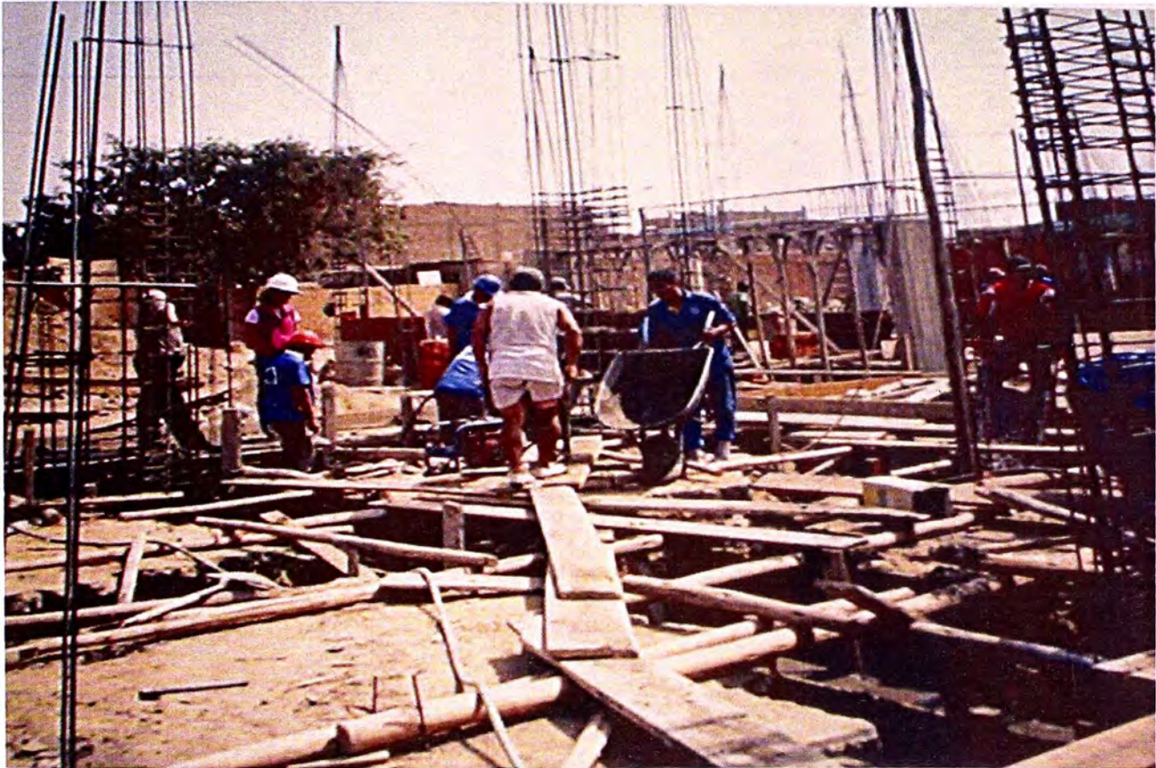
FOTO No. 13: VISTA DE VACEADO DE CIMENTACIONES
