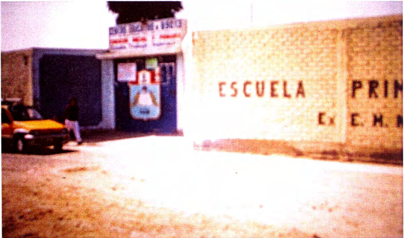
FOTO No. 01: VISTA DE PORTADA ANTIGUA DE INGRESO AL C.E.
