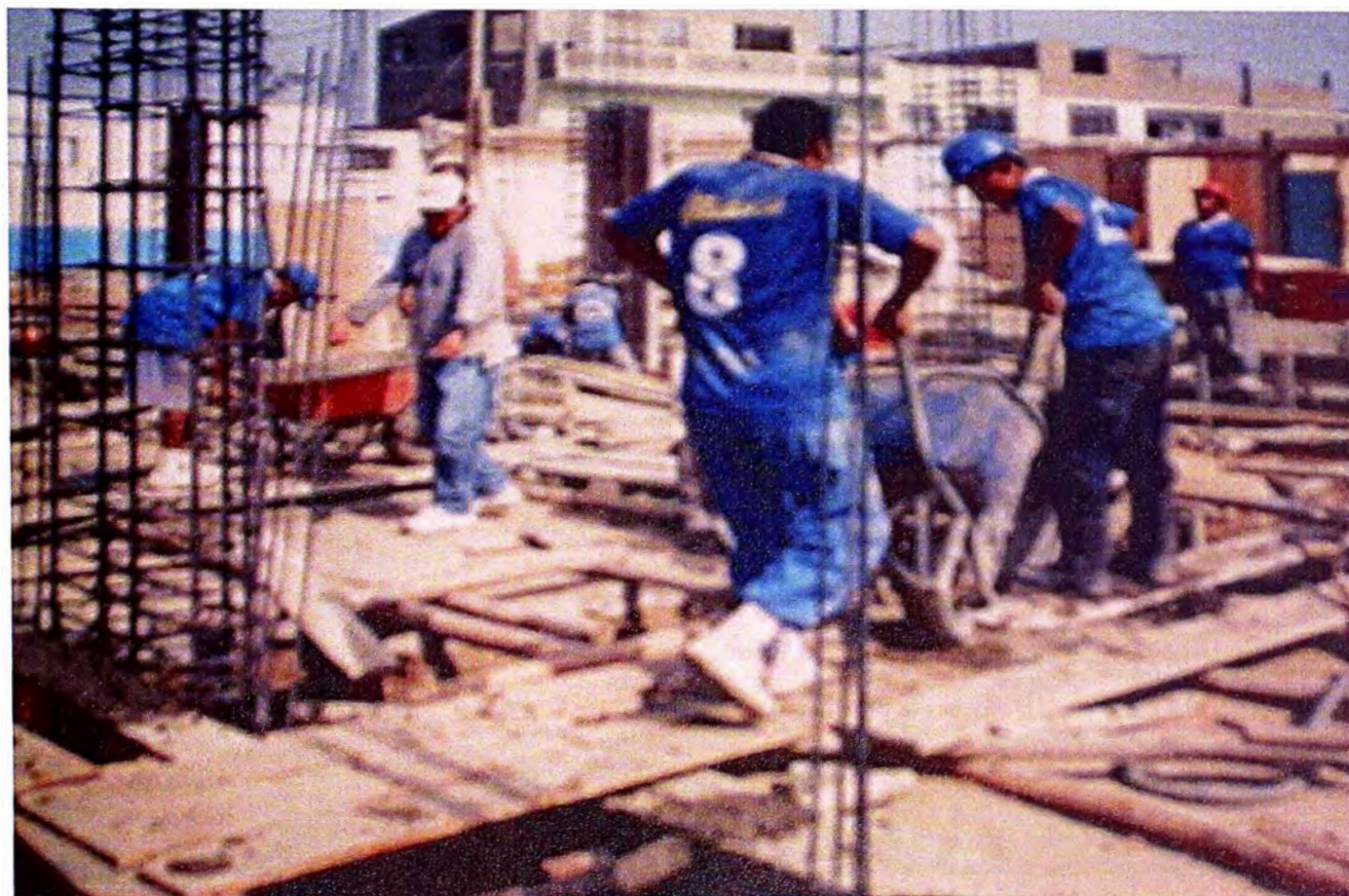
FOTO No. 12: VISTA DE VACEADO DE CIMENTACIONES
