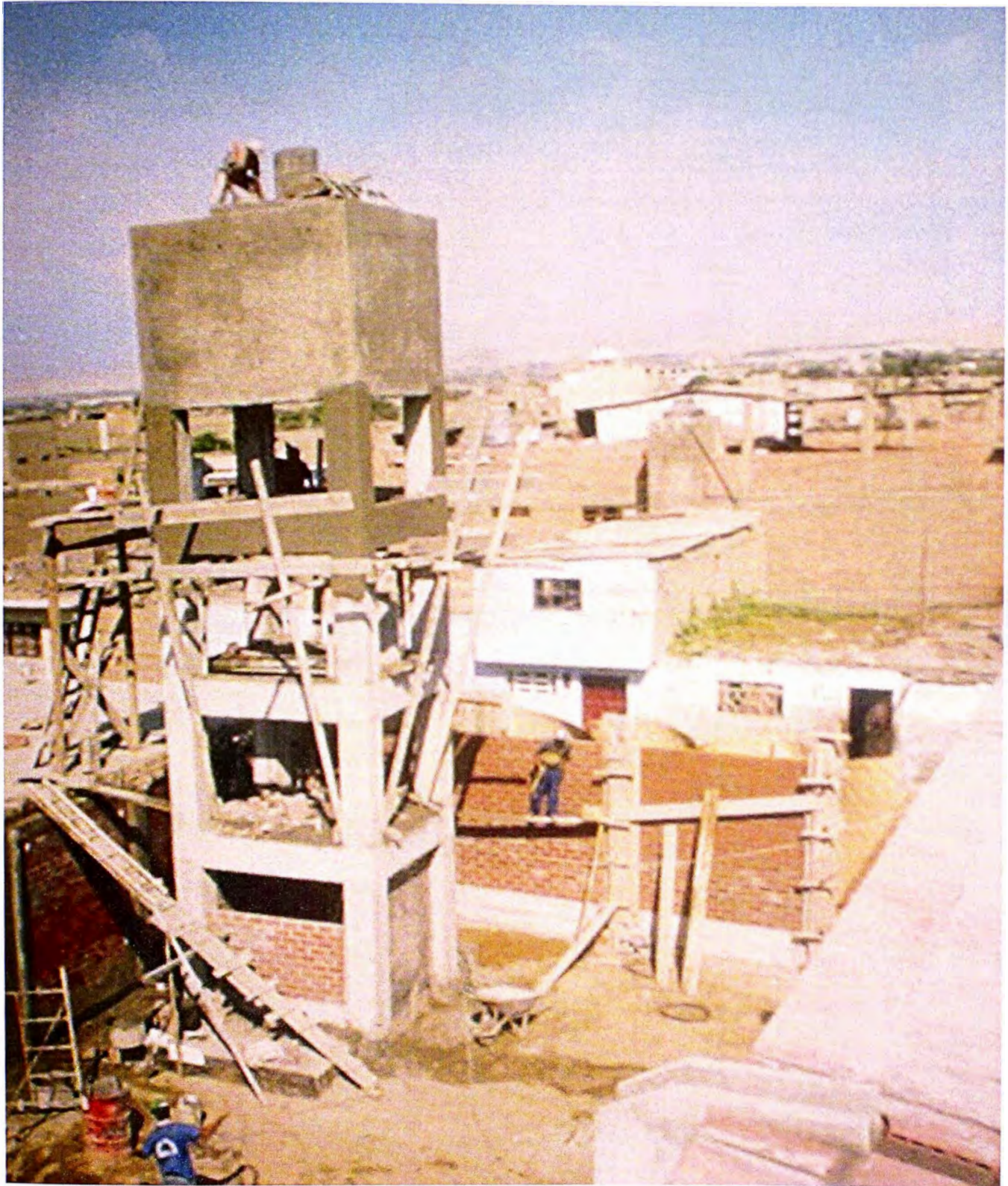
FOTO No. 44: VISTA DE TARRAJEO DE TANQUE ELEVADO
