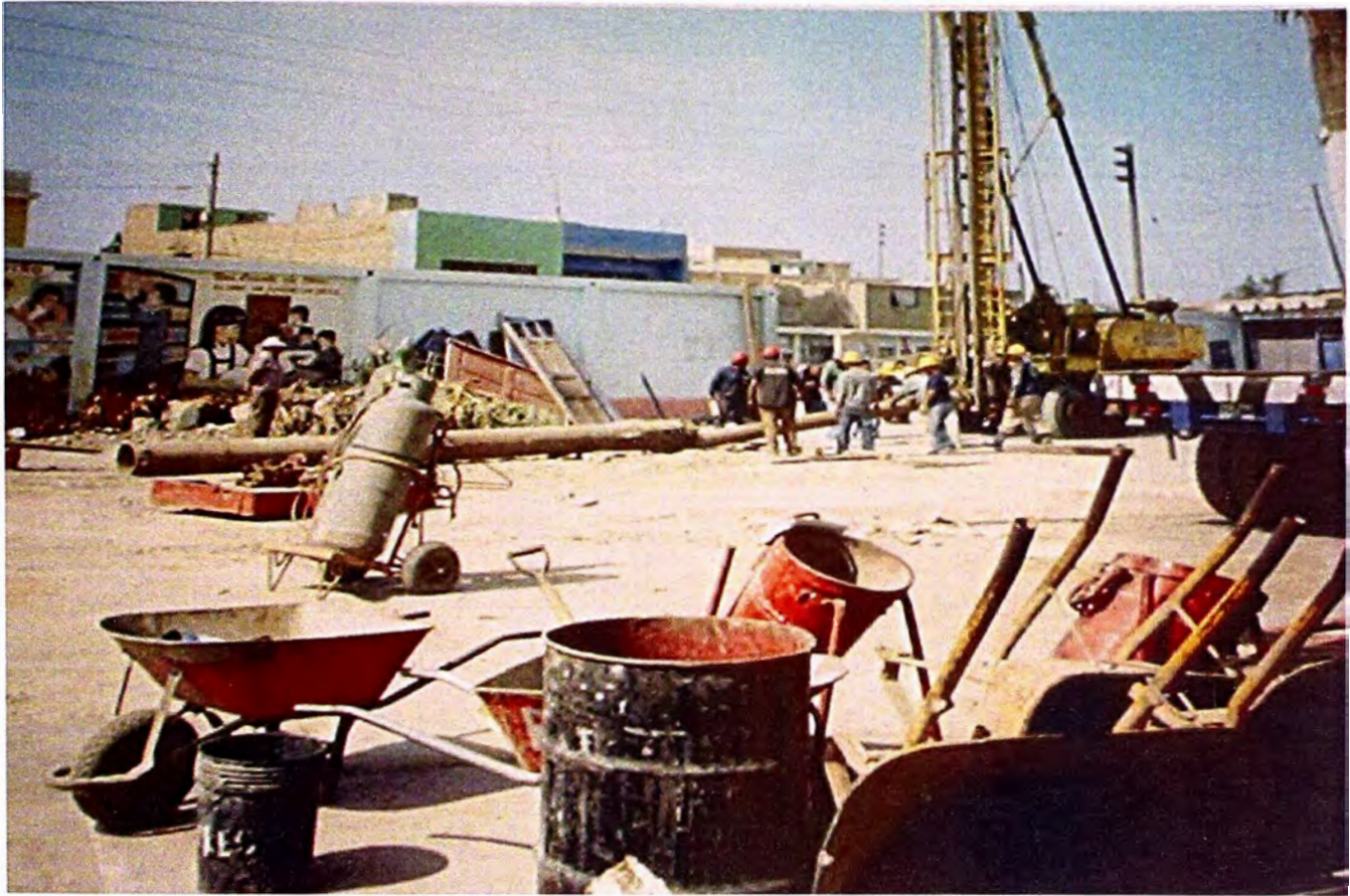
FOTO No. 09: VISTA DE EQUIPO Y HERRAMIENTAS USADOS EN PILOTAJE
