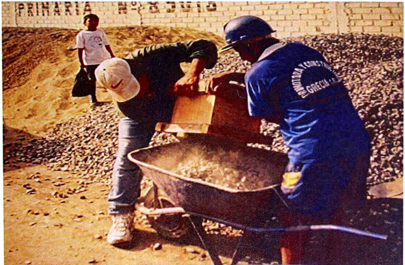
FOTO No. 17: VISTA DE SELECCIÓN Y DOSIFICACION DE AGREGADOS
