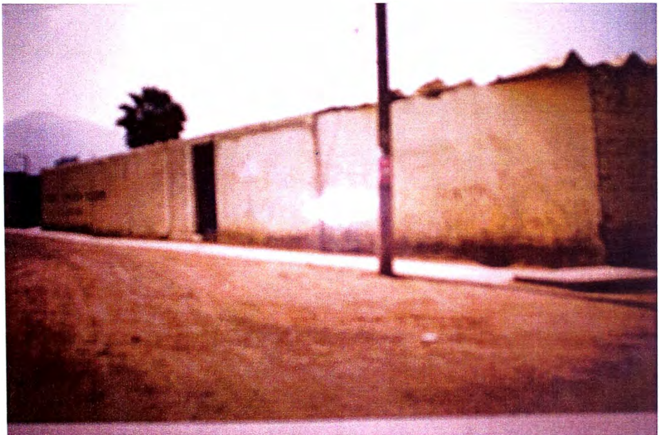
FOTO No. 02: VISTA LATERAL ANTIGUA DEL C.E.
