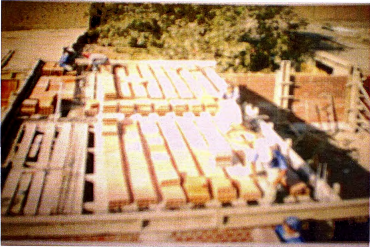
FOTO No. 27: VISTA DE COLOCACION DE LADRILLO DE TECHO EN AULAS
