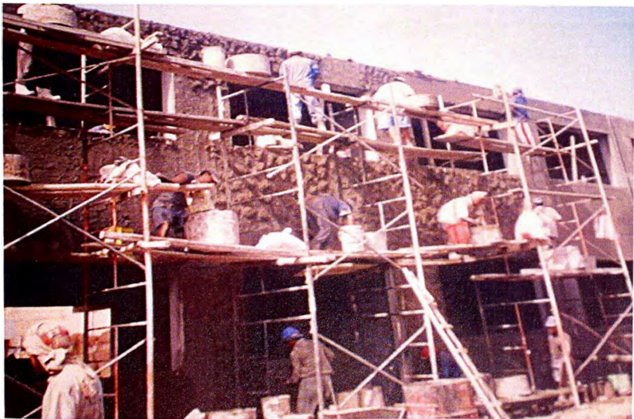
FOTO No. 30: VISTA DE TARRAJEO DE MUROS EXTERIOES EN AMBOS NIVELES
