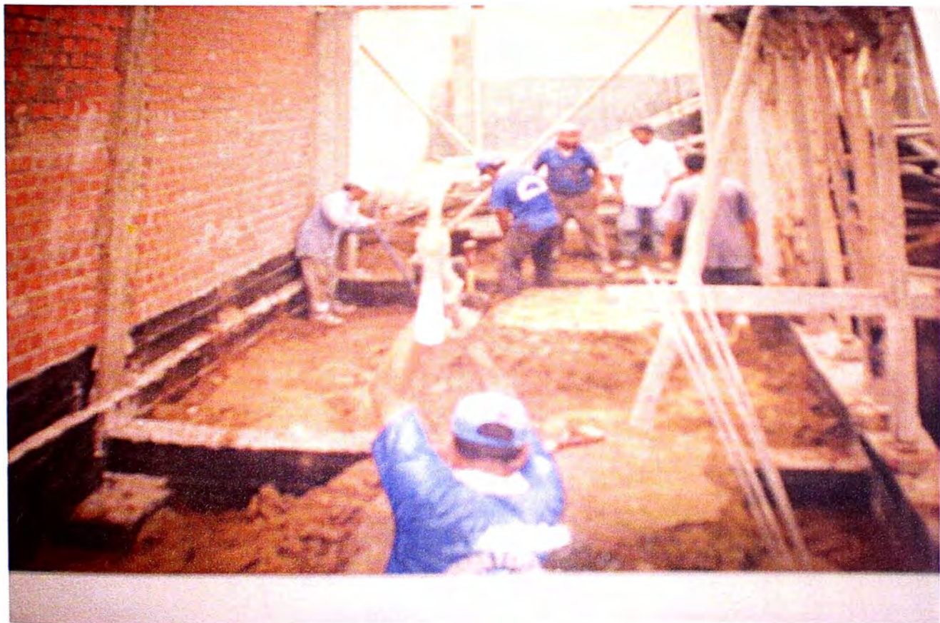
FOTO No. 24: VISTA DE CORTE PARA RELLENO CON MATERIAL AFIRMADO
