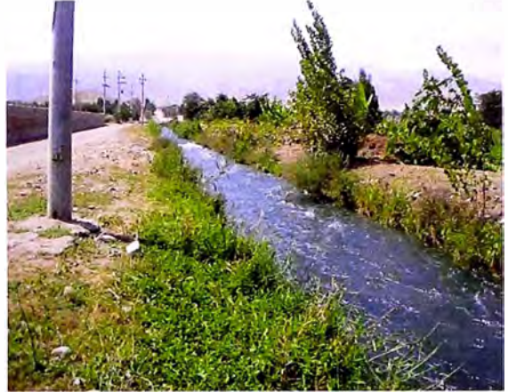
IMAGEN 2.11. CANAL LATERAL B
