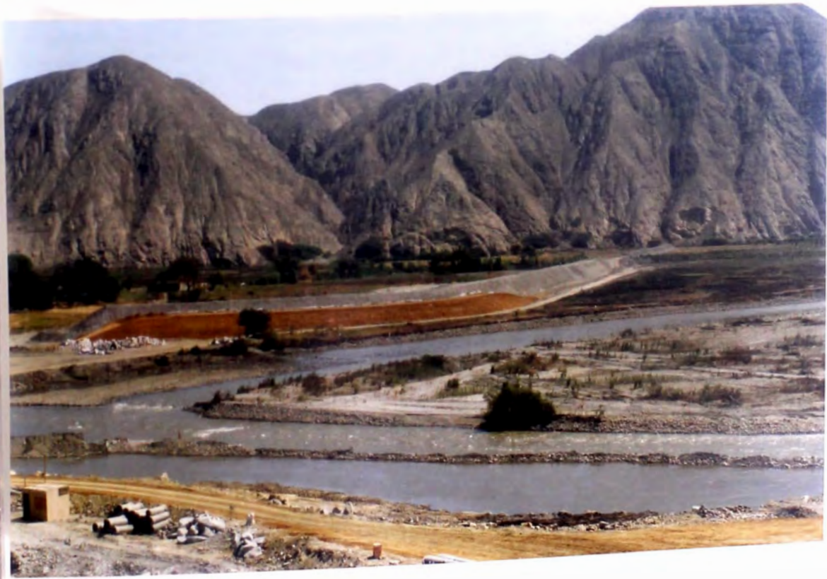
FOTO Nro. 2 TRABAJOS EN DIQUE DE MARGEN DERECHA
