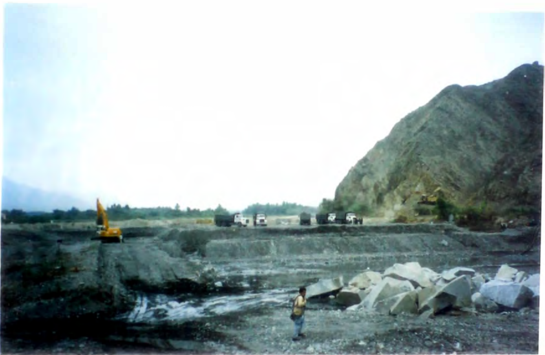
OTO Nro. 1 : TRABAJOS DE MOVIMIENTO DE TIERRAS EN BARRAJE MOVIL AL FONDO EXCAVACIONES PARA INCRUSTAR MURO IZQUIERDO EN MACIZO ROCOSO
