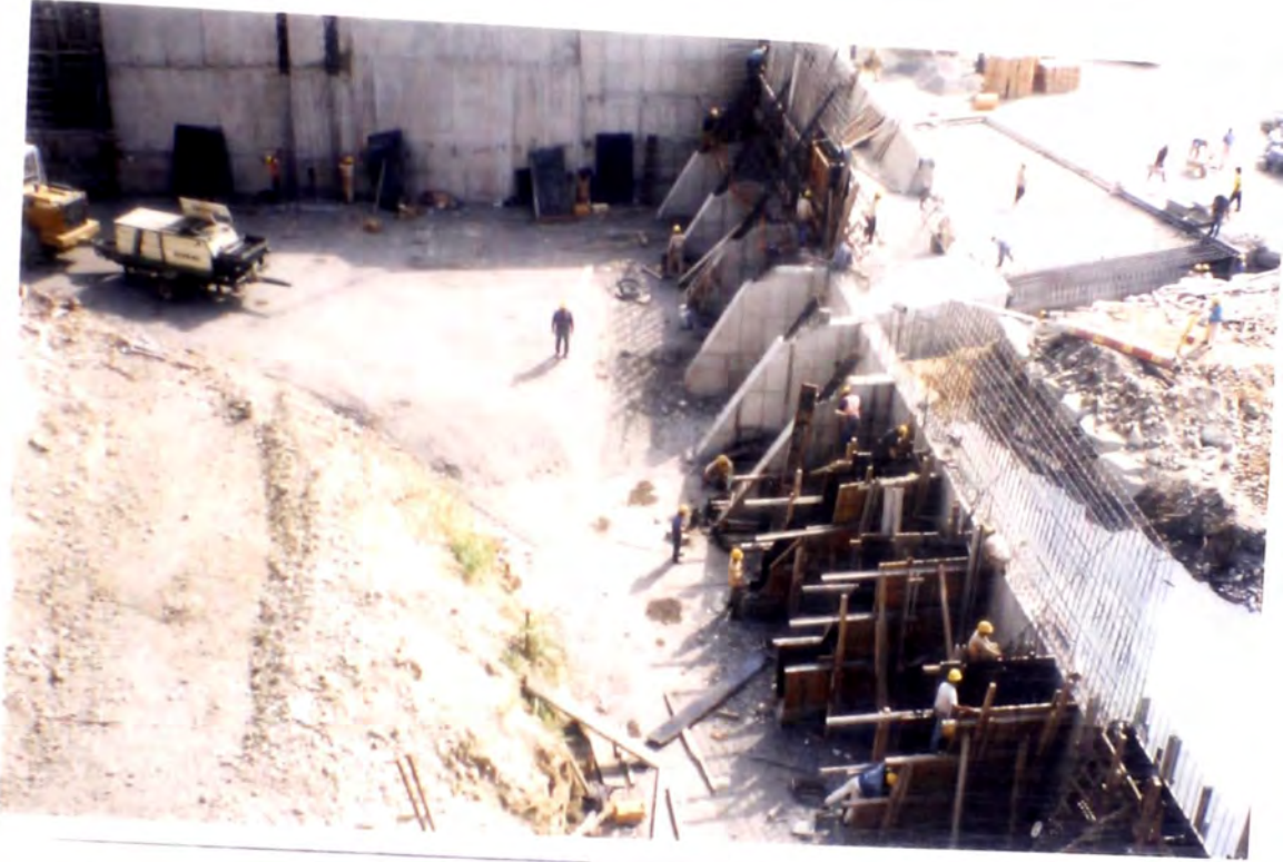
FOTO Nro. 1 :: TRABAJOS EN MURO IZQUIERDO AGUAS ARRIBA
