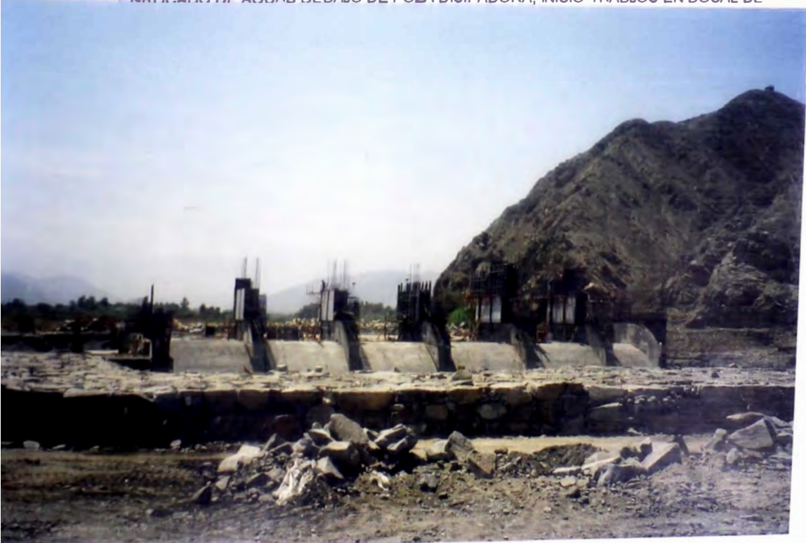
FOTO Nro. 1 : PILARES DE BARRAJE MOVIL ENROCADOS AGUAS ARRIBA DE LOSAS DE APROXIMACION ENROCADO DE AGUAS DEBAJO DE POZA DISIPADORA, INICIO TRABJOS EN BOCAL DE
