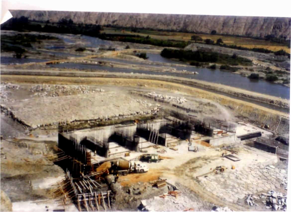
FOTO Nro. 1 : PILARES DE BARRAJE MOVIL ENROCADOS AGUAS ARRIBA DE LOSAS DE APROXIMACION ENROCADO DE AGUAS DEBAJO DE POZA DISIPADORA, INICIO TRABJOS EN BOCAL DE
