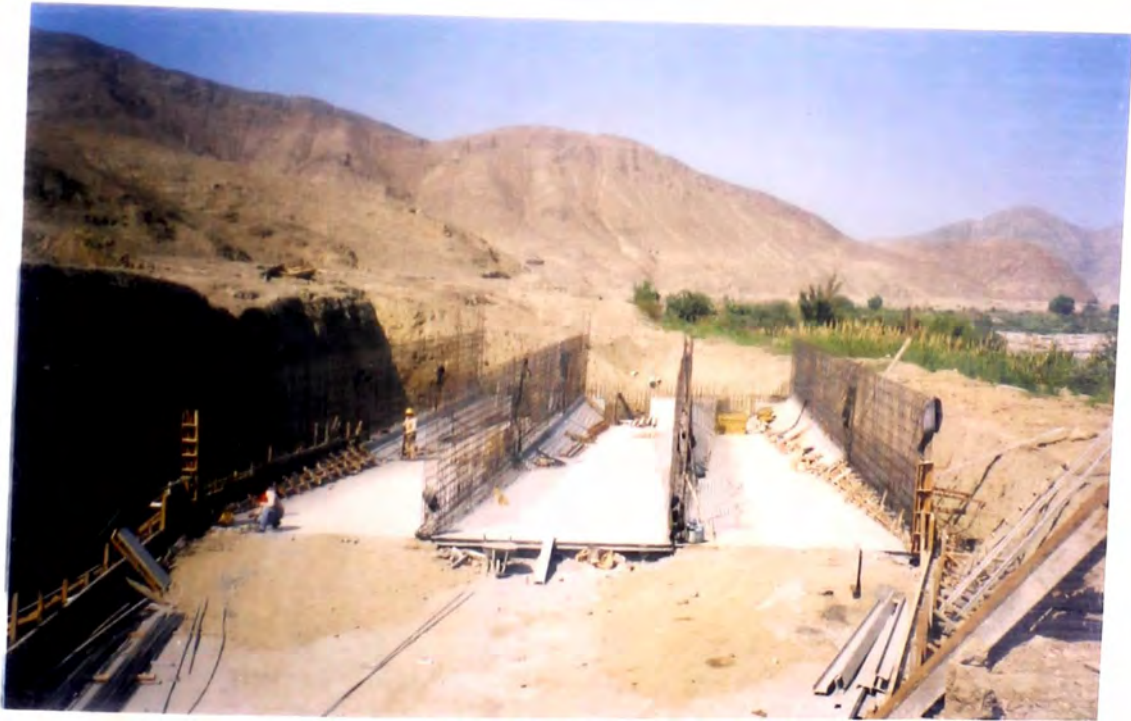
FOTO Nro 2 : TRABAJOS EN DESARENADOR PARTE CENTRAL
