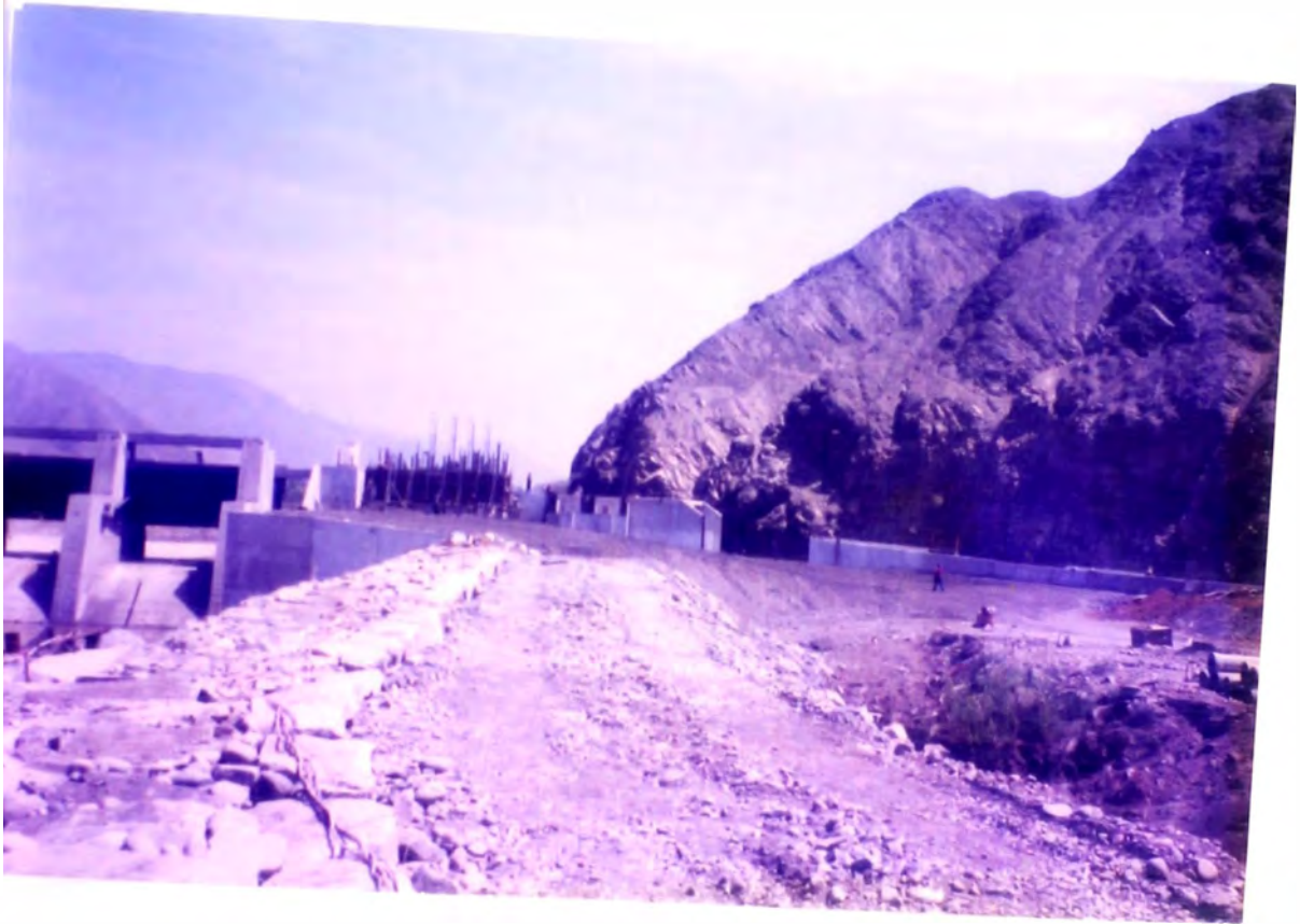
OTO Nro. 1 : AL FONDO SE VE LA BOCAL DE CAPTACION Y HACIA EL LADO DERECHO EL CANAL ADUCTOR
