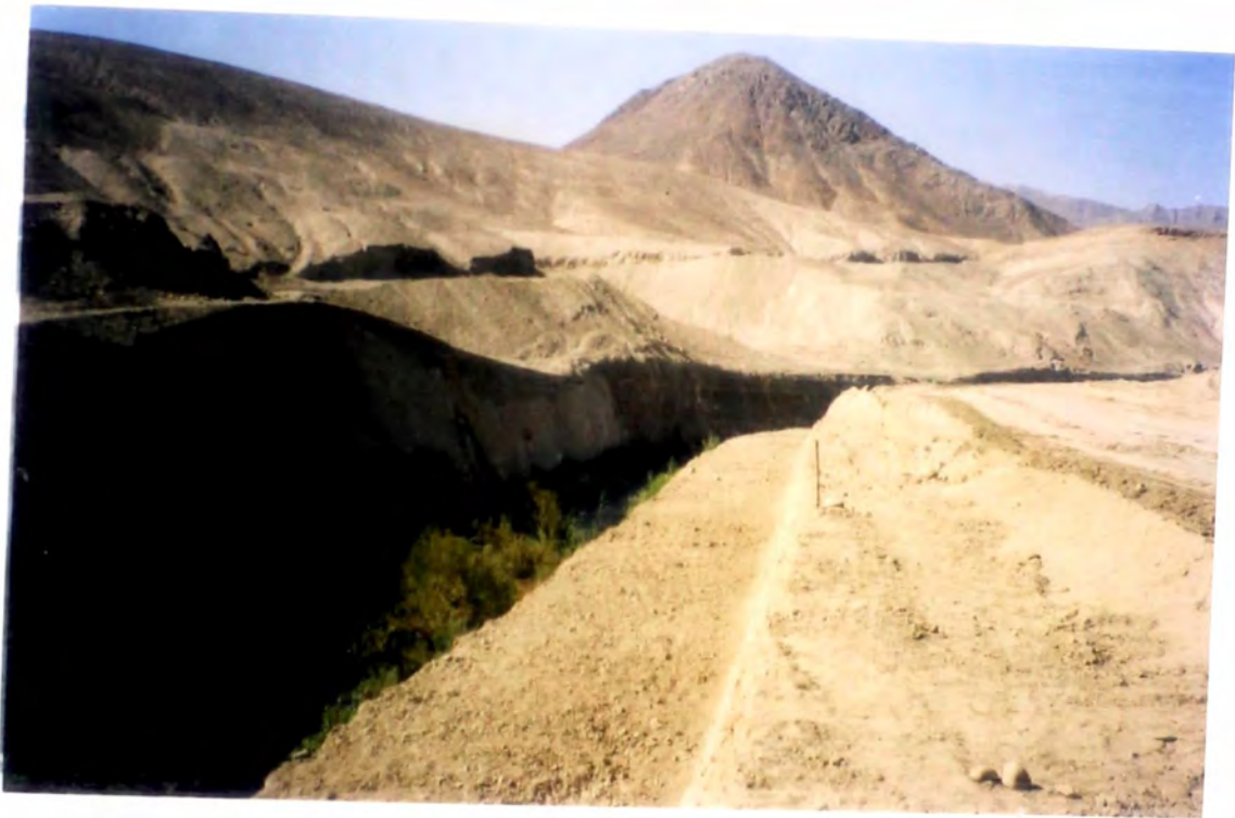
FOTO Nro. 1 : MOVIMIENTO DE TIERRAS PARA CAMINO DE SERVICIO DE CANAL
