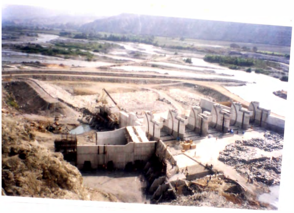
Nro 1 : TRABAJOS EN BOCAL DE CAPTACION Y MURO IZQUIERDO
