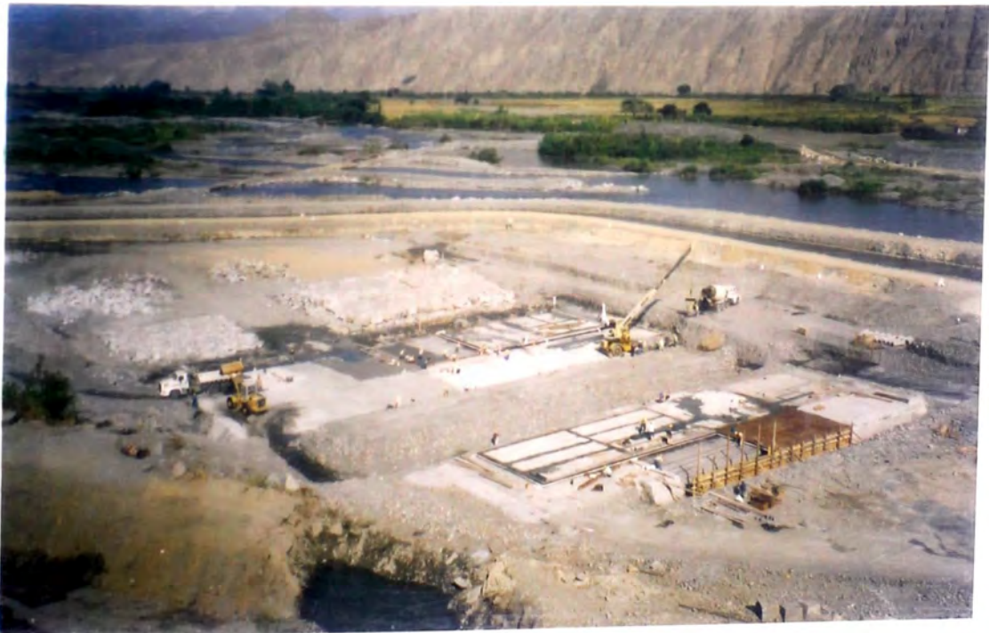
OTO Nro. 2 : TRABAJOS DE CONCRETO Y ENCOFRADO EN LOSAS DE APROXIMACION TRABAJOS DE CONCRETADO EN LOSAS POZA DISIPADORA
