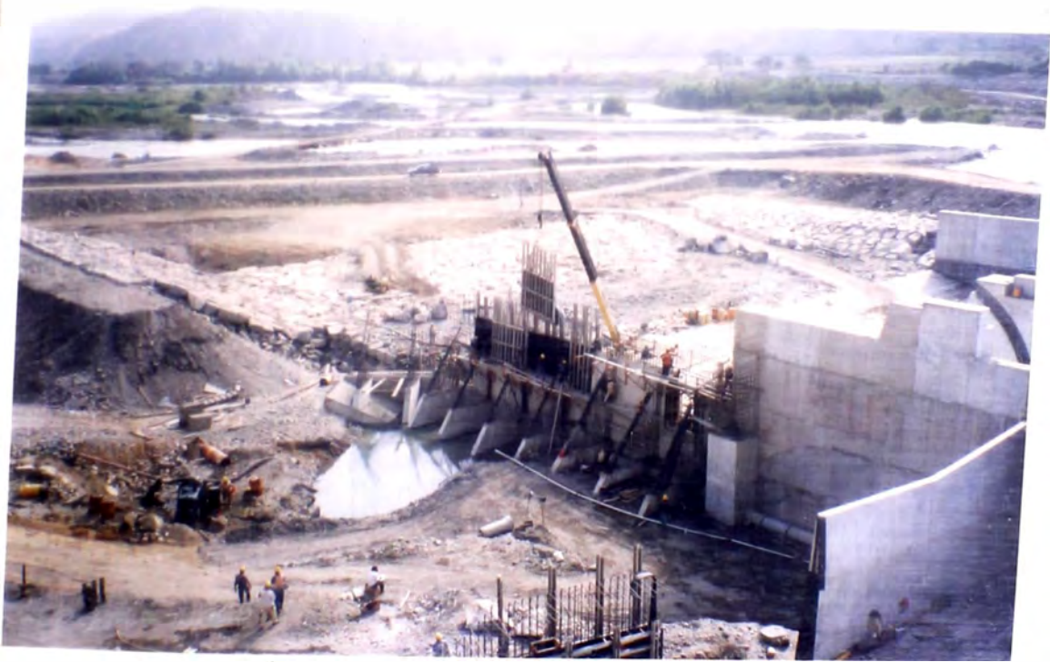
FOTO Nro. 2 :: TRABAJOS EN MURO IZQUIERDO AGUAS ABAJO
