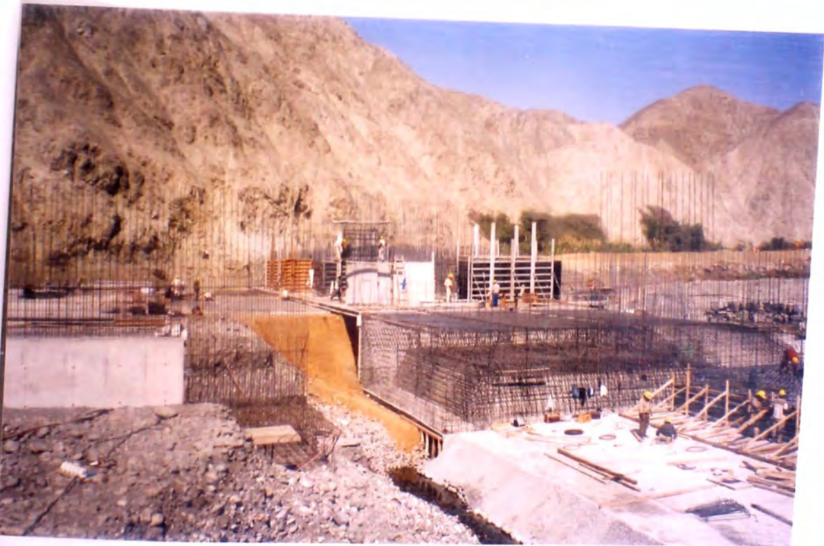
FOTO Nro. 2 ZAPATA DE ZONAN DE PILARES BARRAJE MOVIL AL FONDO INICIO DE PRIMEROS PILARES Y TRABAJOS EN BLOQUE 12 DEL B.FIJO
