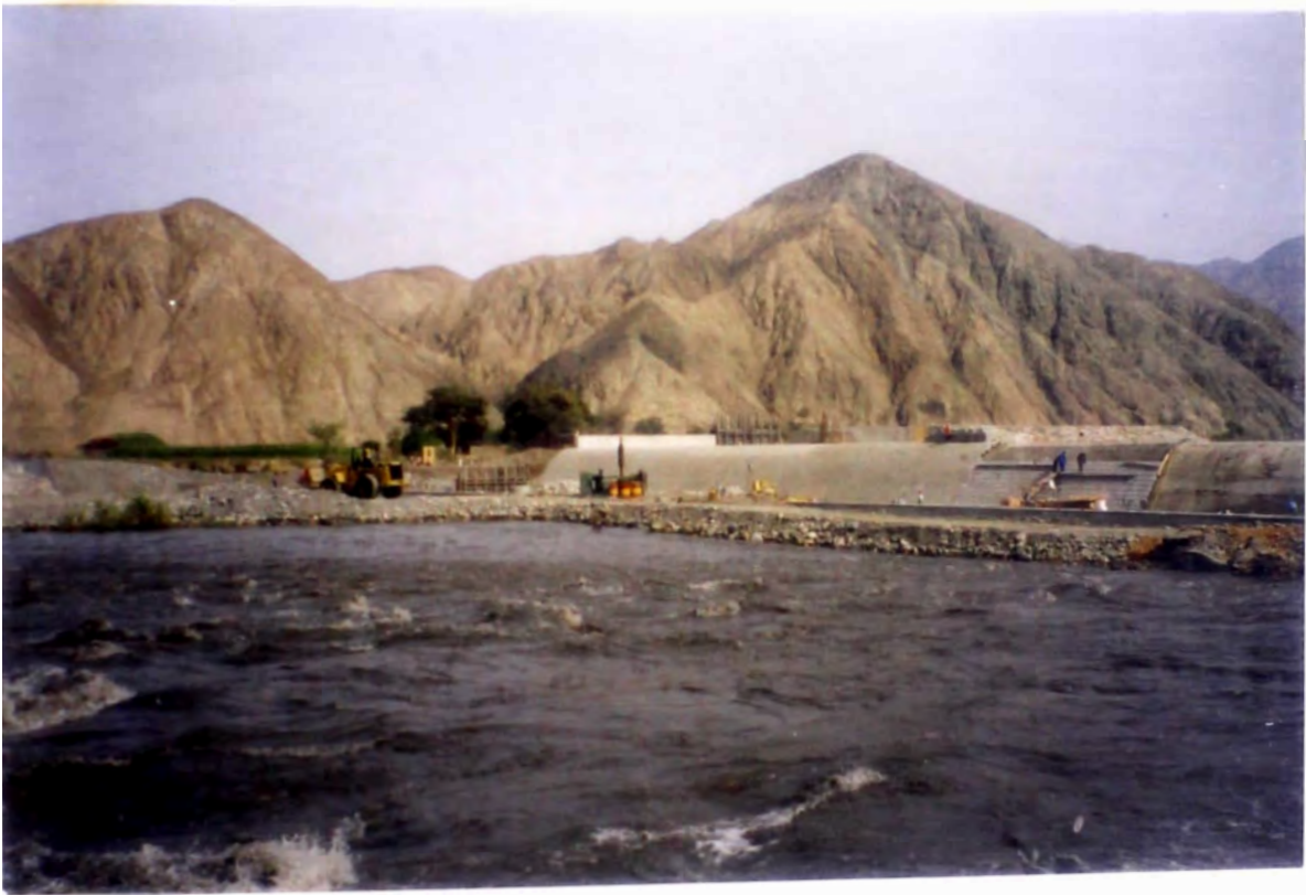
FOTO Nro. 1 ENCHAPE DE PIEDRA EN BARRAJE FIJO
