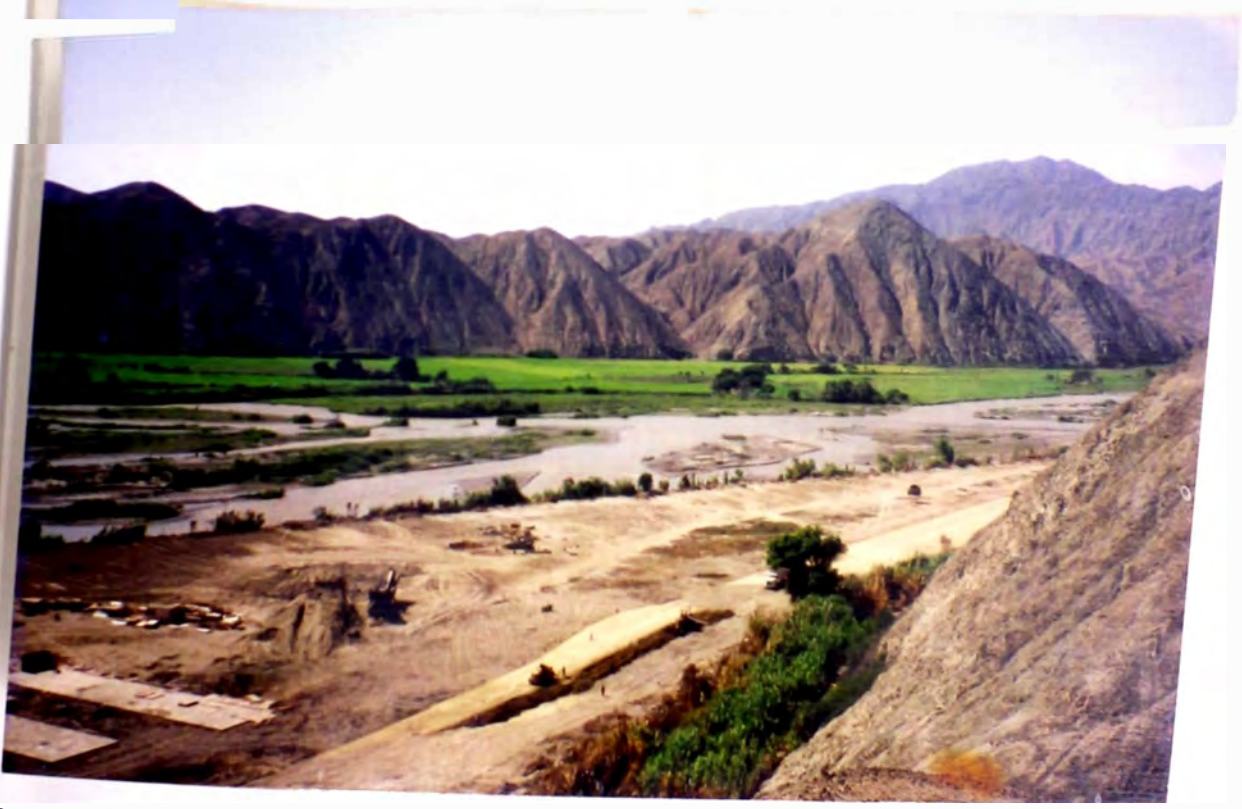
FOTO Nro 2 ZONA DONDE SE UBICARA LA BOCATOMA Y PARTE DE LA PLATAFORMA DEL CANAL ADUCTOR
