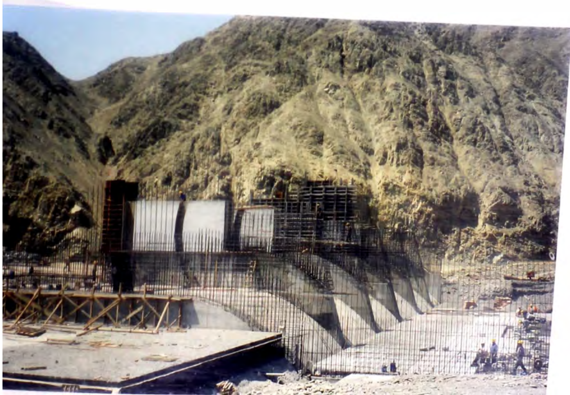
FOTO Nro. 2 : VISTA DE PILARES AGUAS ABAJO, SE OBSERVA LAS ETAPAS DE CONCRETADO
