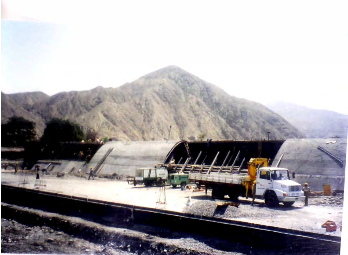
FOTO Nro. 2 : BARRAJE FIJO VISTO AGUAS ABAJO
