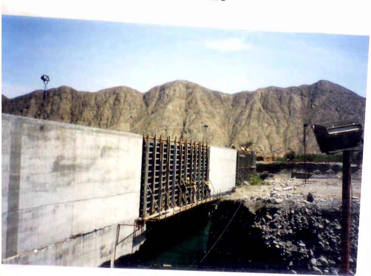
FOTO Nro. 1 : BARRAJE FIJO VISTO AGUAS ARRIBA
