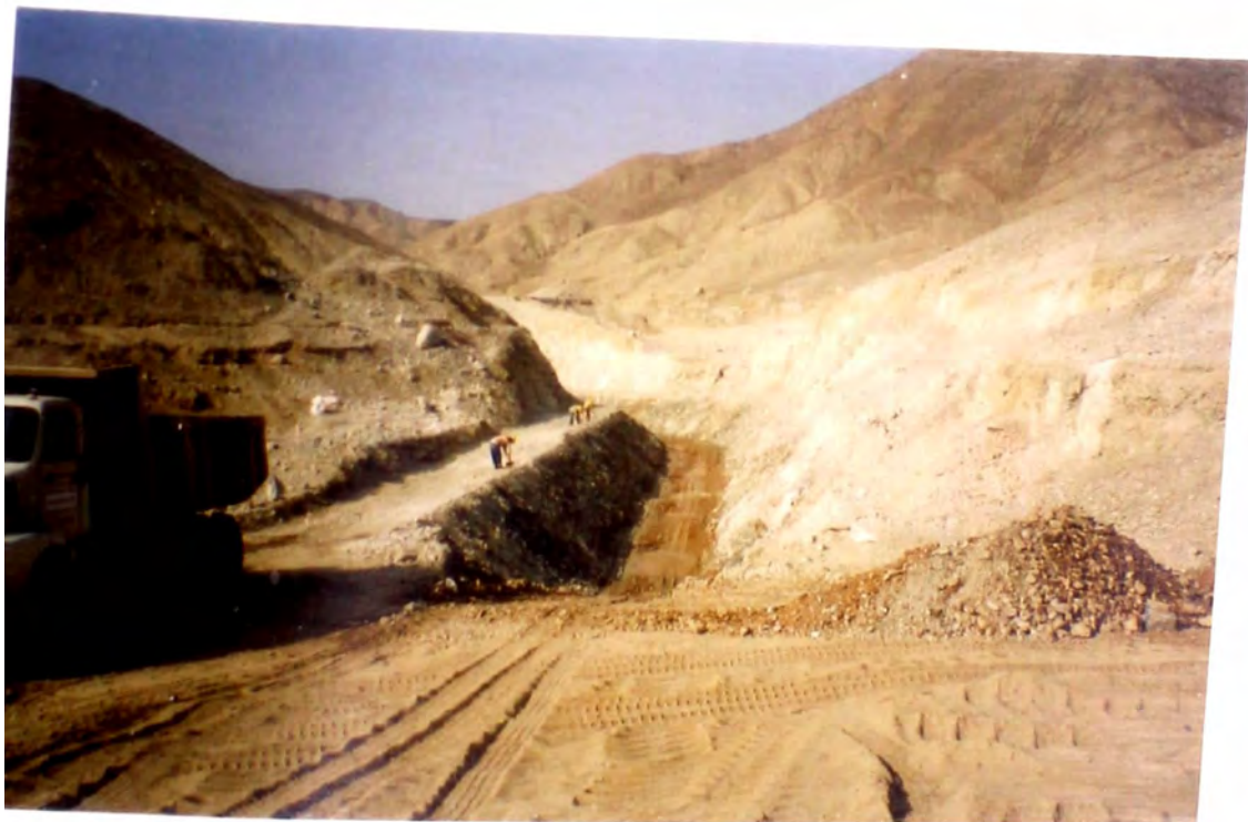
FOTO Nro. 2 : EXCAVACION DE CAJA DE CANAL
