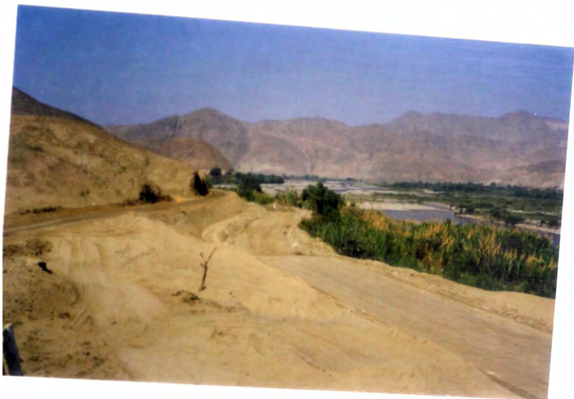
FOTO Nro. 1 : PLATAFORMA DEL CANAL ADUCTOR
