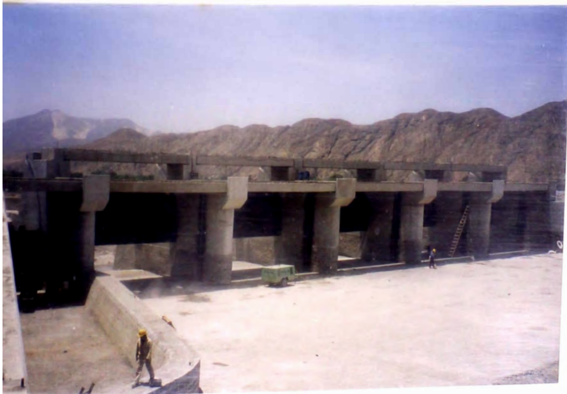
FOTO Nro. 2 : ZONA DE PILARES COMPLETO CON PUENTE DE MANIOBRAS Y COMPUERTAS LOSAS DE APROXIMACION CON ENCHAPE DE PIEDRA CONLUIDO
