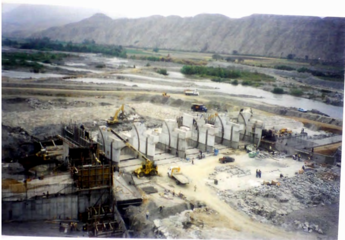
FOTO Nro. 1 : PILARES DE BARRAJE MOVIL CONCLUIDOS, FALTA PUENTE DE MANIOBRA LADO IZQUIERDO TRABAJOS EN BOCAL DE CAPTACION
