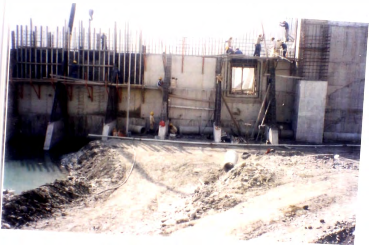
○ Nro. 1 TRABAJOS EN MURO IZQUIERDO AGUAS ABAJO, SE VE LA SALIDA DEL CANAL DESRIPIADOR
