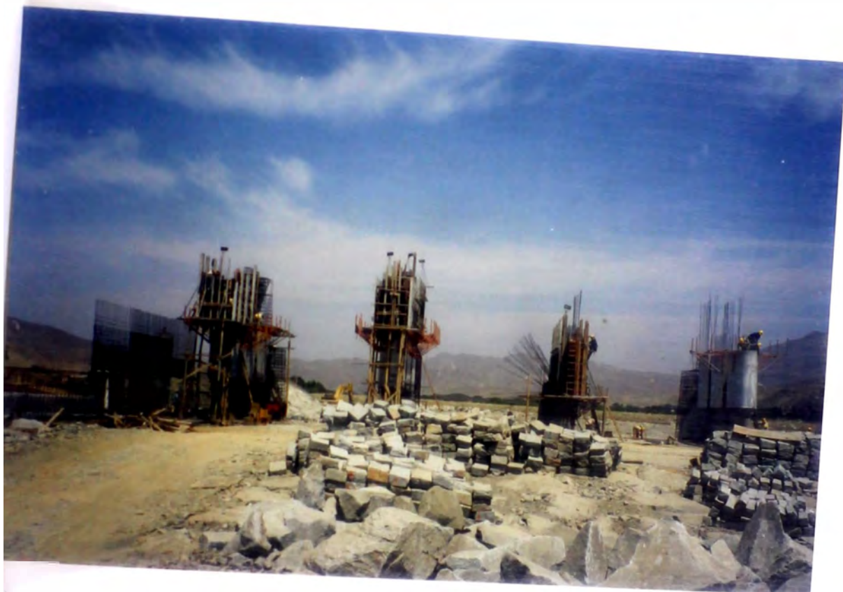
FOTO Nro. 1 : TRABAJOS DE ARMADURA Y ENCOFRADO EN LOS PILARES BARRAJE MOVIL
