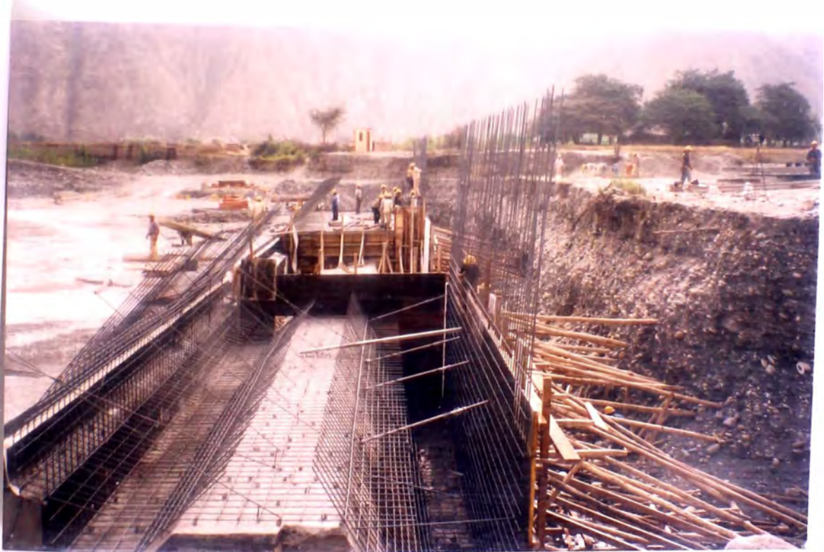
FOTO Nro. 2 : TRABAJOS EN LA ETAPA 1 DEL UN BLOCK DE BARRAJE FIJO
