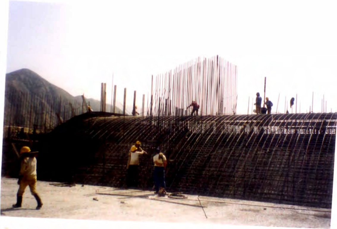
FOTO Nro. 1 ARMADURA DE LA ZAPATA DE LOS PILARES BARRAJE MOVIL
