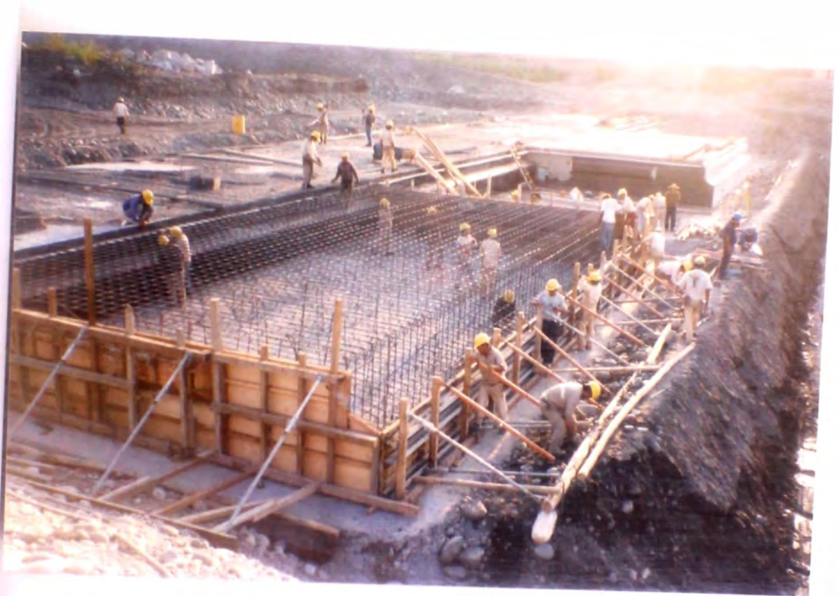
FOTO Nro. 1 : TRABAJOS EN ETAPA 5 DE UN BLOCK DEL BARRAJE FIJO
