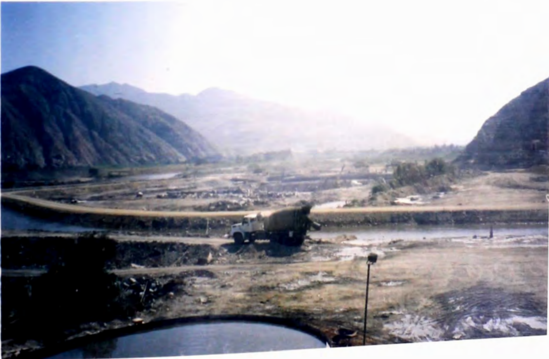
FOTO Nro. 2 ATAGUIAS AGUAS ABAJO DEL BARRAJE MOVIL E INICIO DE TRABAJO EN EL MISMO LADO DERECHO MACIZO ROCOSO DONDE SE INCRUSTARA EL MURO IZQUIERDO
