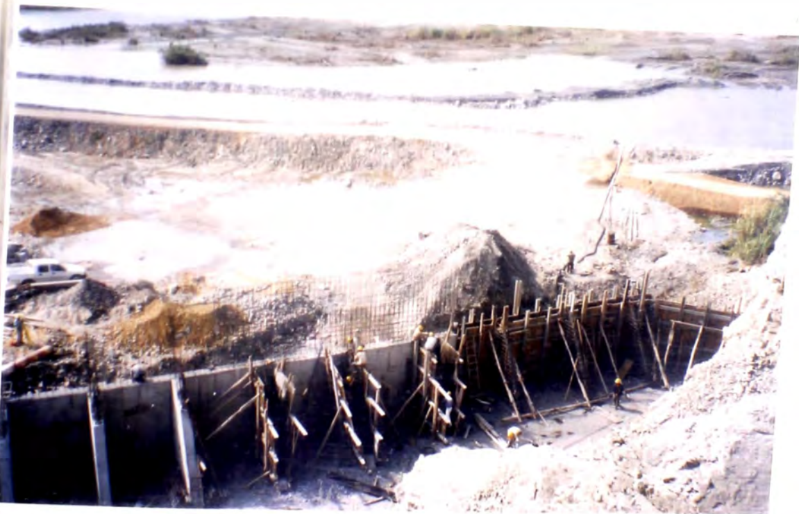
○ Nro. 2 TRABAJOS EN MURO IZQUIERDO AGUAS ARRIBA EMPALME CON MACIZO ROCOSO
