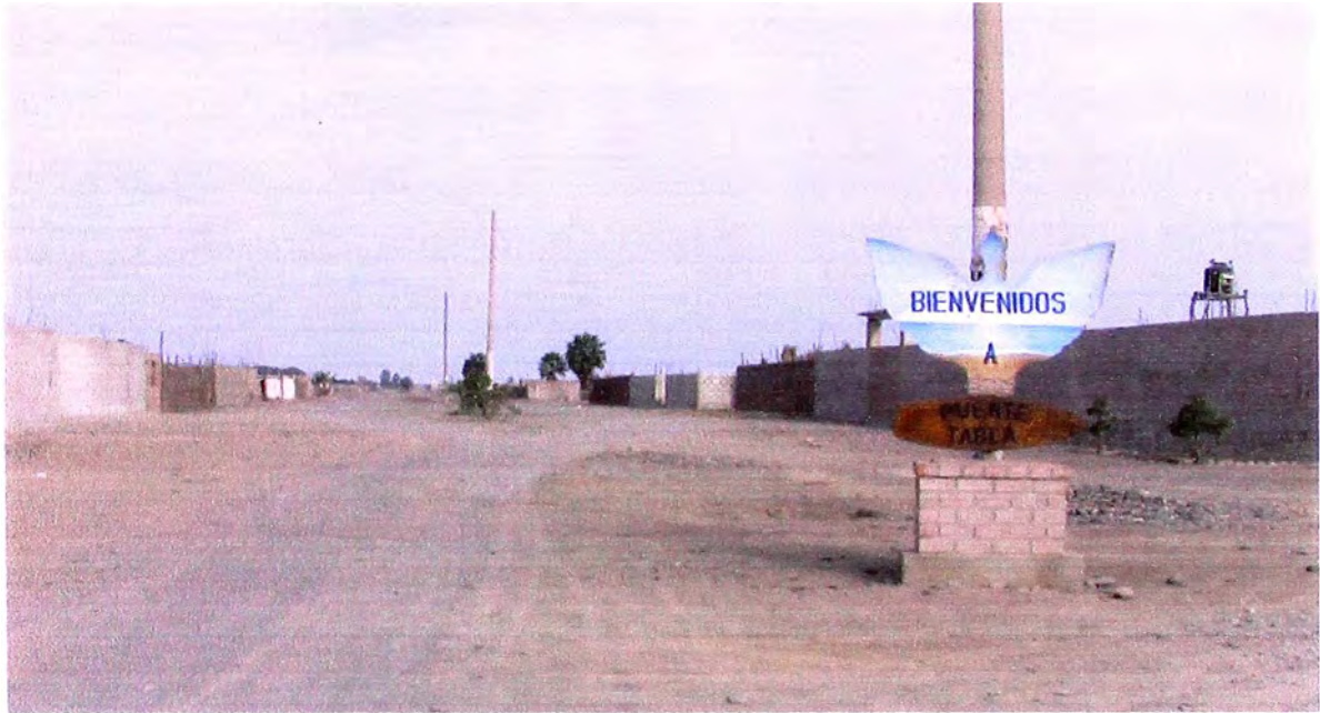
FOTO N° 01: VISTA PANORAMICA INGRESO A PUENTE TABLA
