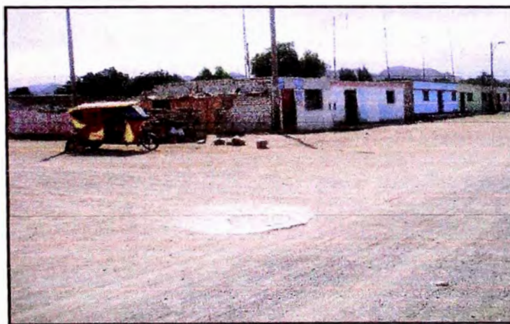
FOTO N°2.004: Calle en centro de Quilmaná
