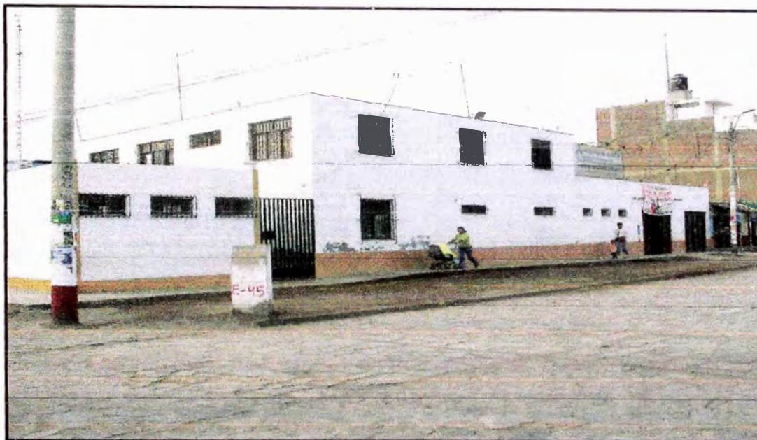
FOTO N°2.017: Centro Salud Quilmaná, vista desde Jr. Avacucho
