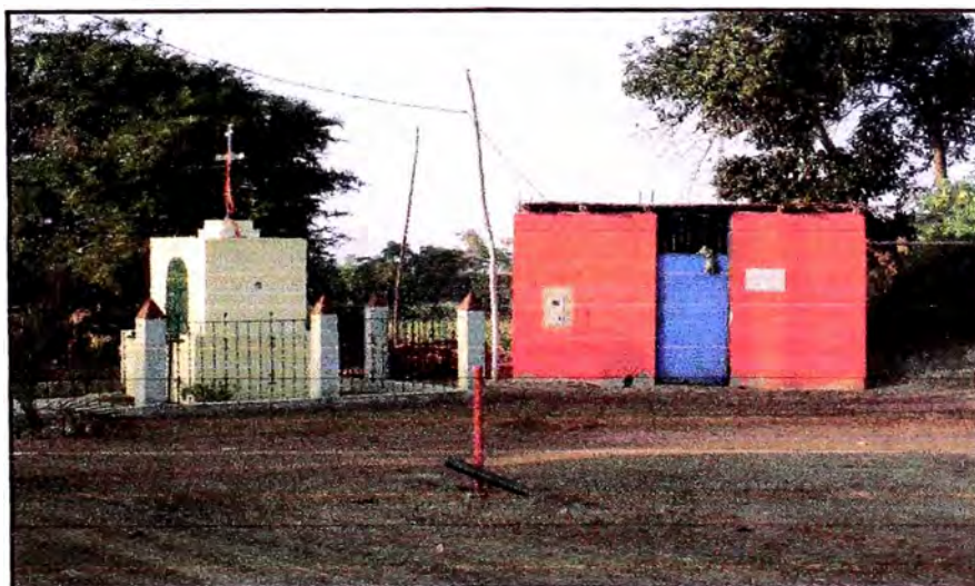
FOTO N°2.006: Futura fuente de abastecimiento de agua potable para Roldan, Pozo por explotar.
