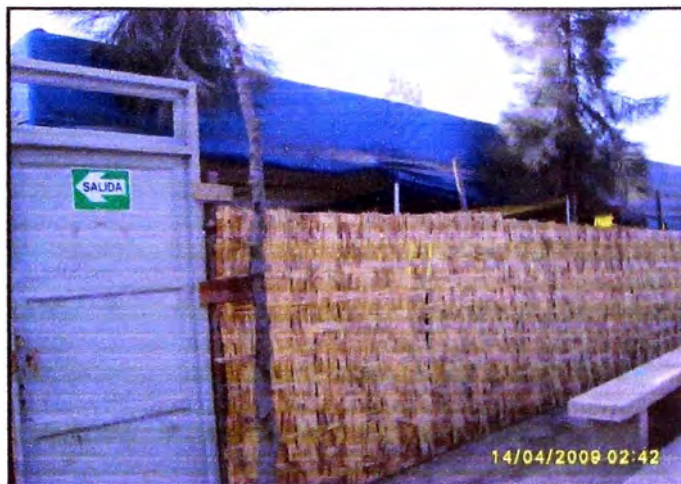
Foto N° 4.06: Vista lateral del Taller de Mecánica
