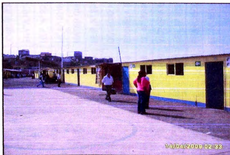
Foto N° 4.03: Vista de las aulas prefabricadas en la IEP José Buenaventura Sepúlveda
