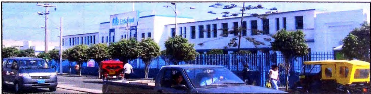
Foto N° 2.10: Hospital II ESSALUD
