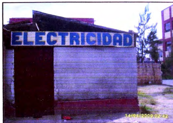
Foto N° 4.05: Taller de Electricidad sin condiciones mínimas de seguridad
