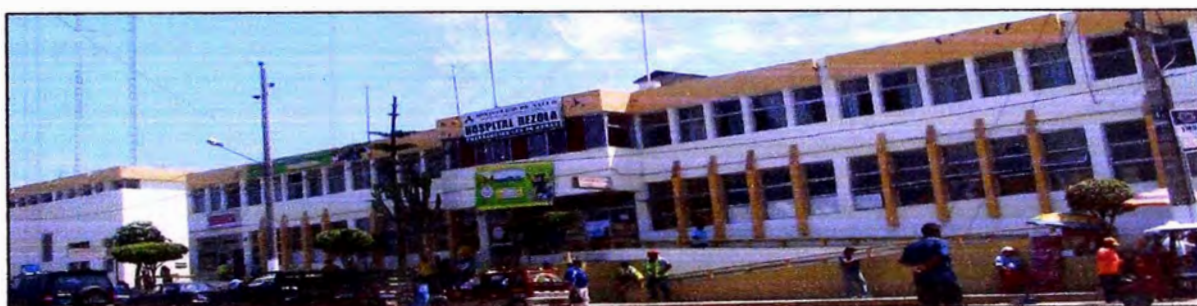
Foto N° 2.06: Hospital de Apoyo Rezola
