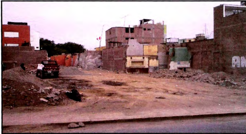
Foto N° 2.4.1: Vivienda afectada por sismo del 15 de agosto del 2,007
