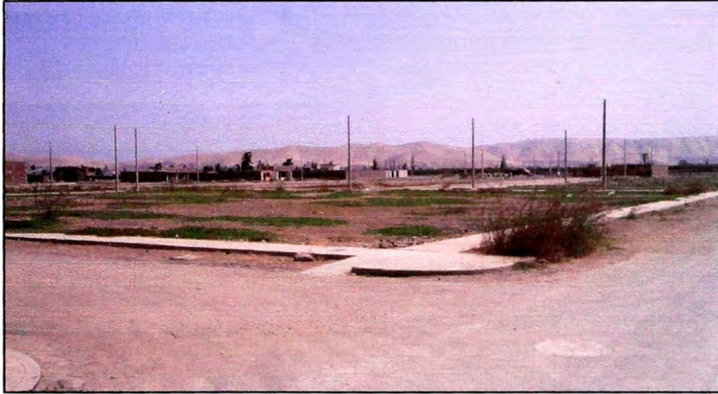
FOTO N° 1: Obras de Urbanización
