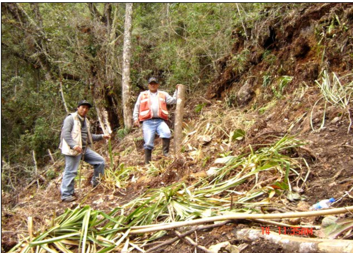
Fotografía N° 7. Vista de plataforma realizada en la campaña anterior, la cual se ha iniciado su rehabilitación.
