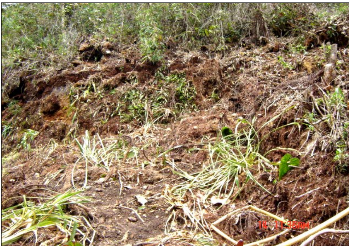
Fotografía N° 8. Vista de plataforma realizada en la campaña anterior, la cual se encuentra en proceso de rehabilitación.
