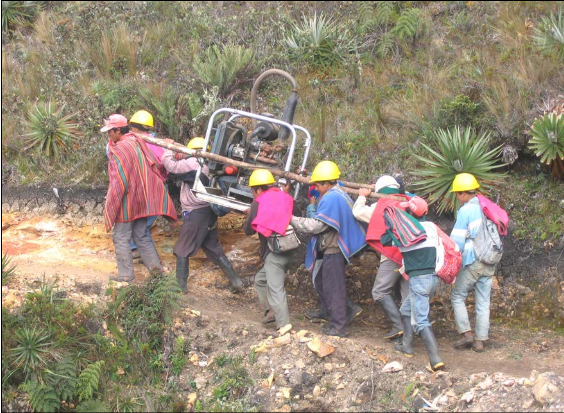
Fotografía N° 11. Transporte del motor de la maquina perforadora que se utilizó en la campaña anterior.
