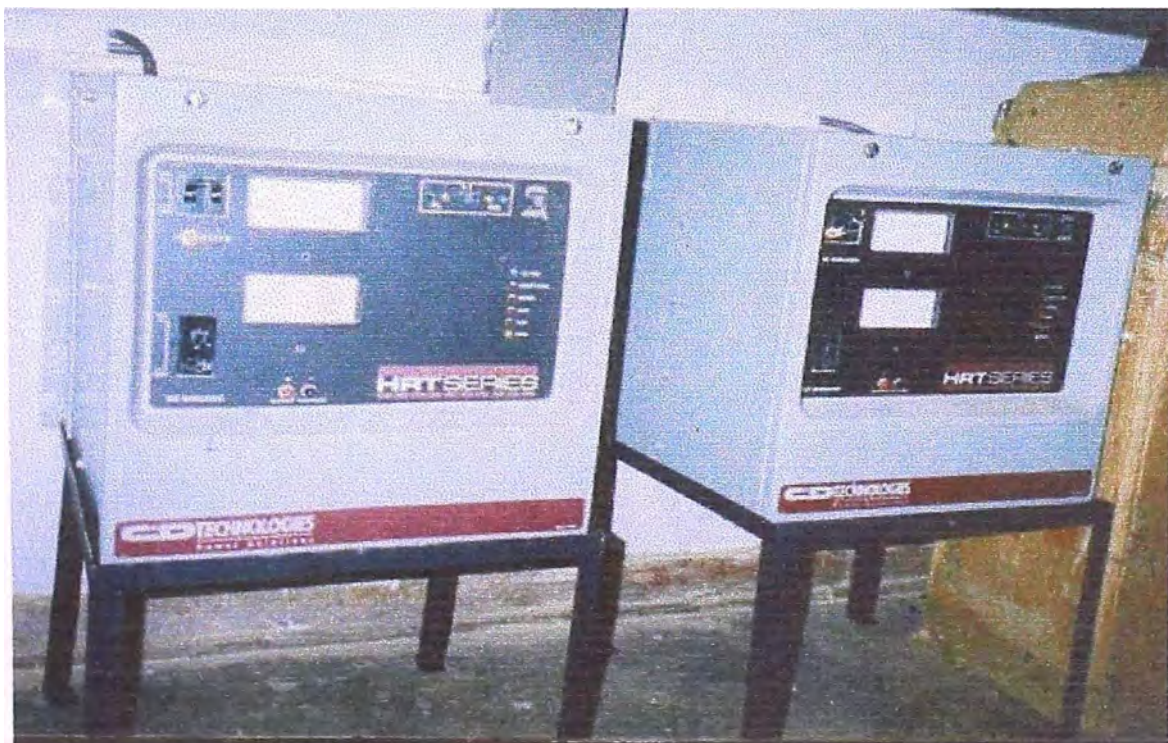
FIGURA 7 RECTIFICADORES DEL SISTEMA HÍBRIDO FV-DO
