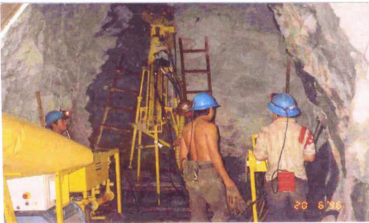
Figura N° 41.- Equipo DIAMEC trabajando en interior mina.
