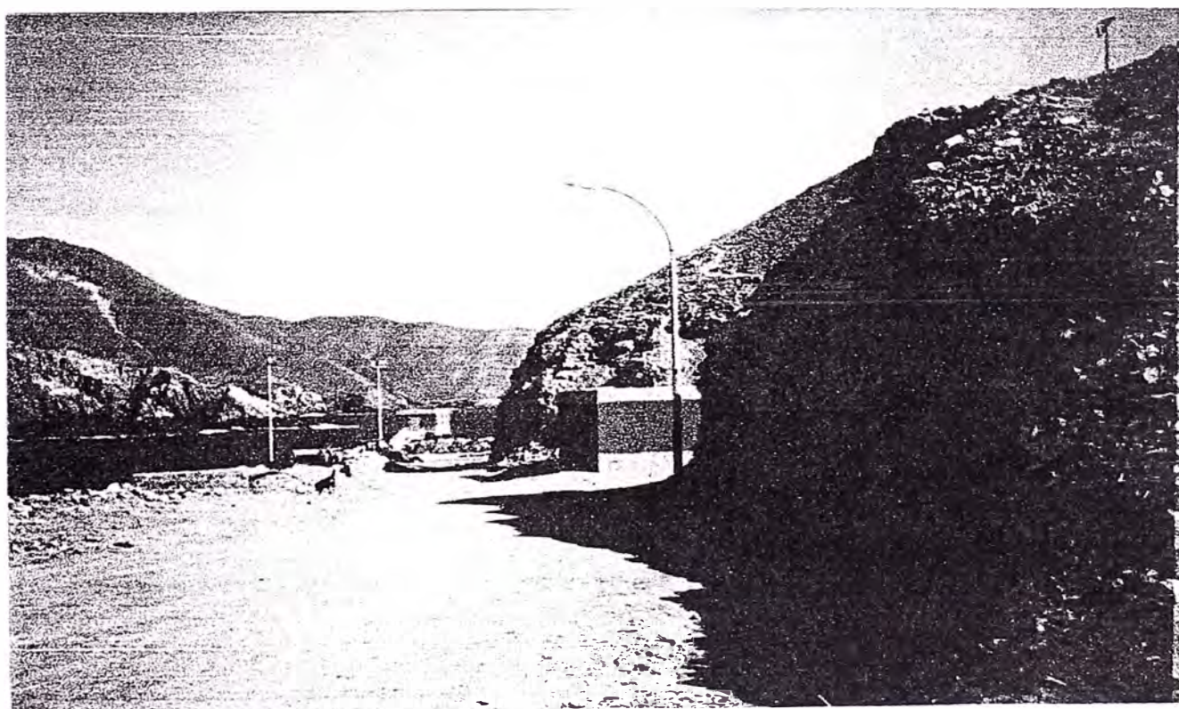
Foto N° 4 Vista de caseta (1) al fondo y caseta (2) al centro
