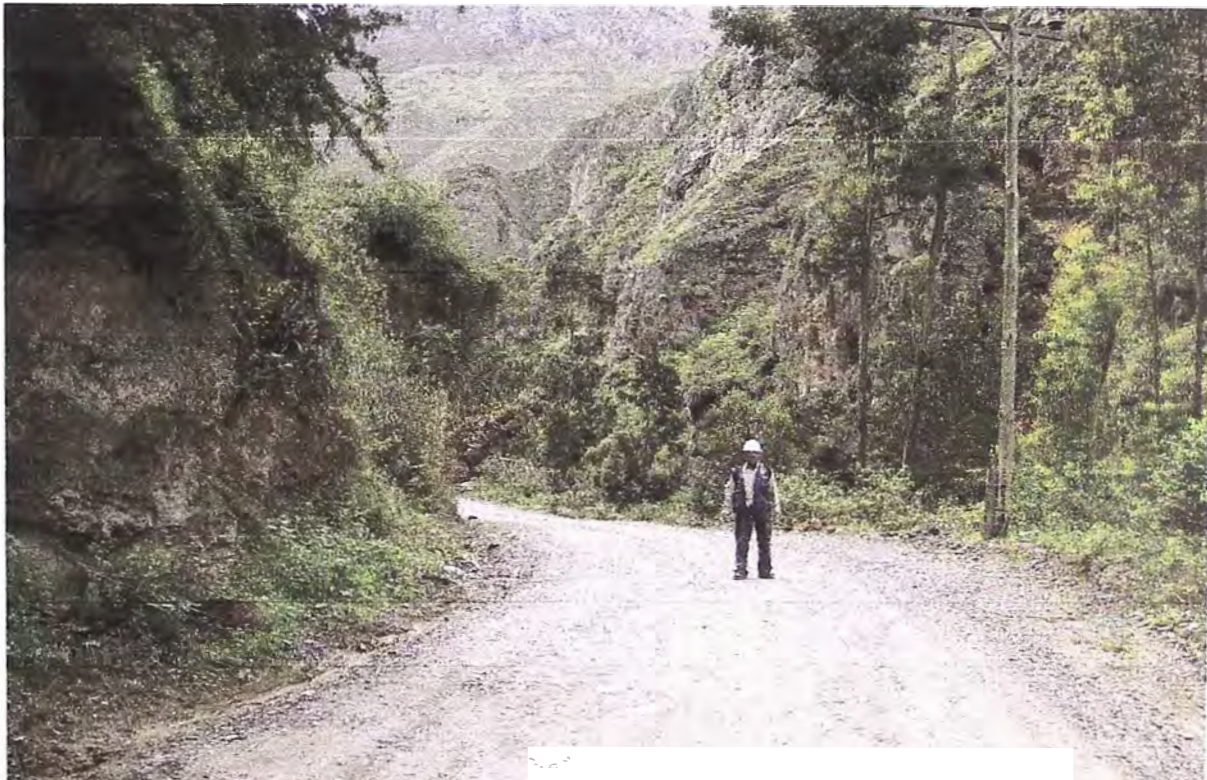
Foto N° 4: Se observa la reducción del ancho de la calzada por la invasión de la maleza.
