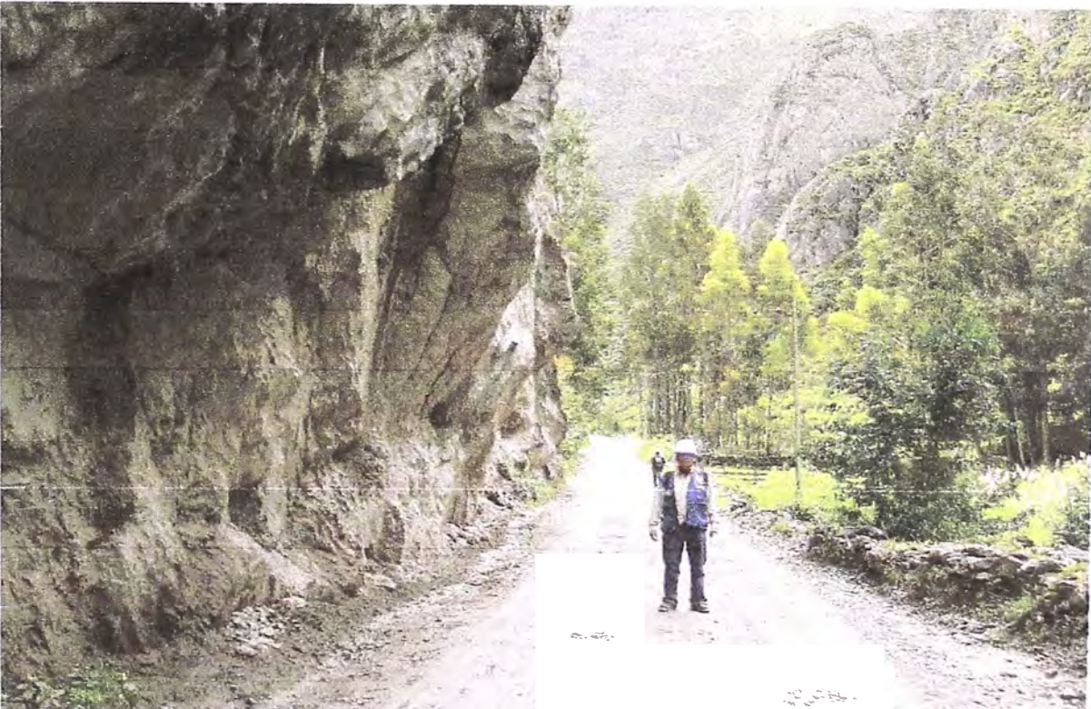
Foto N° 10: Se observa el tramo final recto donde se deberá ampliar la calzada y construir las cunetas para el drenaje.
