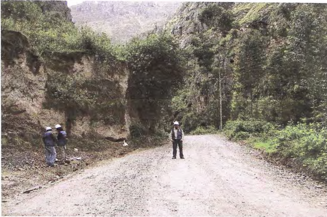
Foto N° 1: Se muestra la progresiva 163+510 de la carretera como se encuentra actualmente.
