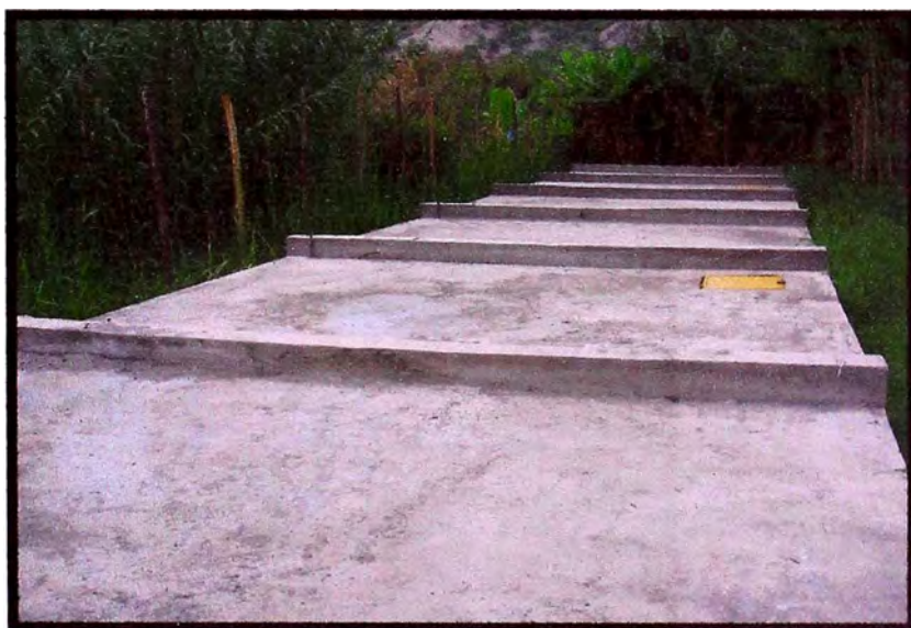
Figura 3.1: Estructura de captación de concreto armado
