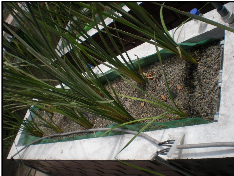
Figura 48. Humedal con Aireación Intermitente (H3)
