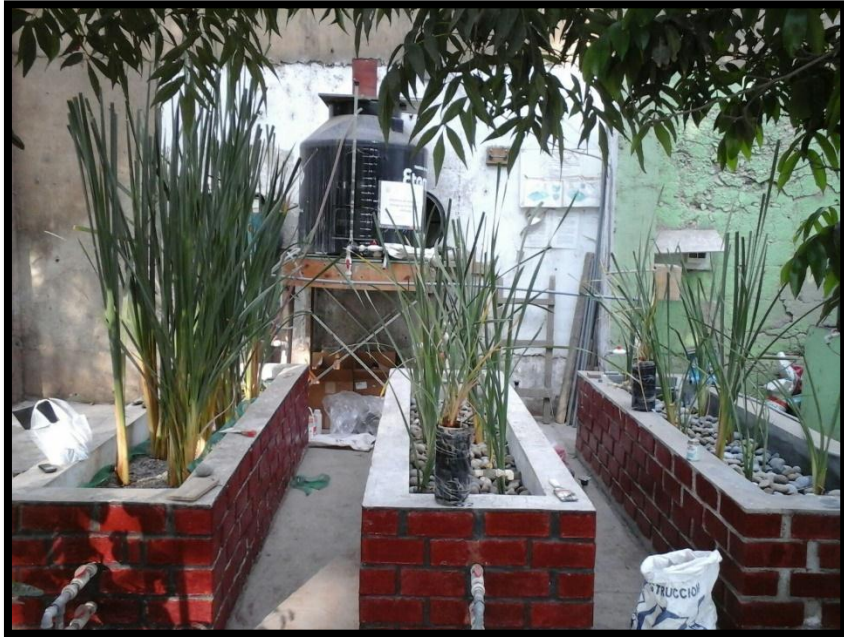
Figura 42. Armado del humedal
