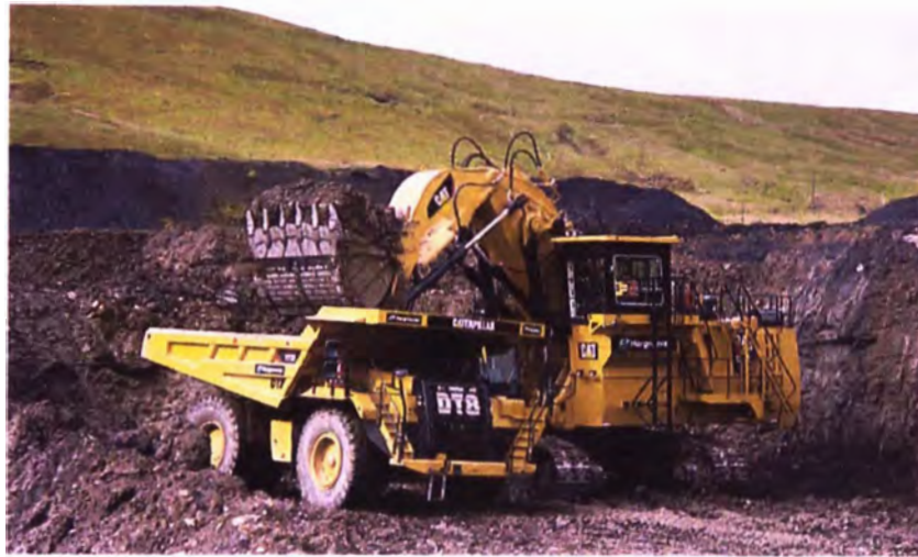
Figura 3.9: Pala hidráulica cargando material (Fuente Google Cartepillar)
