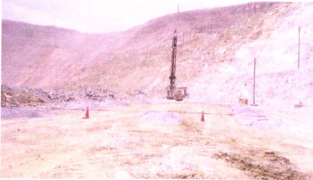
Figura 3,3: Perforación rotativa (Fuente Southern Perú)
