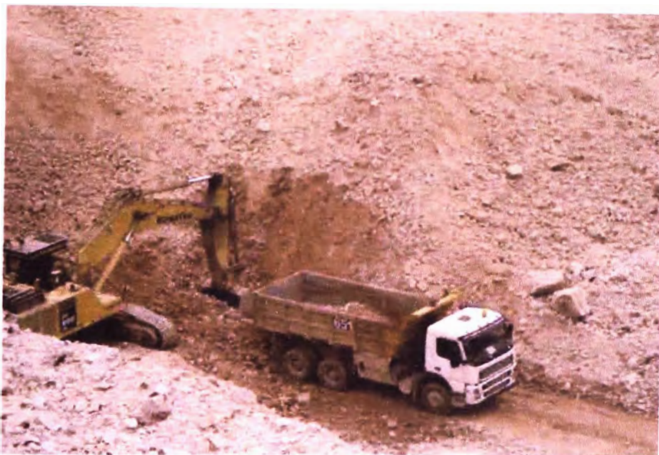
Figura 3,1: Operación de carguío y acarreo (Fuente propia)
