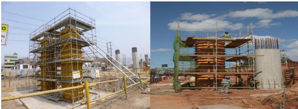
Figura N° 5.53 Encofrado de columna
