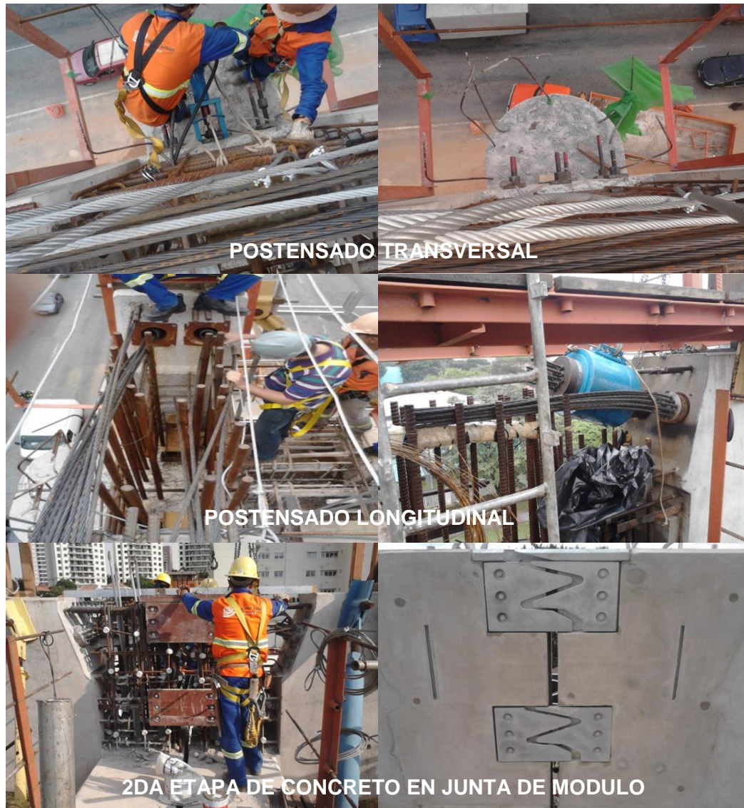
Figura N° 5.60 Postensado y cierre de modulo
