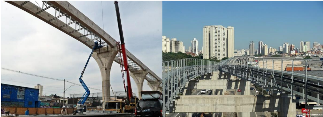
Figura N° 5.61 Pasarelas de evacuación
