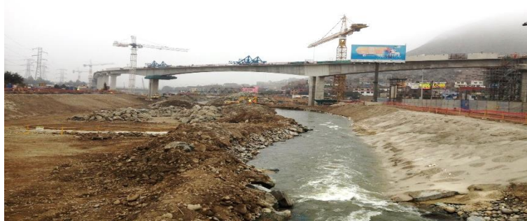
Figura N° 4.3 Obras en el río Rímac
