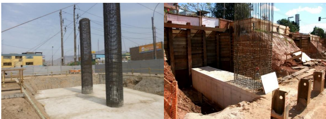
Figura N° 5.52 Concreto en Zapata
