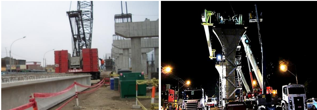
Figura N° 4.2 Maquinaria y Equipos en Obra
