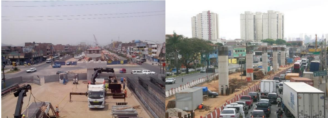
Figura N° 4.5 Delimitación de la zona de construcción
