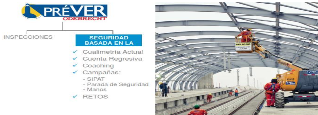
Figura N° 4.9 Seguridad en obra.
