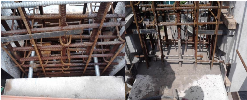
Figura N° 5.58 1ra etapa de cierre de vigas
