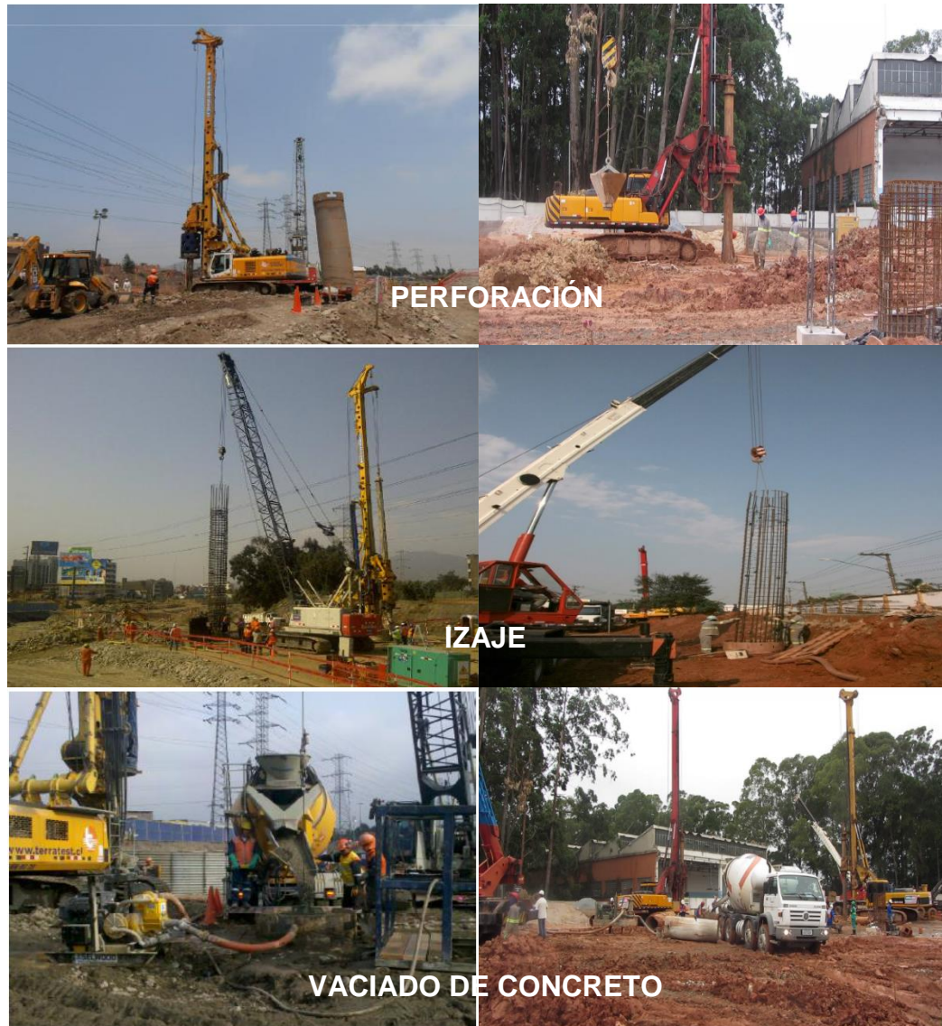
Figura N° 5.48 Ejecución de pilotes
