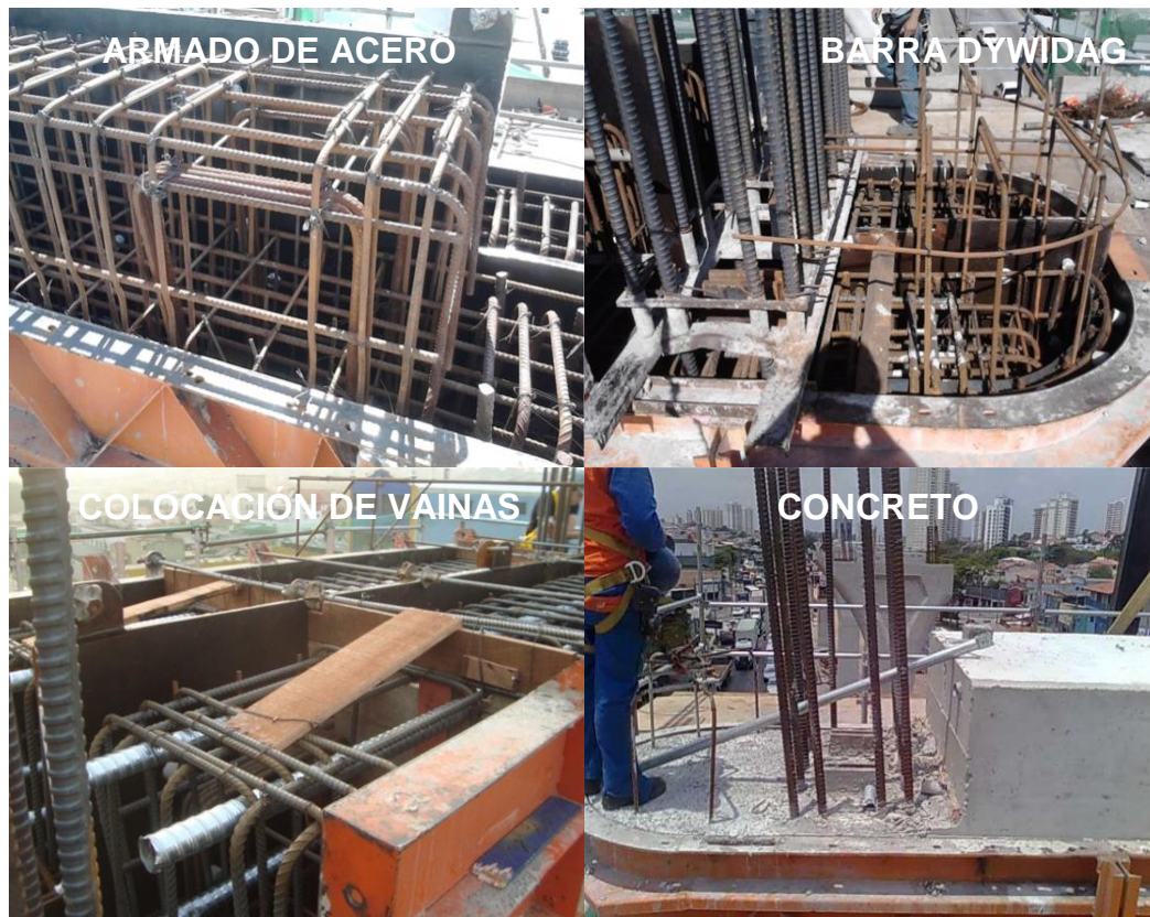
Figura N° 5.57 Preparación de la parte superior del pilar
