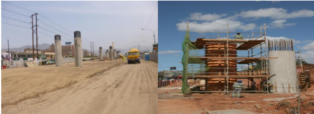
Figura N° 5.54 Bi Columnas finalizadas
