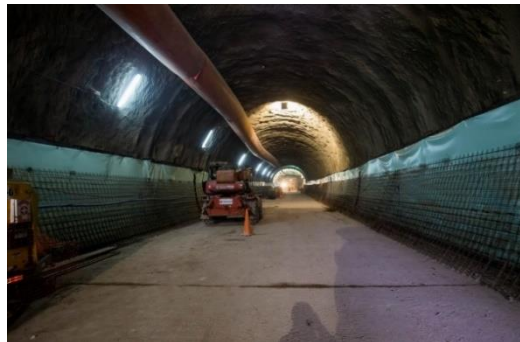
Figura N° 3.4 Excavación del túnel para la Línea 2 del metro de Lima.
