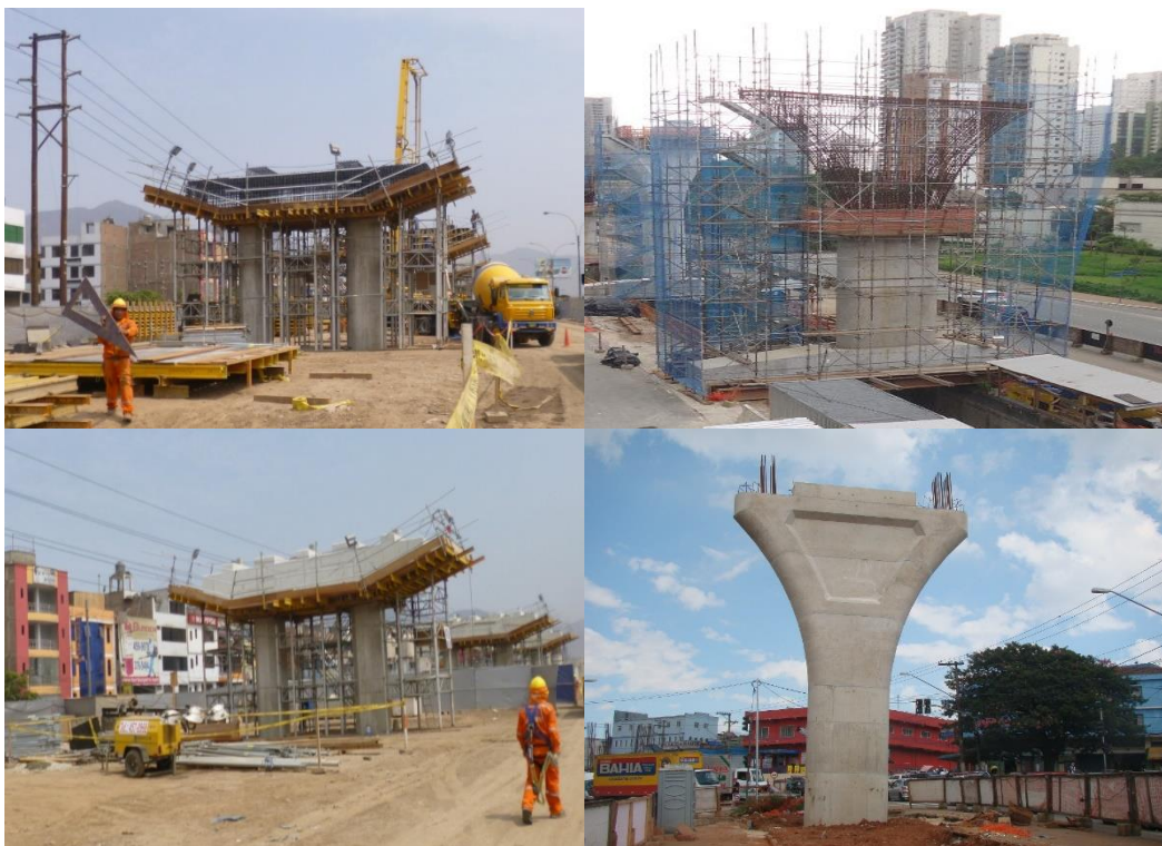
Figura N° 5.55 Fondo de encofrado, acero y concreto en viga cabezal
