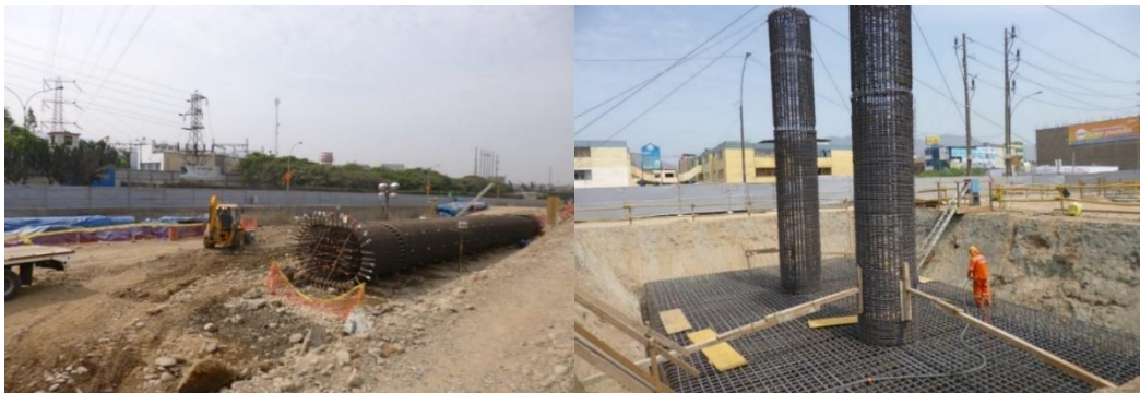
Figura N° 5.51 Acero de columna
