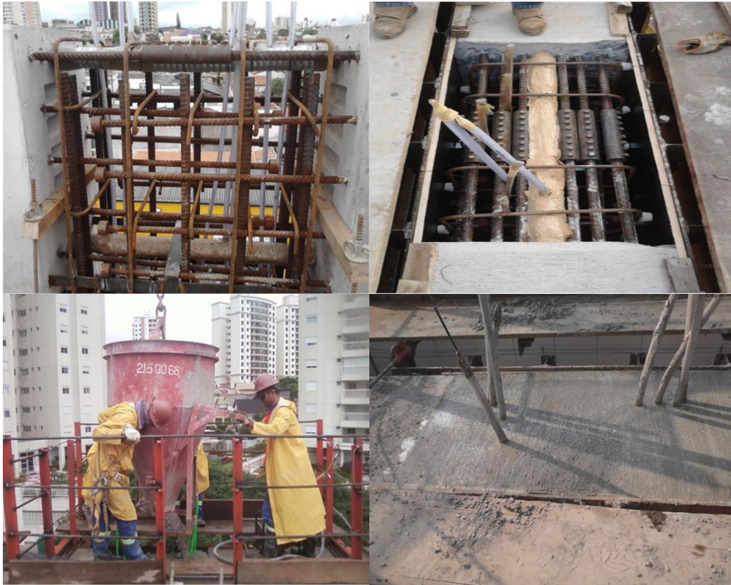
Figura N° 5.59 2da etapa del cierre de vigas
