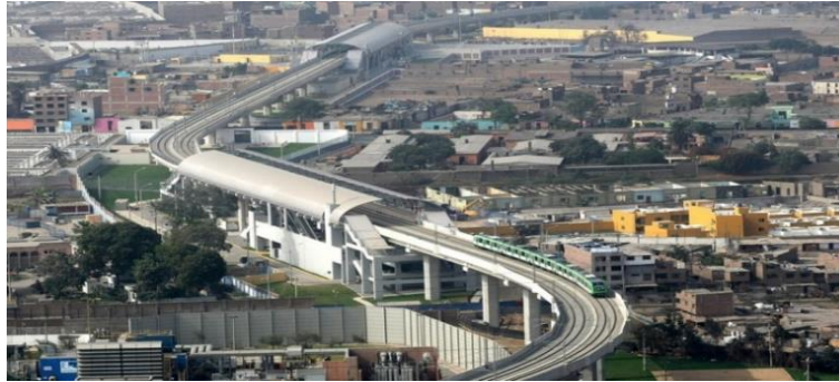
Figura N° 3.5 Línea 1 metro de Lima, vía férrea, anden y estación elevada.
