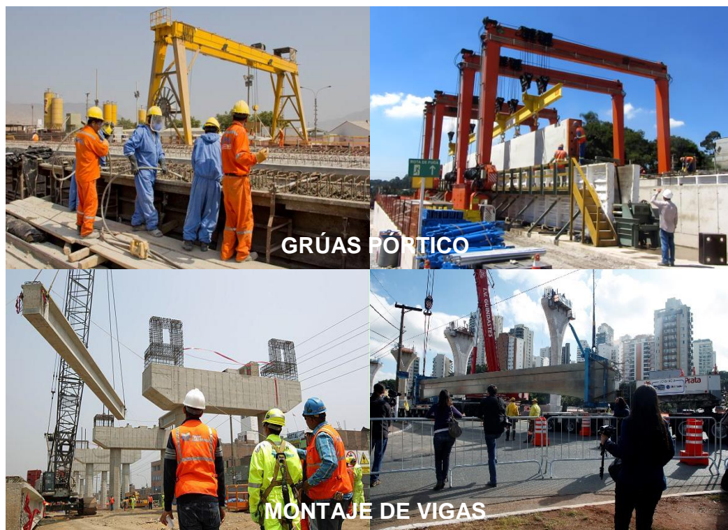
Figura N° 5.56 Montaje de vigas prefabricadas
