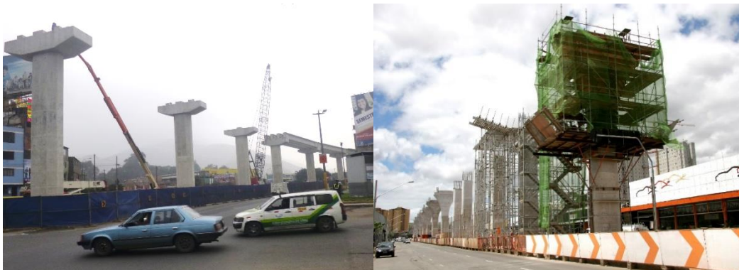
Figura N° 4.4 Alteración visual en construcción
