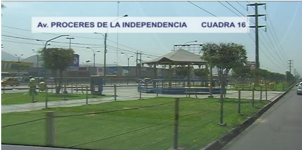
Figura N° 5.45 Interferencias Aéreas Tramo 2 Línea 1
