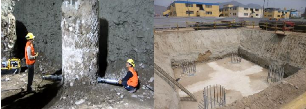
Figura N° 5.49 Excavación de Zapata y Descabezado de Pilote
