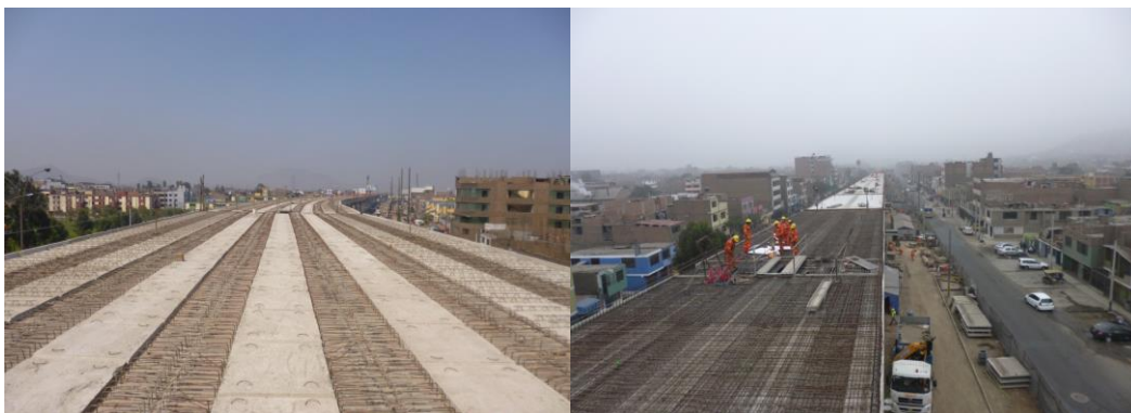
Figura N° 5.62 Losas prefabricadas y acero de losa de viaducto
