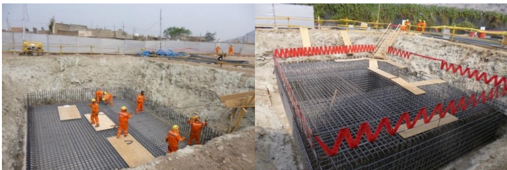
Figura N° 5.50 Acero para zapata
