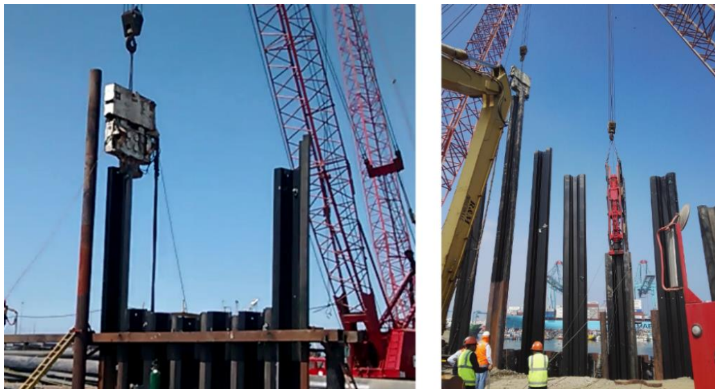
Figura N° 18 Proceso de hincado con martillo vibratorio e hincado
