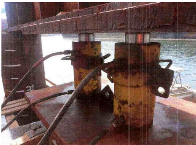
Figura N° 38 Gatas hidráulicas para prueba de carga estática
