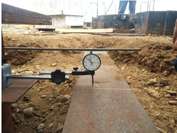
Figura N° 27 Instalación de micrómetros
