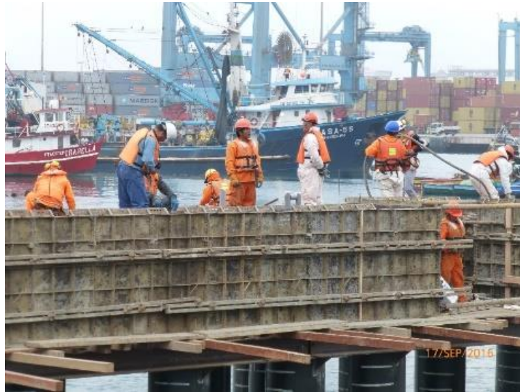
Figura N° 33 Proceso de encofrado
