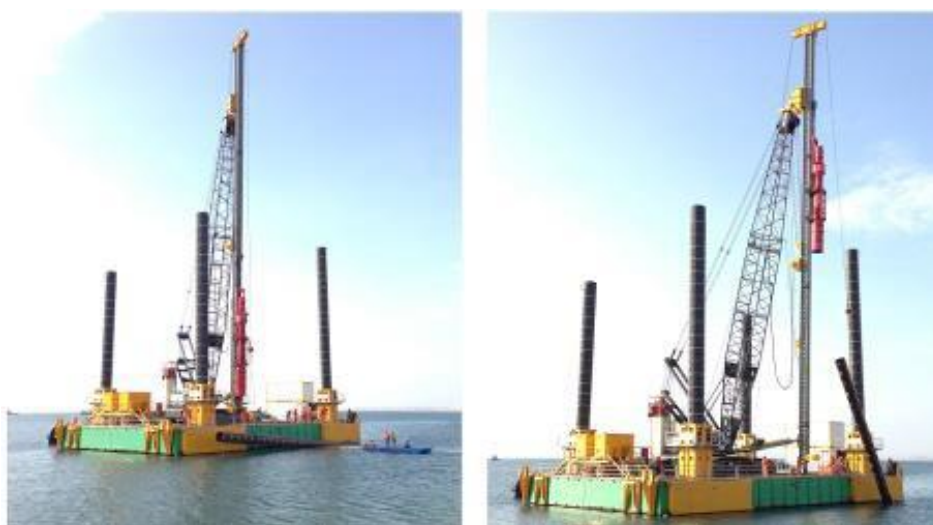
Figura N° 23 Izaje de pilote en el mar
