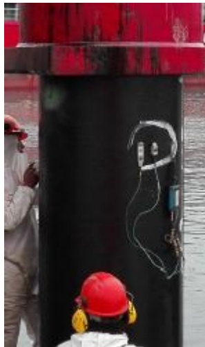
Figura N° 25 Colocación de los sensores PDA en el pilote metálico
