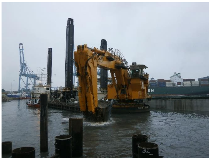
Figura N° 32 Proceso de dragado
