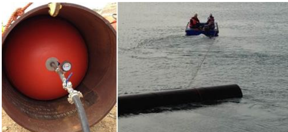
Figura N° 22 Llenado de balones y traslado de pilotes hacia la zona de hincado
