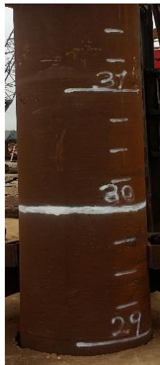
Figura N° 21 Pintado de marcas de referencia
