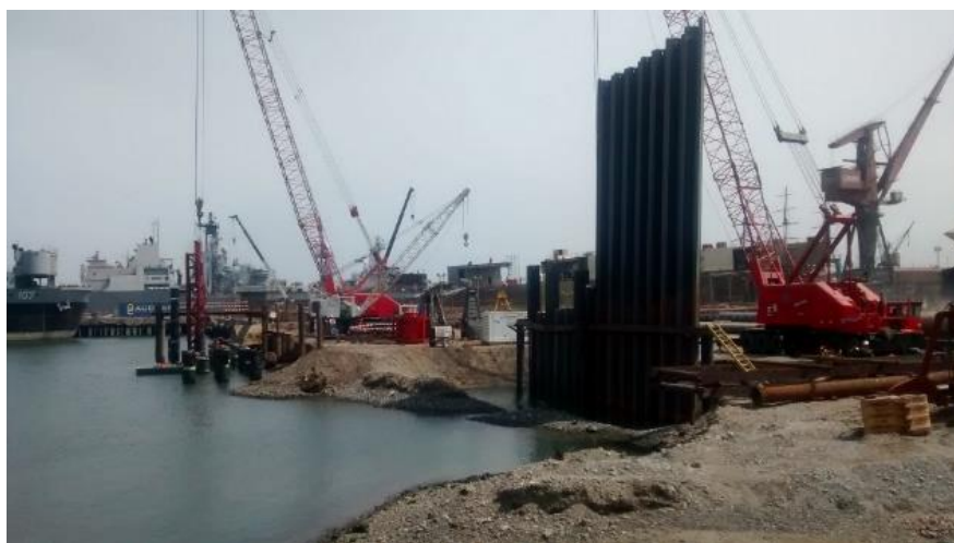
Figura N° 35 Proceso de hincado de tablestacas
