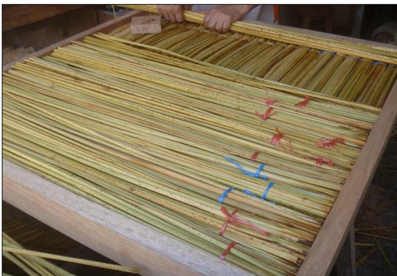
Colocación de la totora y segunda parrilla de varillas de acero corrugado de \frac{1}{4} "
