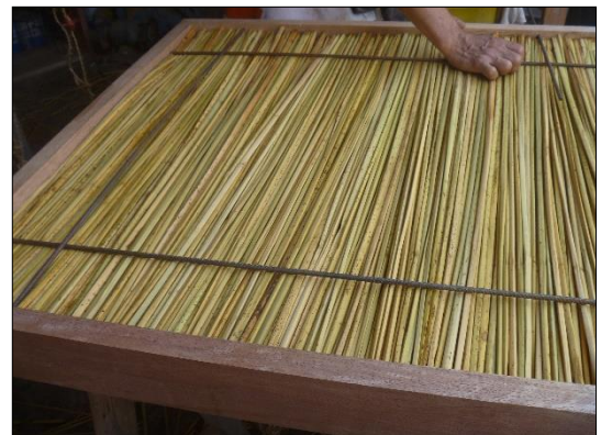
Colocación de la totora y segunda parrilla de varillas de acero corrugado de \frac{1}{4} "
