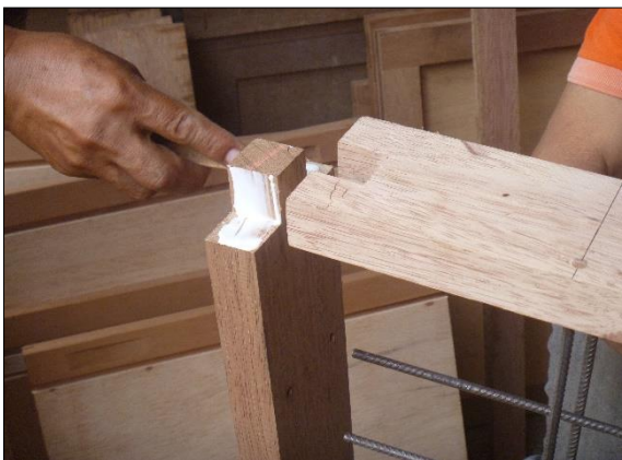
Unión de elementos verticales y horizontales
