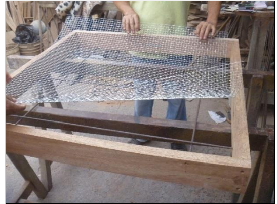
Colocación de varillas de acero corrugado de \frac{1}{4} " y malla electrosoldada cuadrada de \frac{1}{2} "
