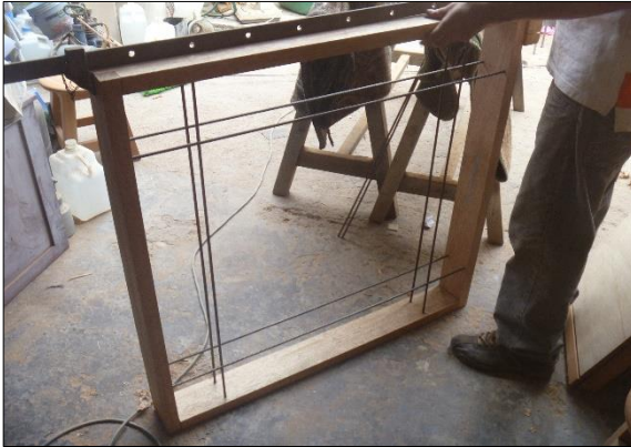
Colocación de varillas de acero corrugado de \frac{1}{4} " y malla electrosoldada cuadrada de \frac{1}{2} "
