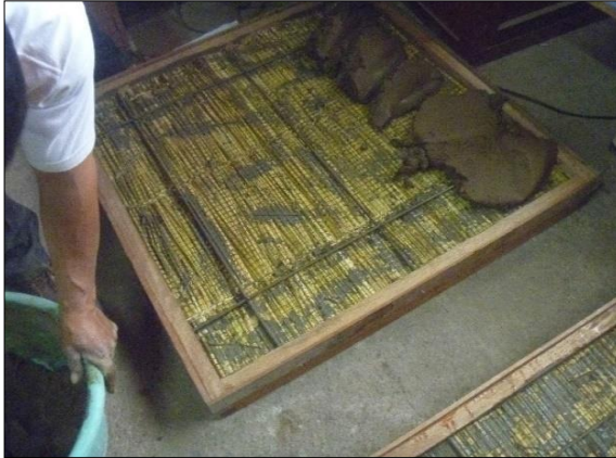
Revestimiento primario de mortero de cemento y tierra tamizada C:T/1:4
