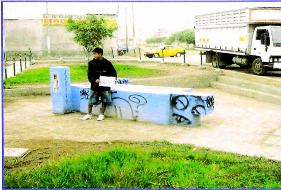
En esta imagen se observa la cámara de control SCADA del Sector S0311
