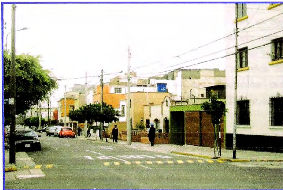
En esta imagen se puede observar las características de las viviendas y el estado de sus calles, propias de una zona residencial, a su vez se observa tanques de almacenamiento ubicados en la azotea de las viviendas.
