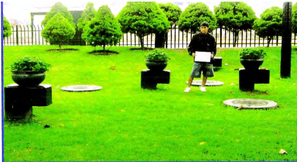
En esta imagen se observa la cámara de control SCADA del Sector S0056
