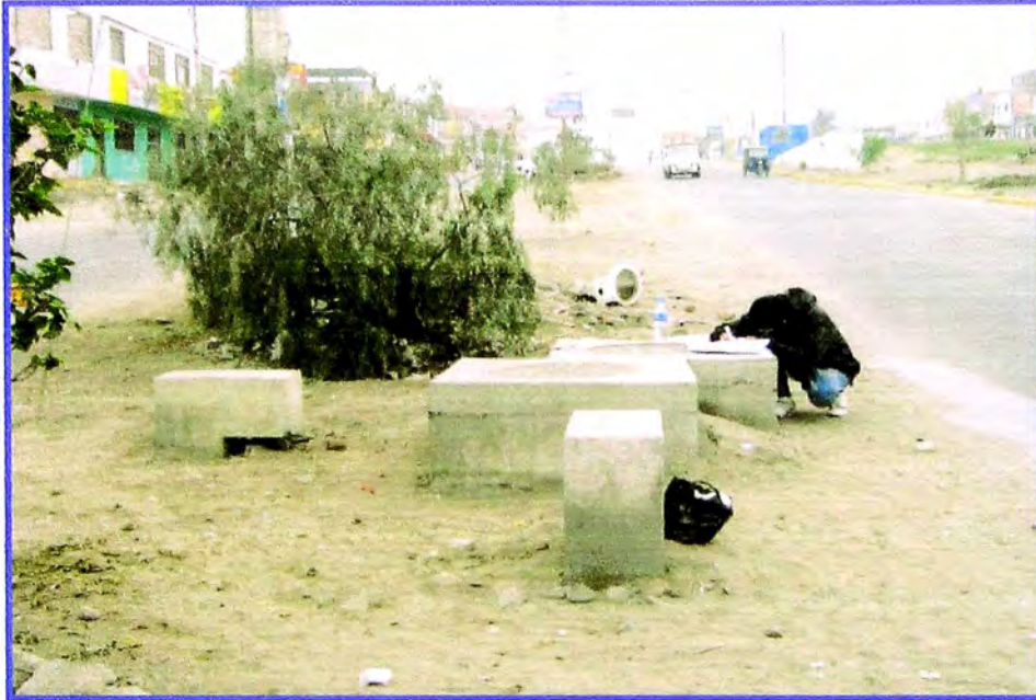
En esta imagen se observa la cámara de control SCADA del Sector S0317
