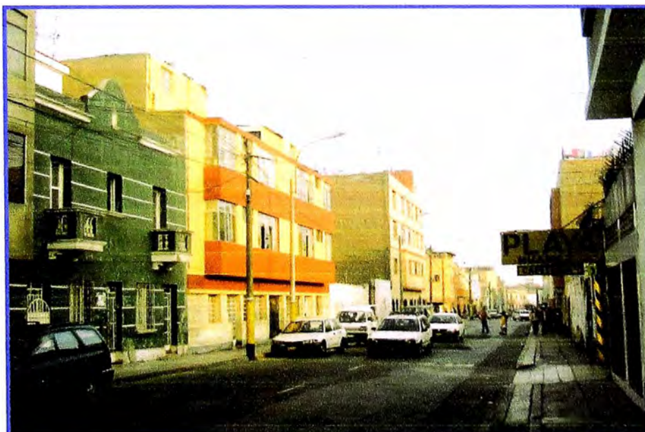
En esta imagen se puede observar el regular estado conservación de las calles y de las viviendas del sector.
