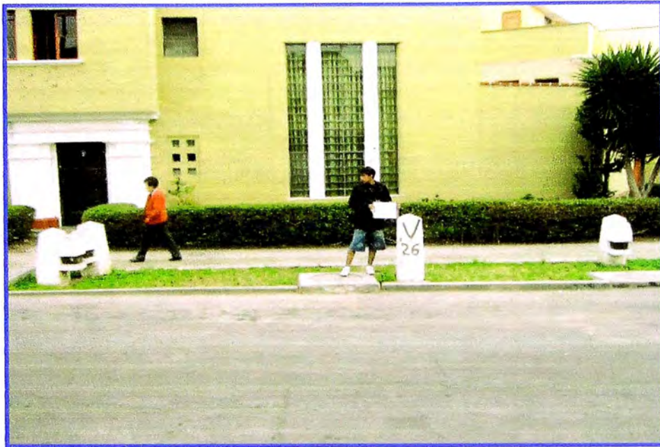
En esta imagen se observa la cámara de control SCADA del Sector S0026
