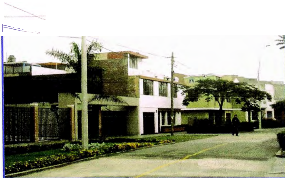
En esta imagen se puede observar las características de las viviendas y el estado de sus calles, propias de una zona residencial, a su vez se observa tanques de almacenamiento ubicados en la azotea de casa.
