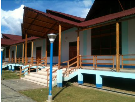
Foto N° 1: Bloque A-fuente propia
