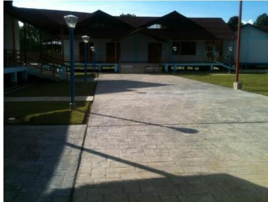
Foto N° 3: Bloque C-fuente propia
