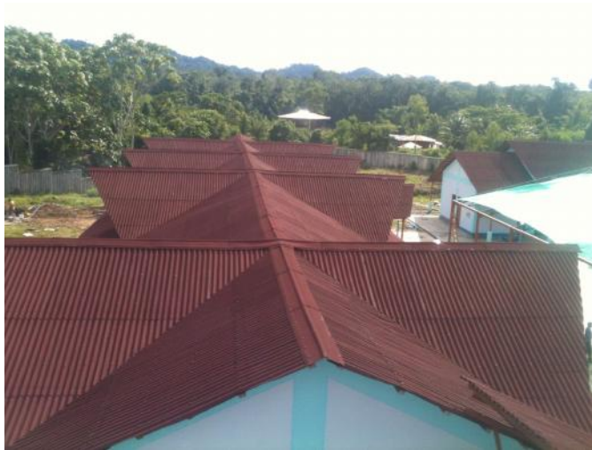
Foto N° 11: Techo en dos aguas-fuente propia
