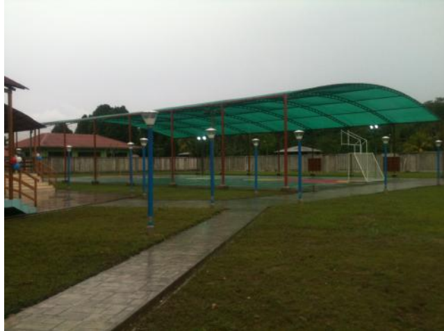
Foto N° 13: Vista general del patio -fuente propia
