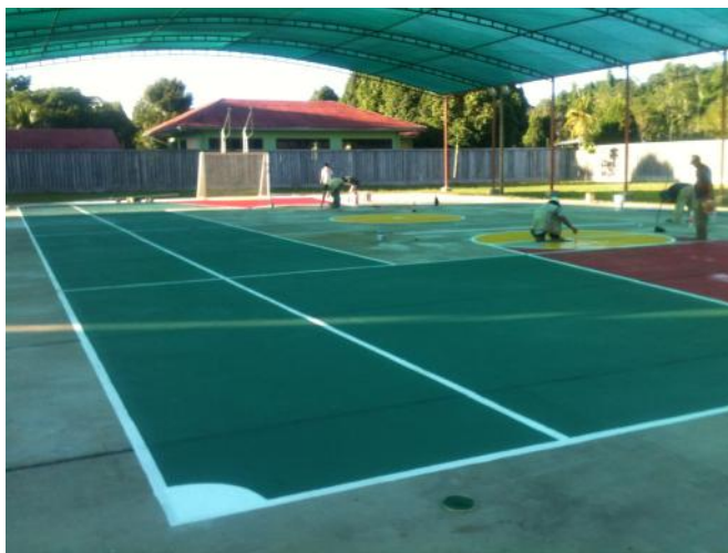
Foto N° 12: Losa deportiva con cobertura Malla Rasell-fuente propia
