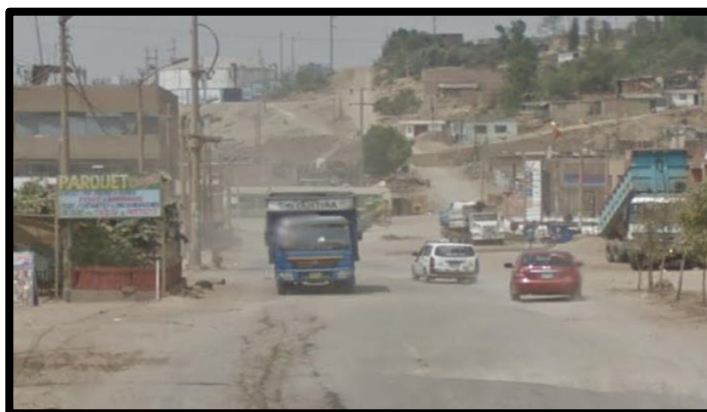
Figura N°A5.2 Vía Periurbana, Puente Piedra.
