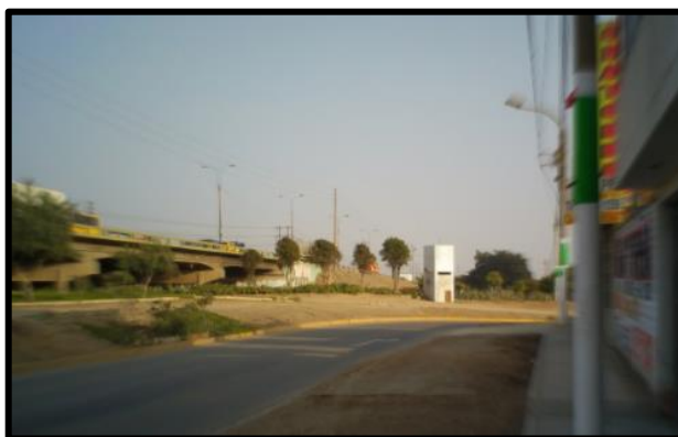
Figura N°A5.4 Av. Malecón Chillón, Puente Piedra.
