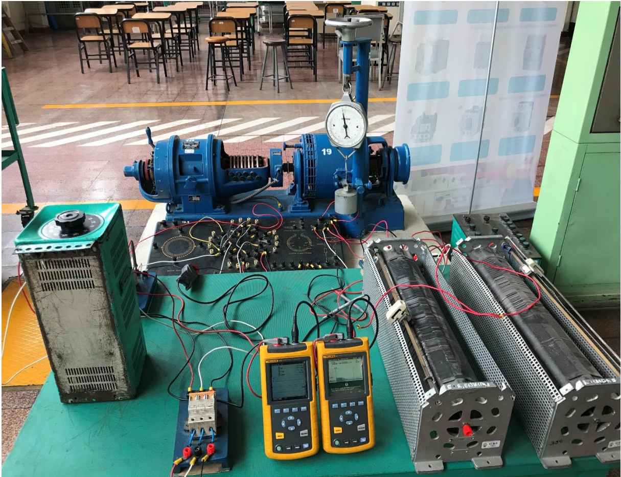
Figura 6.152 En la figura se muestra las instalaciones realizadas a la máquina de inducción Students (ubicada en el lado izquierdo del conjunto integrado con la máquina DC ubicado al lado derecho de la vista) con las conexiones realizadas como motor asíncrono de anillos rozantes con conexión en delta el devanado estatorico, dos polos y alimentación de tensión nominal 230 Voltios eficaz a frecuencia de 60 Hz
