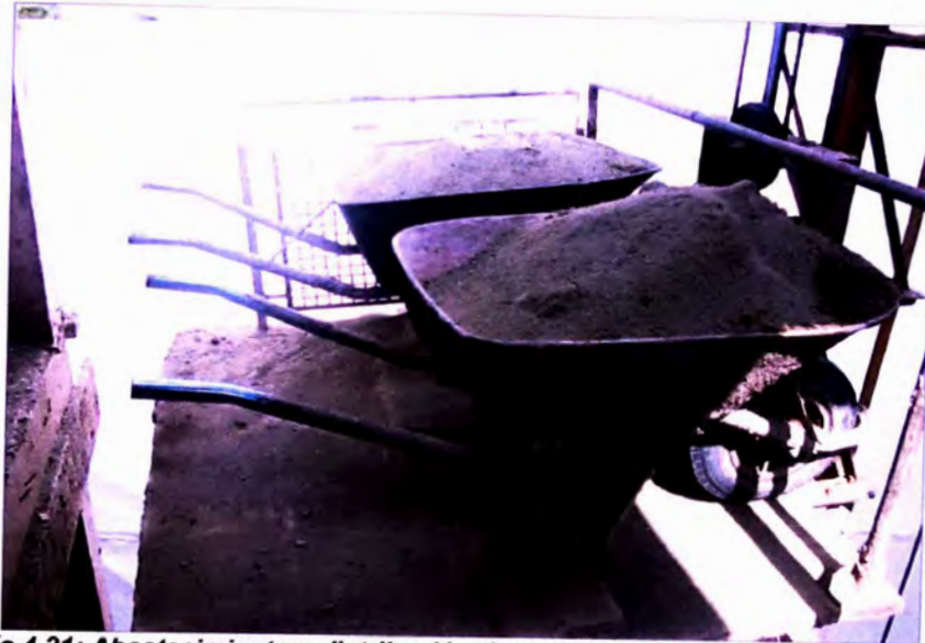
Fotografía 4.21: Abastecimiento y distribución de materiales en distintos frentes de trabajo.
