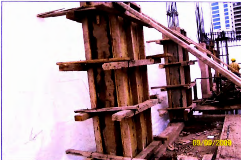
Fotografía 4.16: La unidad de producción a ser medida en el programa era de 1 columna (0.6x0.25x2.40 m) por pareja (1 Ope+1 Ayu).
