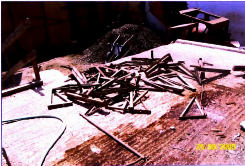
Fotografía 4.19: Cabezales desarmados y en completo desorden.
