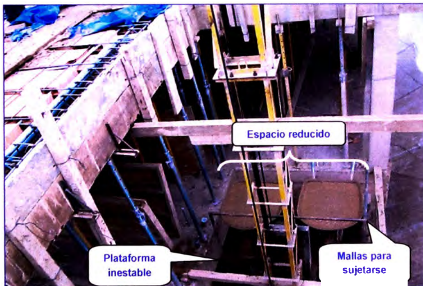
Fotografía 4.15: Plataforma por donde suben los bogies a los pisos superiores.
