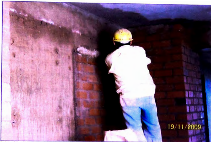
Fotografía 4.27: Actividad contributoria previa al tarrajeo (colocado de malla metálica).
