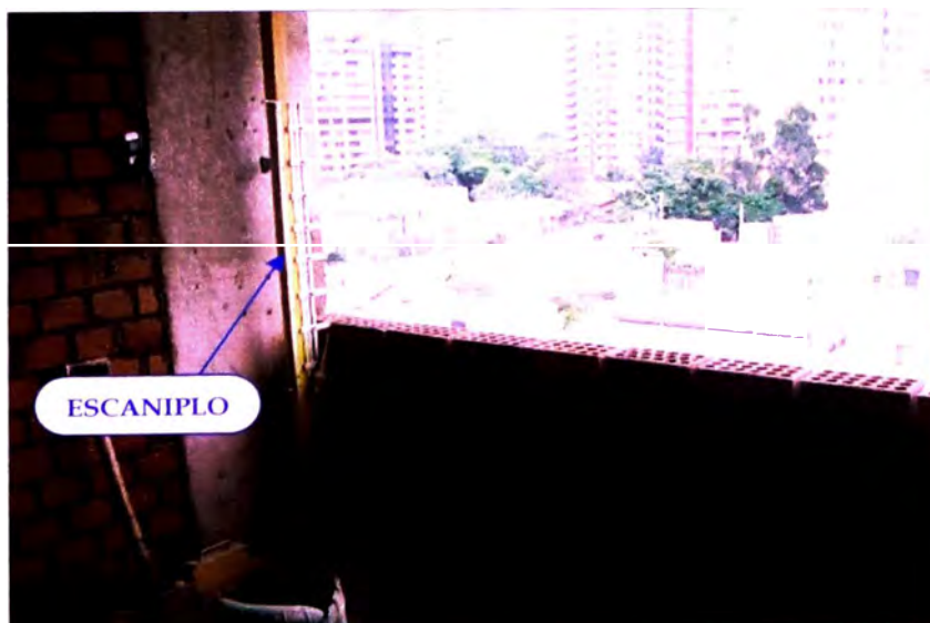
Fotografía 4.23: Escaniplo aplomado, usado durante el asentado de ladrillos.
