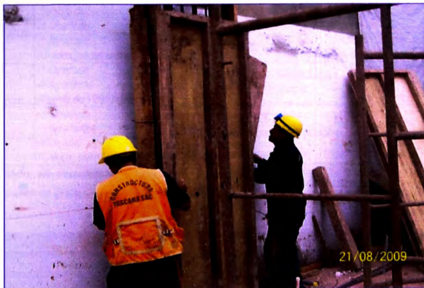
Fotografía 4.4: Colocado de paneles durante el encofrado de columnas.
