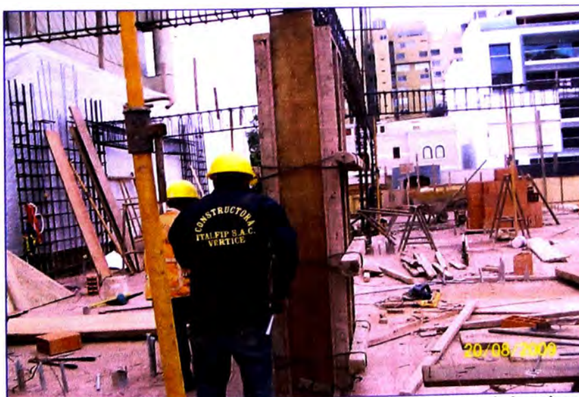
Fotografía 4.5: Amarrado de alambres para asegurar el ancho de la columna.
