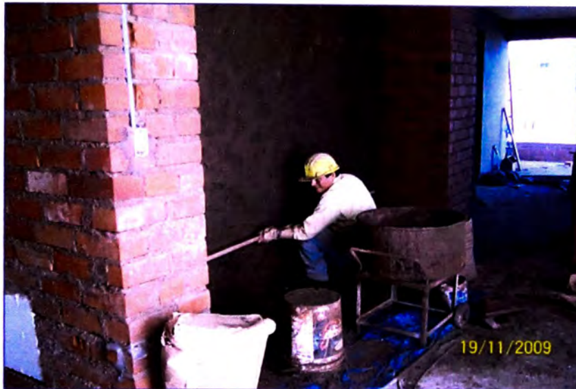
Fotografía 4.13: Operario regleando el mortero, buscando la verticalidad de la pared durante el tarrajeo.
