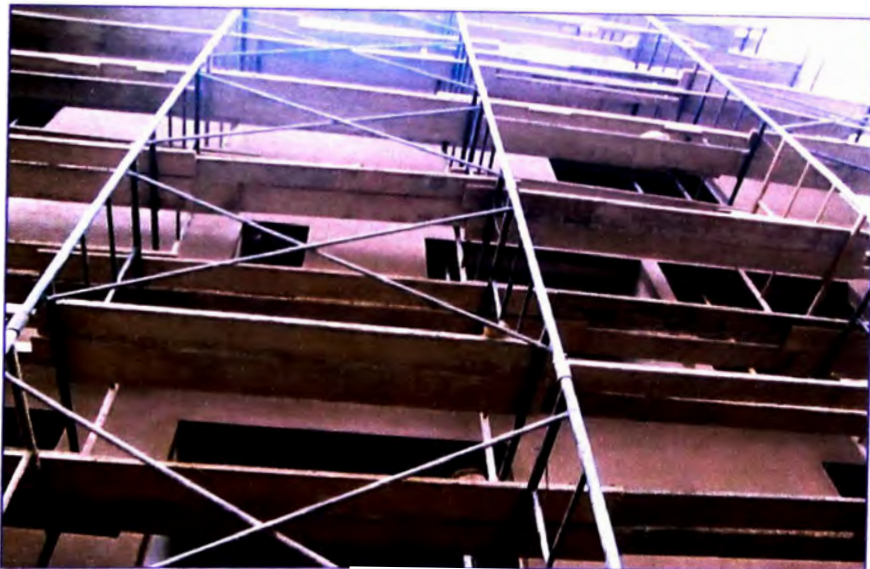
Fotografía 4.30: Fachada ya terminada de acuerdo a lo planificado (1 fachada por día).
