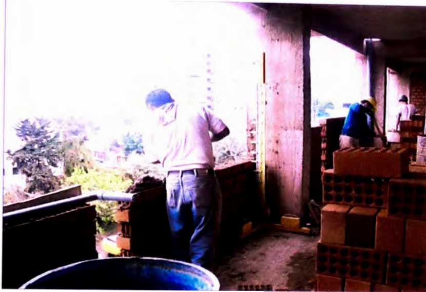
Fotografía 4.24: El uso del Escaniplo permite la eliminación de tareas como el aplome y colocado de ladrillos guía para el cordel.
