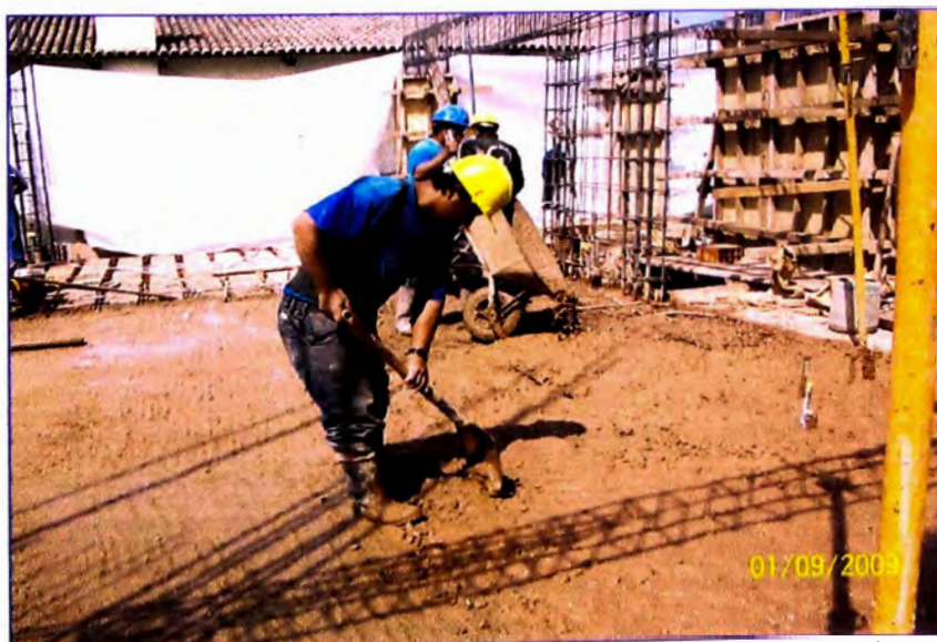
Fotografía 4.2: Transporte y vaceado de concreto en losas, también se observa al operario lampeando el concreto.
