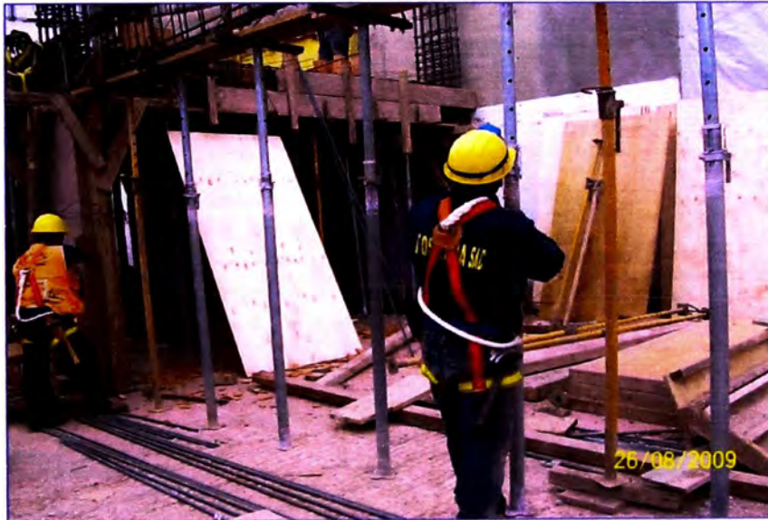
Fotografía 4.6: Nivelación de fondo de viga.
