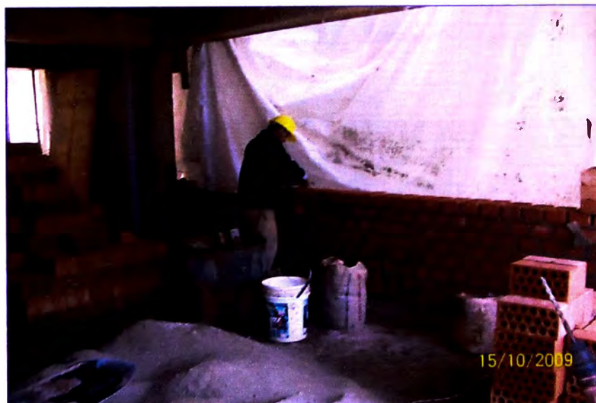
Fotografía 4.8: Actividad de colocado de ladrillos en la partida de albañilería.
