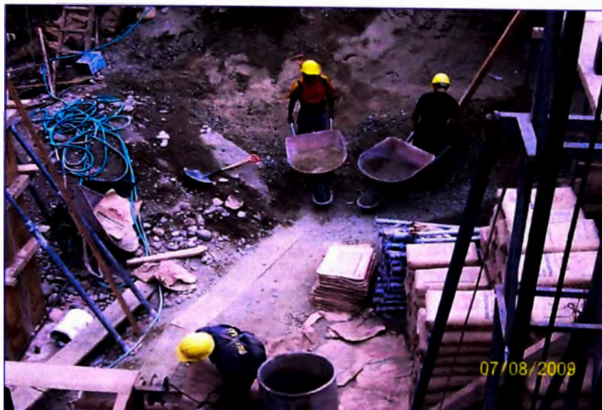
Fotografía 4.3: Transporte y vaciado de los agregados en la mezcladora para el preparado de concreto.
