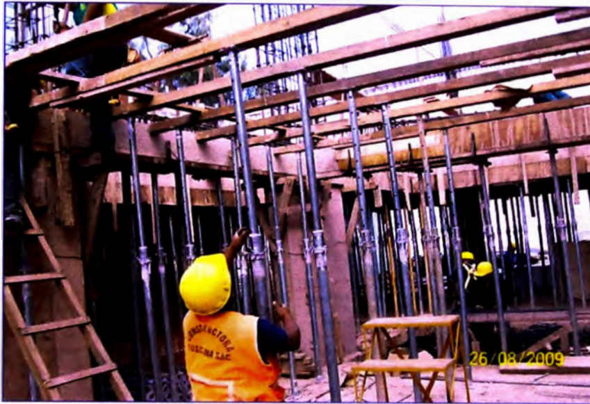
Fotografía 4.7: Apuntalamiento del fondo de losa aligerada.
