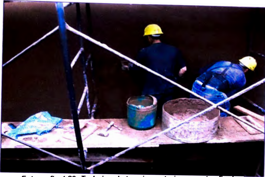
Fotografía 4.29: Trabajos de tarrajeo exterior, remates finales.
