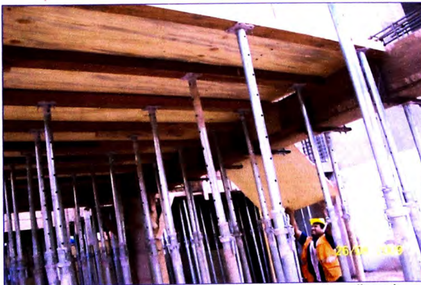
Fotografía 4.18: Diseño inicial para el encofrado de losa aligerada.
