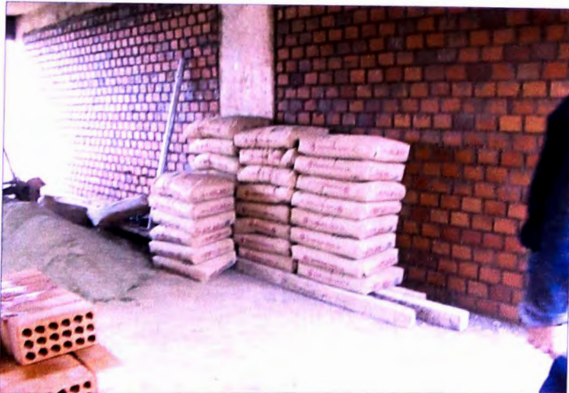
Fotografía 4.22: Abastecimiento y distribución de materiales en distintos frentes de trabajo.
