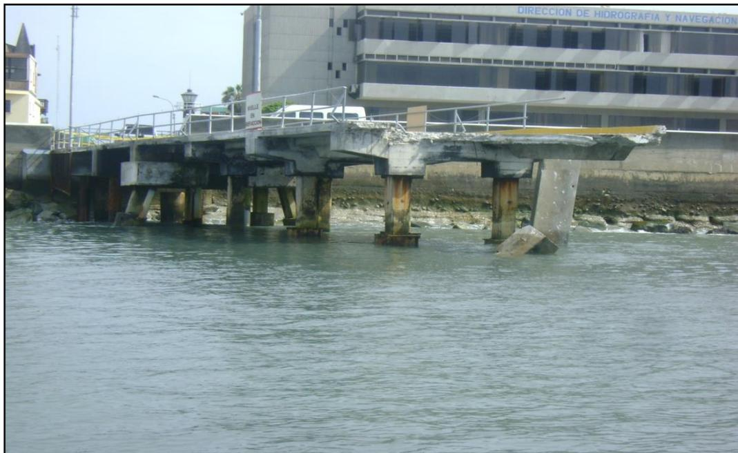
Figura 1.9. Muelle colapsado de la Dirección de Hidrografía y Navegación de la Marina de Guerra del Perú, Chucuito, Callao 2017.
