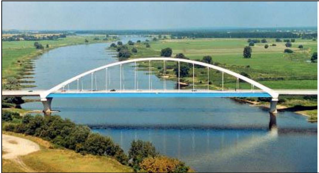
Figura 2.5. Puente en arco de tablero inferior sobre el río Elba, Tangermünde, Alemania.
