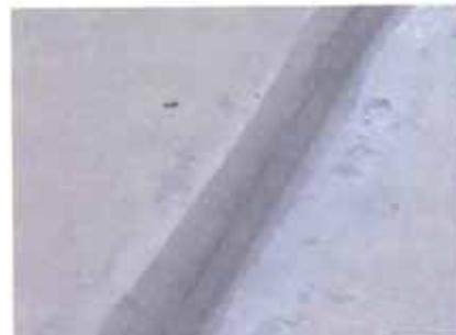
**Fotos CH-05.** Pruebas reales para seleccionar el producto a utilizar en los trabajos de mantenimiento. Los materiales propuestos como alternativa fallaron por adhesión y cohesión. (Canal Madre - Proyecto Especial Chavimochic).
