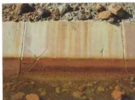
**Fotos RC-01.** Agrietamiento aleatorio del revestimiento
