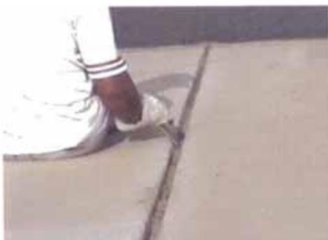
**Foto CH-08.** Retiro del material remanente de las superficies de la junta
