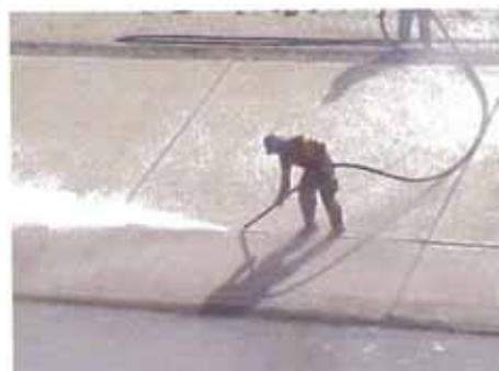
**Foto CH-09.** Arenado para el posterior sopleteado de juntas
