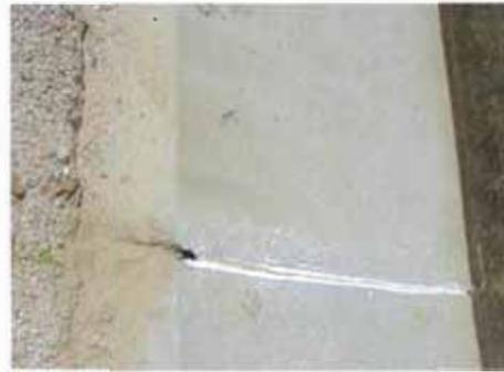
**Foto RC-09.** Insuficiente material y falta de apoyo sobre el material de respaldo.
