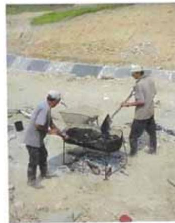
**Fotos AM-02.** Procedimiento de mezcla de asfalto con arena gruesa
