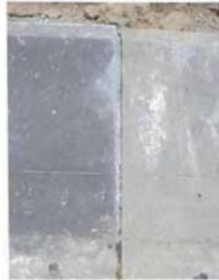
**Fotos AM-09.** Errores constructivos durante la elaboración de la junta: elaboración de juntas de expansión y la falta de continuidad del concreto entre paños continuos. (Canal Irrigación Progreso – Proyecto Especial Alto Mayo)
