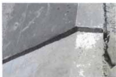
**Foto AM-05.** Sellador de mezcla asfáltica luego del procedimiento de instalación.
