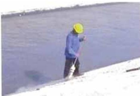
**Foto CH-06.** Barrido de la superficie del canal
