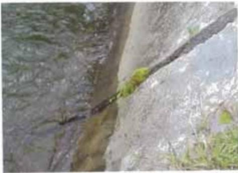
**Foto AM-08.** Falla del sellador de mezcla asfáltica por cohesión. Nótese la presencia de flora en la junta.
