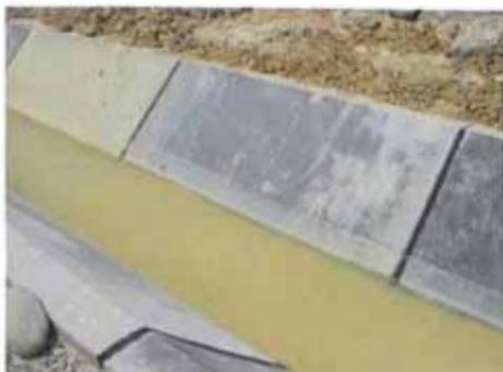
Foto CT-07. Juntas longitudinales sin sellar ubicadas en revestimientos construidos sobre zonas de arcillas expansivas. (Canal Principal Irrigación Progreso – Proyecto Especial Alto Mayo)
