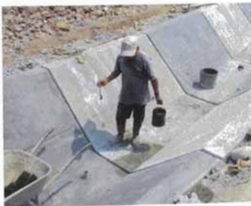
**Foto AM-10.** Afloramiento de agua en la junta. (Canal Irrigación Progreso – Proyecto Especial Alto Mayo).
