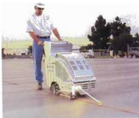
**Figura 1.8.** Junta aserrada
