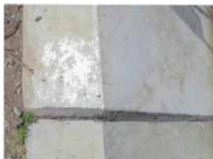
**Fotos RC-06.** Fallo del sellador de base poliuretano por cohesión y de la mezcla asfáltica por adhesión (Canal Derivador Cuchoquesera-Allpachaca – Proyecto Especial Río Cachi)
