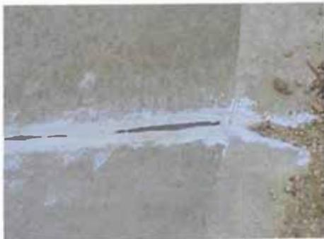
**Foto RC-12.** Exposición del material de respaldo
