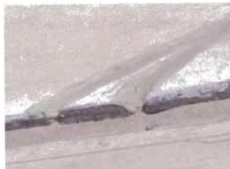
**Fotos CH-18.** Reparación de fisuras en el revestimiento del canal. Nótese como el sellador de base caucho-bituminoso ha fallado por adhesión y ha extrudido de la junta.
