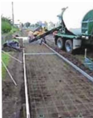
**Figura 1.6.** Junta premoldeadas
