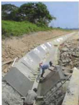
**Foto CT-01.** Los diferentes tonos de color que tiene el concreto del revestimiento demuestran la construcción del canal en paños alternados. (Canal Principal Irrigación Progreso – Proyecto Especial Alto Mayo)
