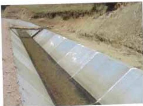
**Foto CT-04.** Revestimiento realizado a mano. Los diferentes tonos de color del concreto demuestran la construcción del canal mediante el sistema de paños alternados. (Canal Principal Colector Chiara-Chontaca – Proyecto Especial Río Cachi)
