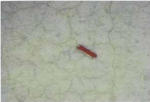
**Figura 2.5.** Fisuras por retracción por secado
