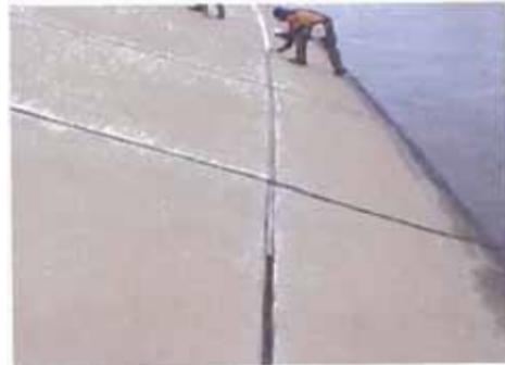
**Foto CH-15.** Colocación del sellador sobre el material de respaldo
