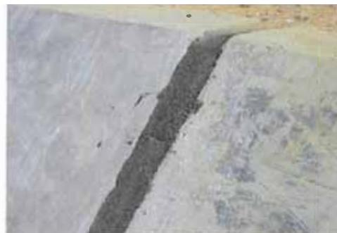
**Fotos AM-06.** Falla del sellador de mezcla asfáltica por adhesión
