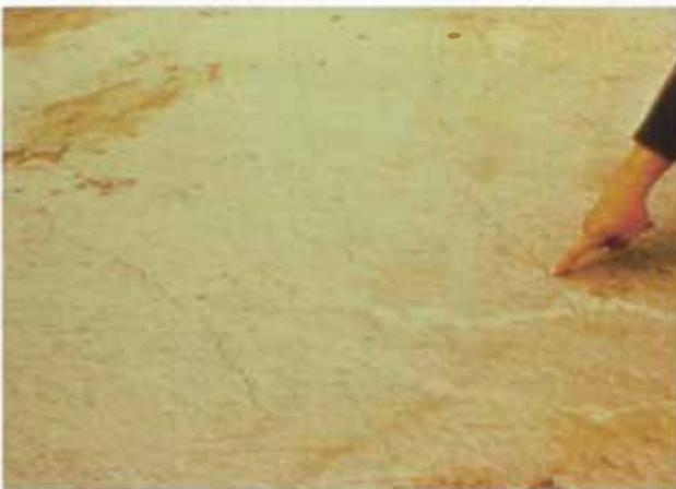
**Figura 2.3.** Grietas por retracción plástica
