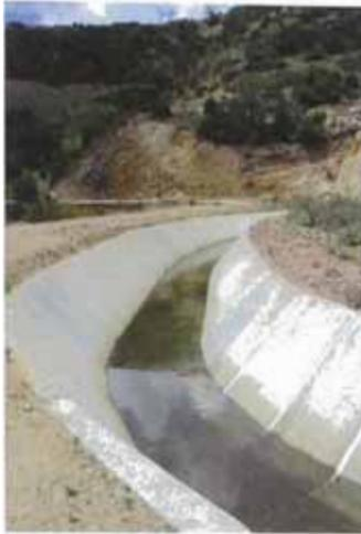
**Foto RC-07.** Sellado de juntas con un sellador de base poliuretano. (Canal Principal Colector Chiara-Chontaca – Proyecto Especial Río Cachi).
