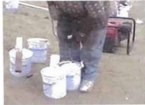
**Foto CH-13.** Mezcla mediante el batido de los 2 componentes del sellador de base poliuretano
