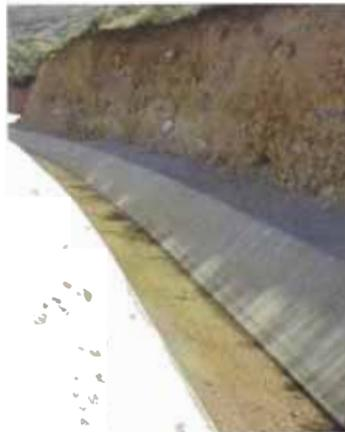
**Foto RC-16.** Ranuras longitudinales sin sellar. (Canal Principal Colector Chiara-Chontaca – Proyecto Especial Río Cachi).
