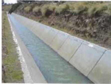
**Foto RC-04.** Juntas frías en la parte superior del revestimiento
