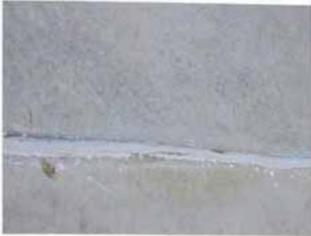
**Foto RC-08.** Falta de adhesión del sellador con los laterales de la junta
