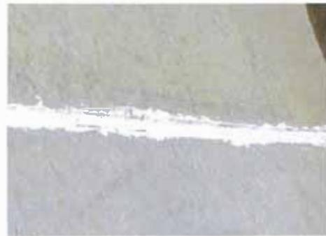
**Foto RC-11.** Presencia de burbujas de aire atrapadas dentro del sellador.
