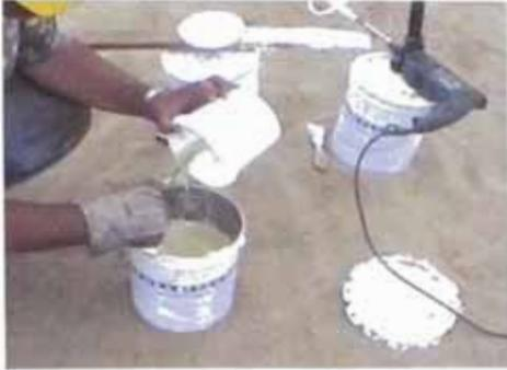
**Foto CH-12.** Mezcla manual de los dos componentes del sellador de base poliuretano
