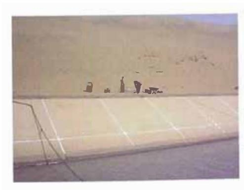
**Foto CT-06.** Revertimiento realizado con maquinaria de encofrado deslizante. La juntas horizontales como verticales se encuentran espaciadas a 4 m. aproximadamente entre i. (Canal Madre Zona Cortina Forestal 1-Estación La agonía – Proyecto Especial Chavimochic)
