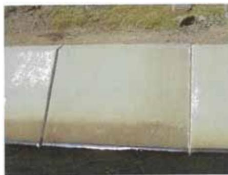
**Foto RC-05.** Fallo de ambos selladores en el zona de intercambio del material
