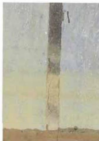
**Fotos AM-07.** Falla del sellador de mezcla asfáltica por extrusión y por cohesión
