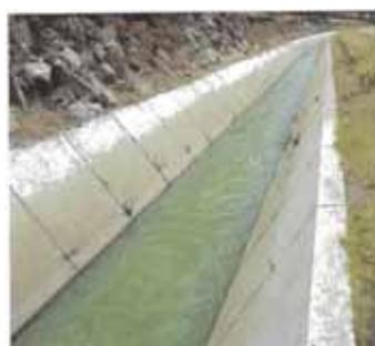
**Fotos RC-03.** Fallo del sellador por adhesión y presencia de flora en la junta
