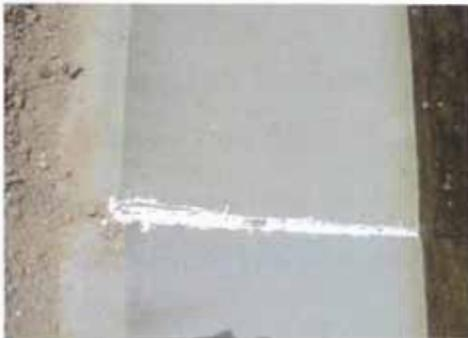
**Foto RC-10.** Colocación del sellador en exceso, sin un acabado final
