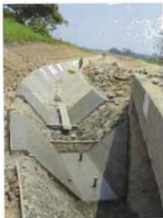
**Foto CT-02.** Revestimiento de dos paños separados a una distancia igual al ancho del paño. (Canal Principal Irrigación Progreso – Proyecto Especial Alto Mayo)
