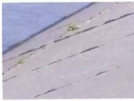
**Fotos CH-02.** Fallo por adhesión del sellador de base caucho-bituminoso. Nótese la acumulación de arena y la presencia de flora en las juntas. (Canal Madre, zona cortina Forestal Sector 1 – Proyecto Especial Chavimochic).
