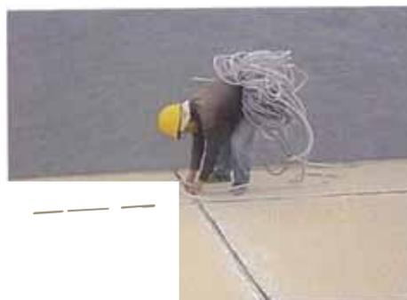
**Foto CH-11.** Colocación del material de respaldo
