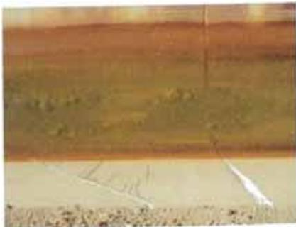
**Foto RC-02.** Reparación de grietas utilizando el sellador de base poliuretano utilizado en el sellado de las juntas. (Canal Derivador Colector Apacheta-Choccoro – Proyecto Especial Río Cachi).
