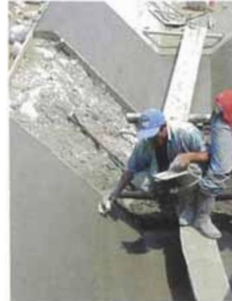
**Fotos AM-01.** Labrado de juntas longitudinales en zonas de arcillas expansivas
