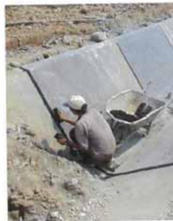
**Fotos AM-03.** Imprimación con brea y colocación de la mezcla asfáltica
