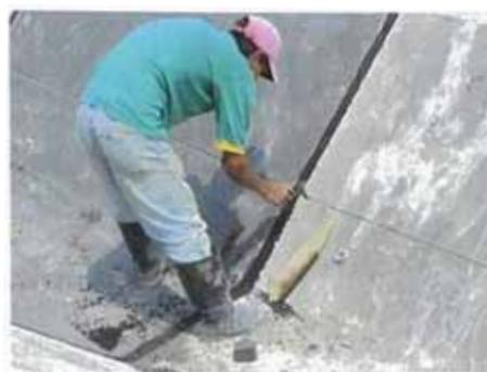
**Fotos AM-04.** Compactación de la mezcla asfáltica y retiro del excedente
