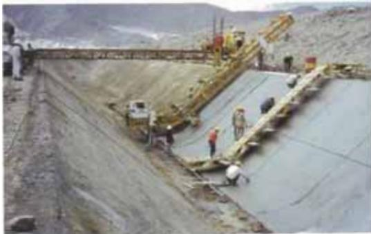
**Foto CT-05.** Revestimiento realizado con maquinaria de encofrado deslizante. Las juntas horizontales y verticales son elaboradas por la maquinaria durante el revestimiento del canal. (Foto cortesía de GOMACO Internacional Ltd.)
