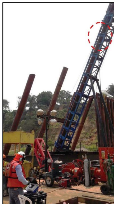
Fotografía N°4. Vista de puntal 121 - Espigón 10
