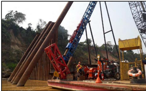
Fotografía N°12. Vista de puntal 81 - Espigón 11 (2)
