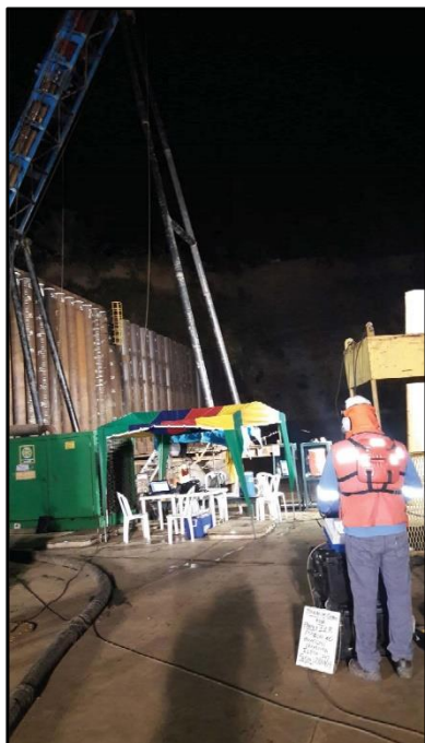
Fotografía N°1. Vista de puntal 118 - Espigón 10
