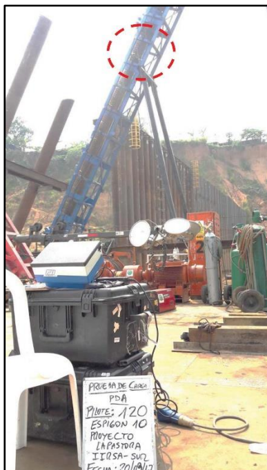
Fotografía N°3. Vista de puntal 120 - Espigón 10
