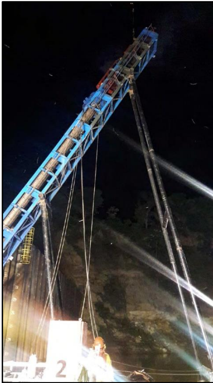
Fotografía N°8. Vista de puntal 79 - Espigón 11
