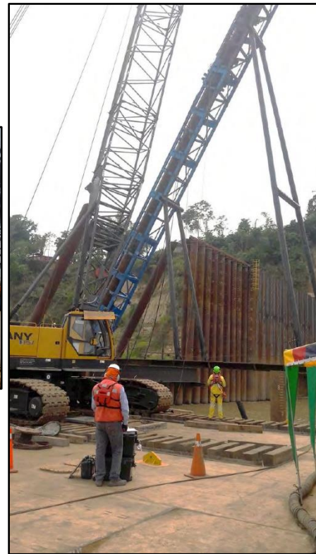
Fotografía N°13. Vista de puntal 82 - Espigón 11
