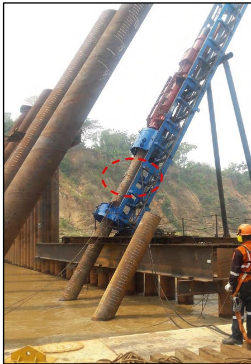
Fotografía N°6. Vista de puntal 123 - Espigón 10
