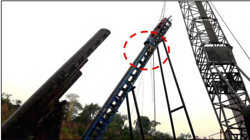
Fotografía N°5. Vista de puntal 122 - Espigón 10
