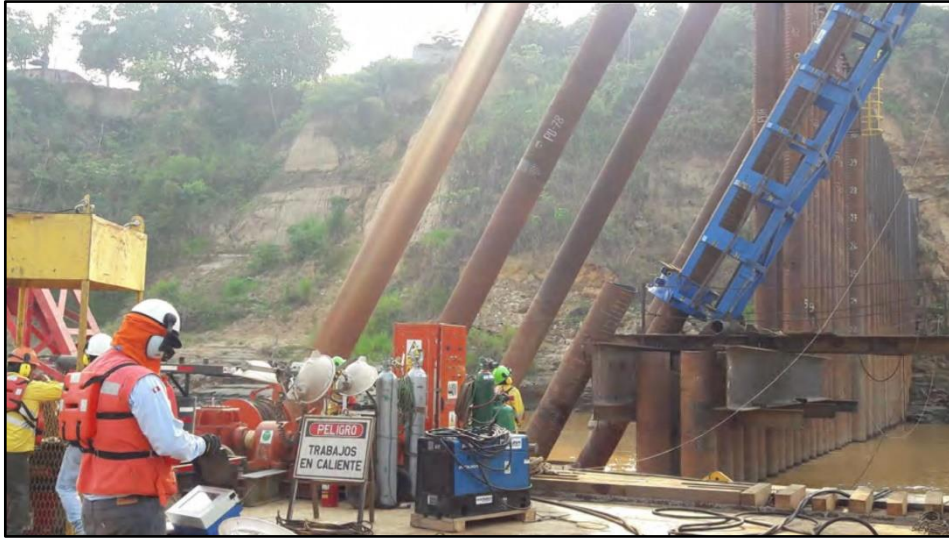
Fotografía N°11. Vista de puntal 81 - Espigón 11 (1)
