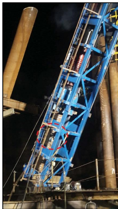
Fotografía N°2. Vista de puntal 119 - Espigón 10
