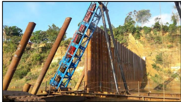
Fotografía N°9. Vista de puntal 80 - Espigón 11 (1)
