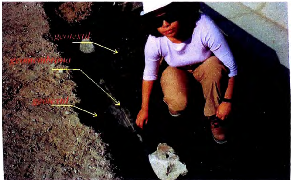
En la foto se muestra la geomembrana cubierta por el geotextil
