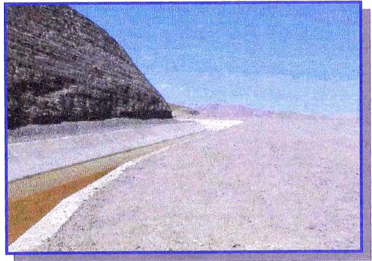
Vista del canal aguas abajo del conducto cubierto, en buen estado desde 7+480 al 7+631.12
