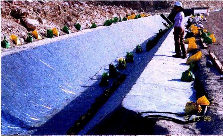
En esta vista se puede observar la geomembrana puesta en obra
