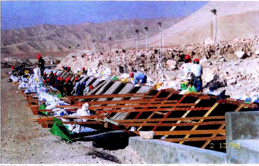
se aprecia el encofrado especial utilizado con el fin de no dañar la geomembrana
