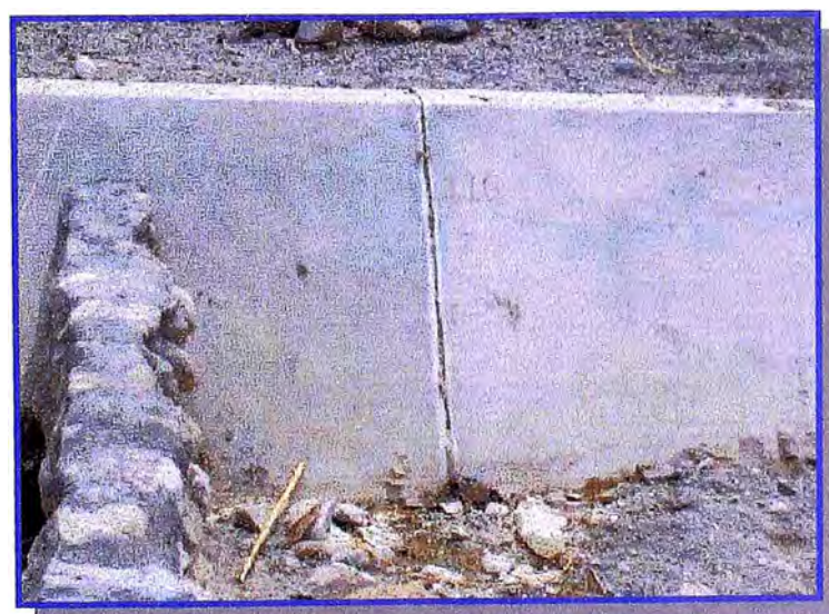
Muro de albañilería rustico provisional para proteger los tramos de canal bueno de la invasión del agua, captándolos a través de una tubería.
