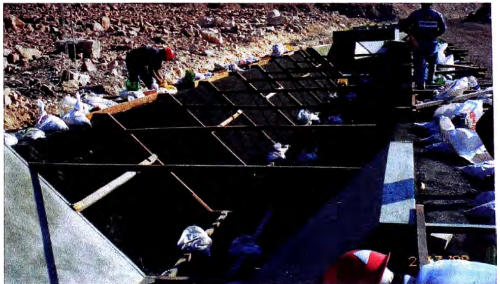
En esta foto se aprecia el geotextil superior
