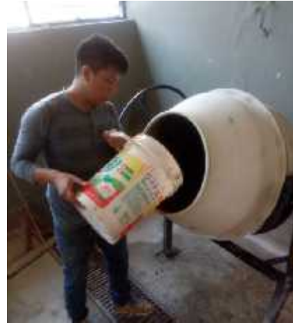
FIGURA F.7 Mezcla de materiales para la elaboración de concreto en el LEM.
