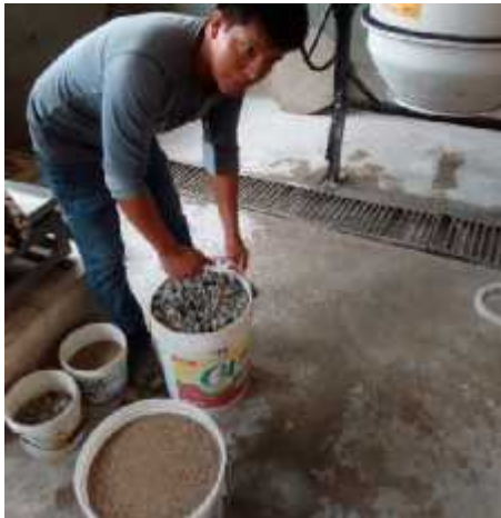
FIGURA F.7 Insumos para la elaboración de concreto debidamente dosificados.
