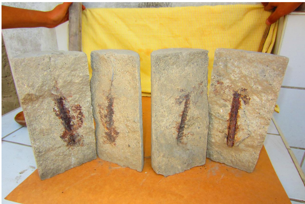
Acero de refuerzo
