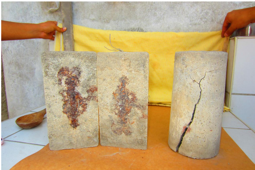
Probetas fracturadas y acero de refuerzo
