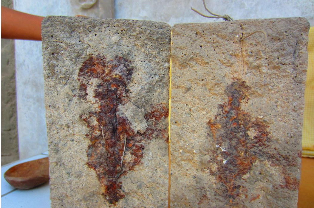
Acero de refuerzo
