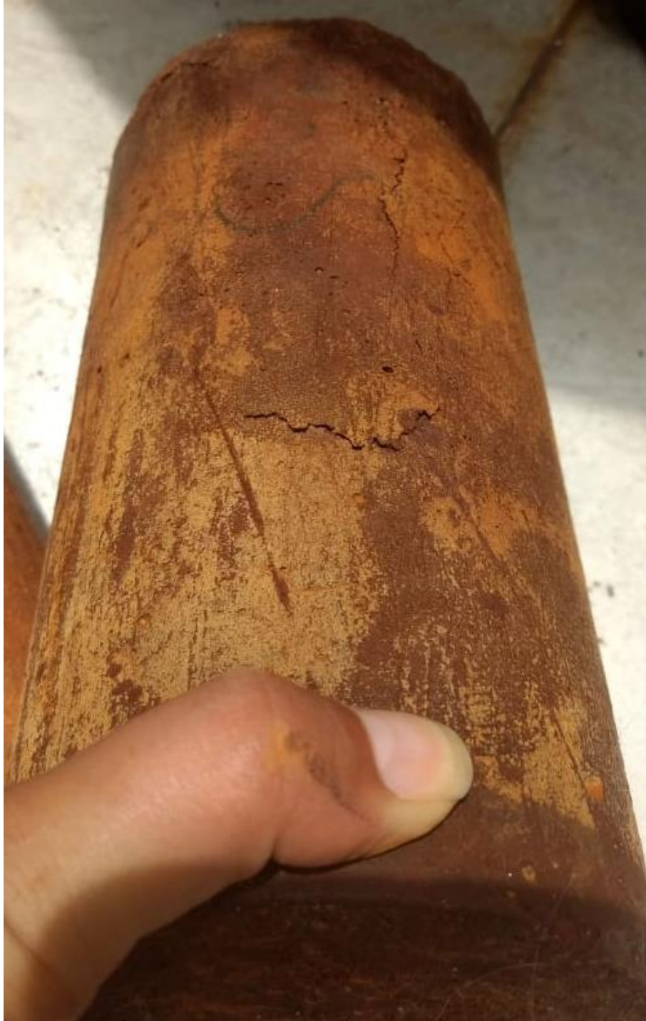
Ciclo 25: Hinchazón de áreas agrietadas
