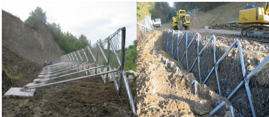
Figura N°5.2 Estructuras Metálicas para consolidación de suelos. Fuente: Empresa Inaccés Geotécnica Vertical S.L (Barcelona).
