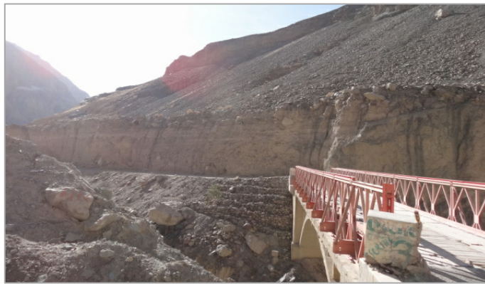
Figura N°3.2 Vista del Puente El Chorro II.
