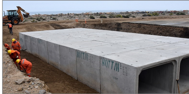
Figura N°5.1 Alcantarillas Prefabricadas de Concreto. Fuente: Empresa Bottai Soluciones en concreto (Chile).
