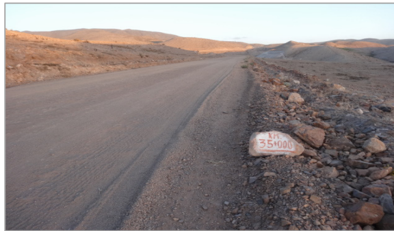
Figura N°2.3 Progresiva Km 35+00 – Vista del Tramo. Fuente: Expediente Técnico Moquegua – Omate
