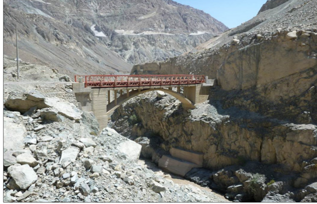
Figura N°4.2 Vistas actual del Puente Chorro II, Km 75+950 Fuente: Expediente Técnico del proyecto: Moquegua – Omate
