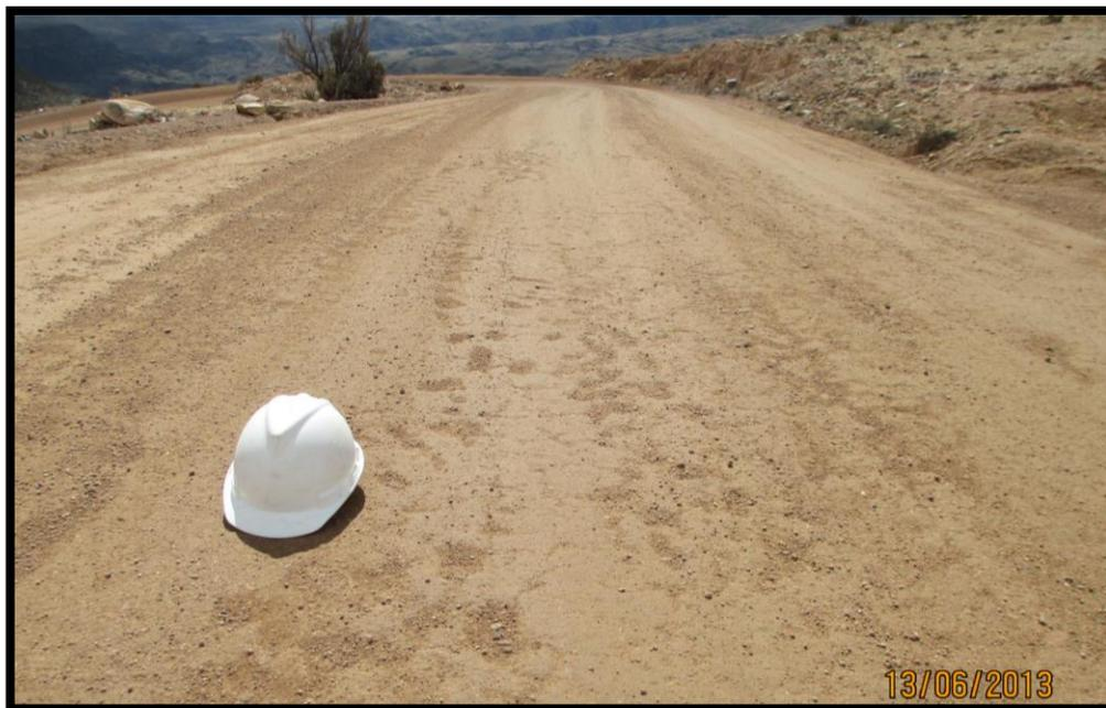
Figura N°19: Estado del sub tramo 2 estabilizado con Proes a 14 días. Fuente: Elaboración propia.
