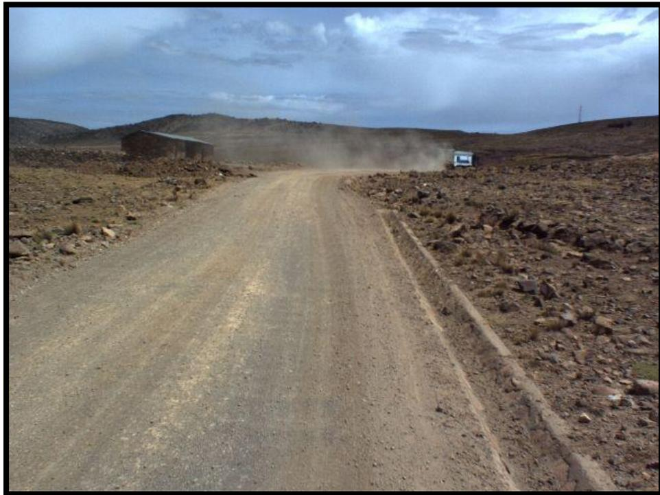
Figura N°2: Polvo y desprendimiento de afirmado en tramo I. Fuente: Plan de Conservación Proyecto Coracora.
