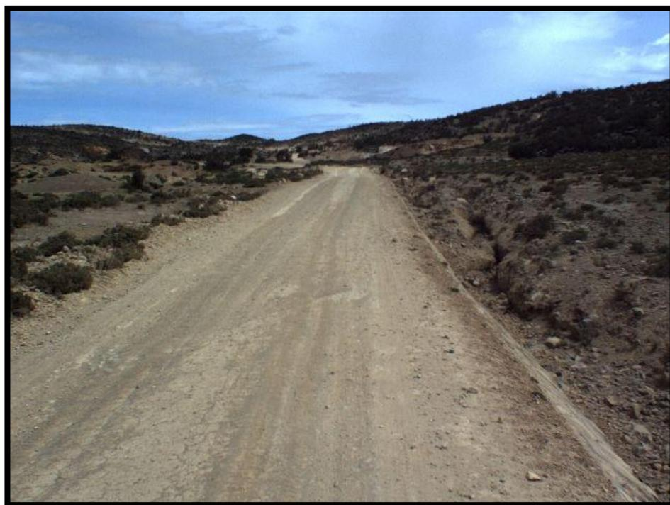
Figura N°3: Falta de señalización y elementos de seguridad en tramo I. Fuente: Plan de Conservación Proyecto Coracora.
