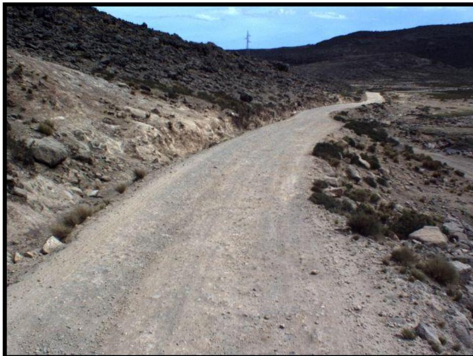
Figura N°4: Falta de mantenimiento en cunetas del tramo I. Fuente: Plan de Conservación Proyecto Coracora.
