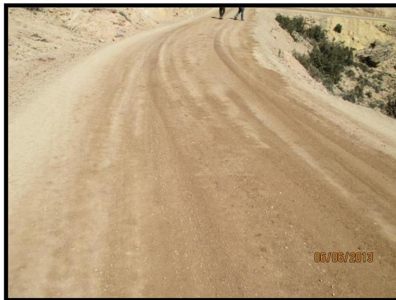
Figura N°18: Estado del sub tramo 2 estabilizado Proes a los 7 días. Fuente: Elaboración propia.
