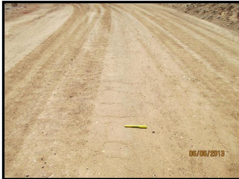
Figura N°17: Estado del sub tramo 1 estabilizado con Proes a los 7 días. Fuente: Elaboración propia.
