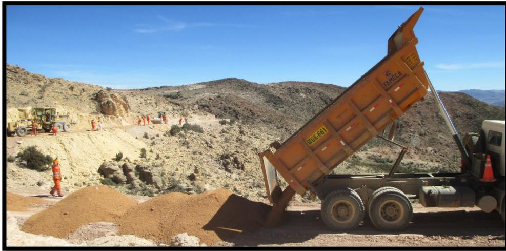
Figura N°26: Colocación de material de préstamo. Fuente: Elaboración propia.
