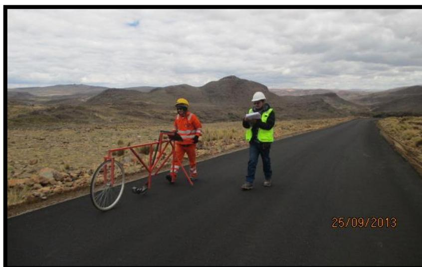
Figura N°33: Medición de IRI con equipo MERLIN. Fuente: Elaboración propia.
