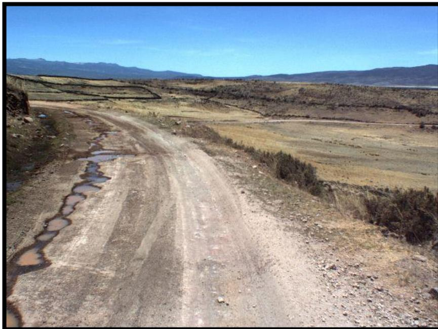
Figura N°7: Presencia de baches en berma y calzada del tramo II. Fuente: Plan de Conservación Proyecto Coracora.
