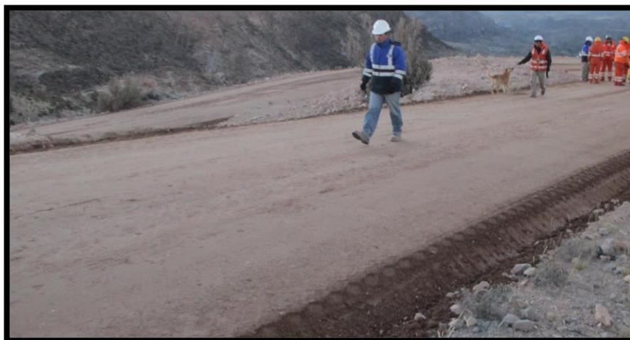
Figura N°16: Acabado final de la base estabilizada. Fuente: Elaboración propia.
