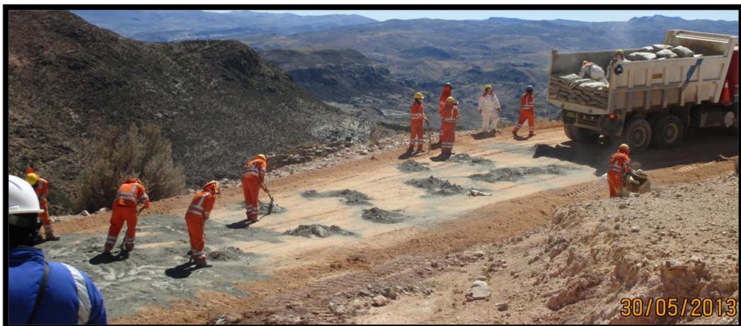
Figura N°27: Colocación y esparcido de bolsas de cemento. Fuente: Elaboración propia.
