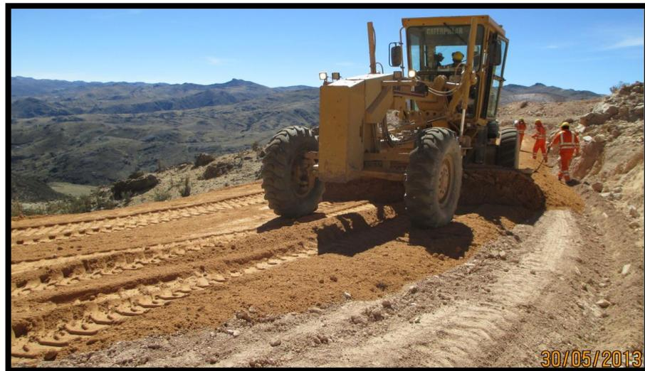
Figura N°28: Mezcla de material de escarificado, préstamo y cemento. Fuente: Elaboración propia.
