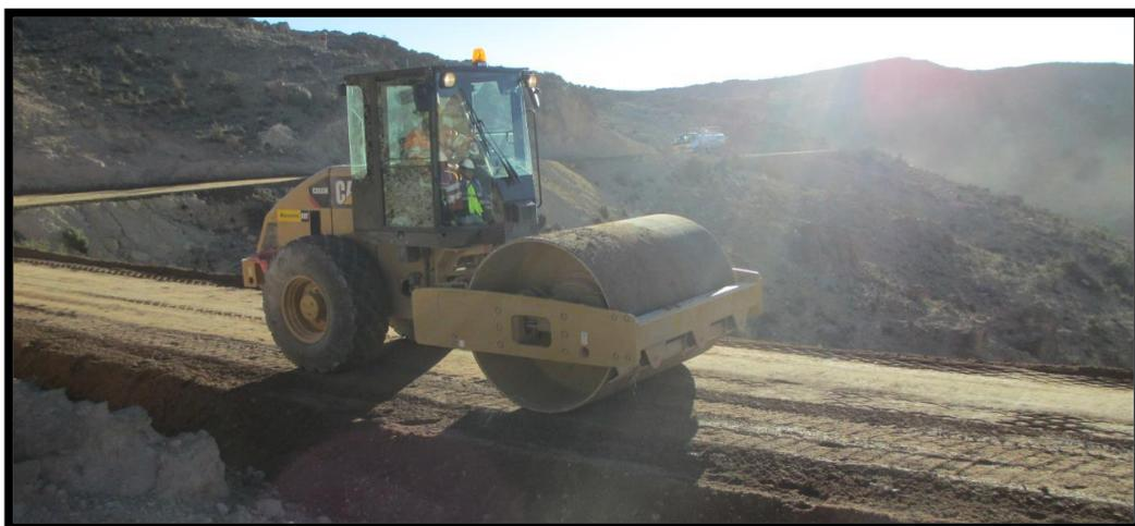
Figura N°30: Compactación de base estabilizada. Fuente: Elaboración propia.
