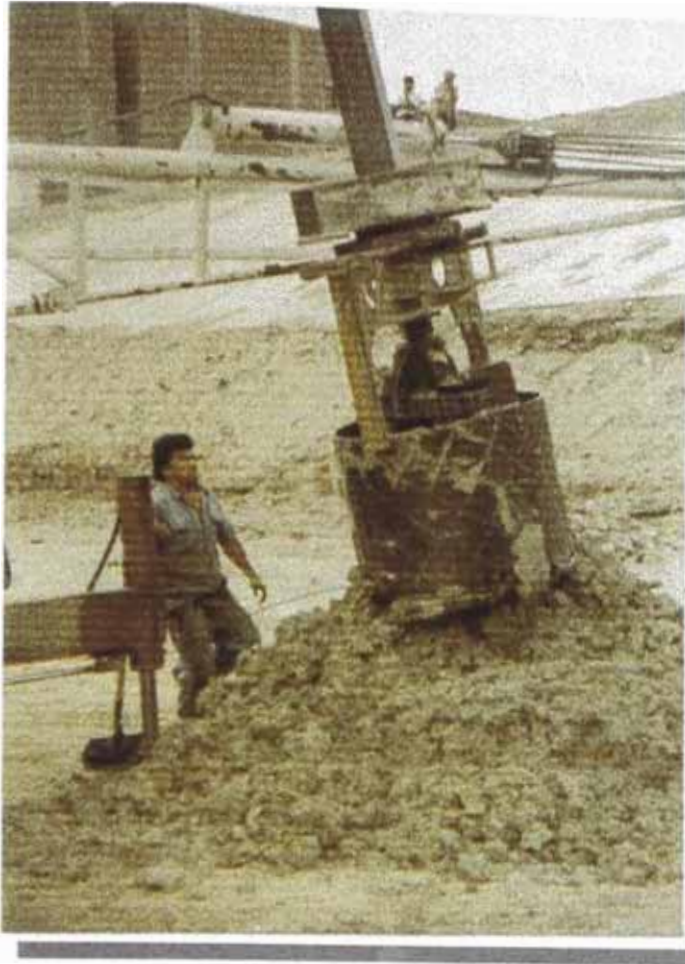
Excavación de pilotes Puente Piura - Perú
