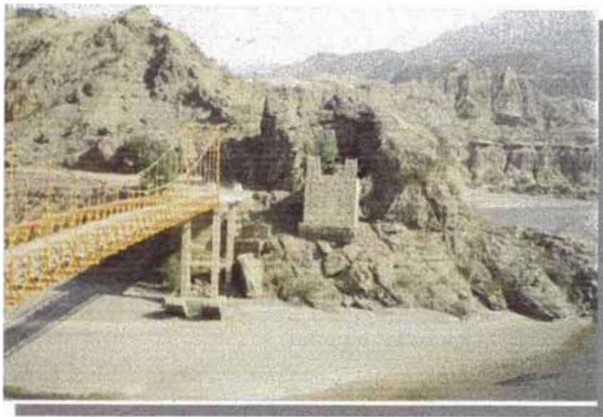
Puente colgante, pilares aporticados Puente Mayoc - Perú
