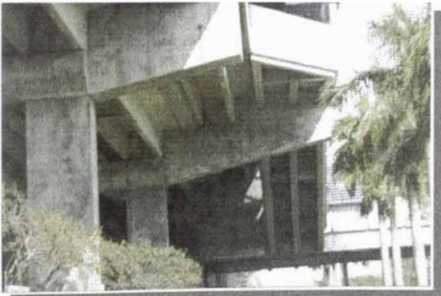
Pilares tarjeta con grandes voladizos postensados - USA
