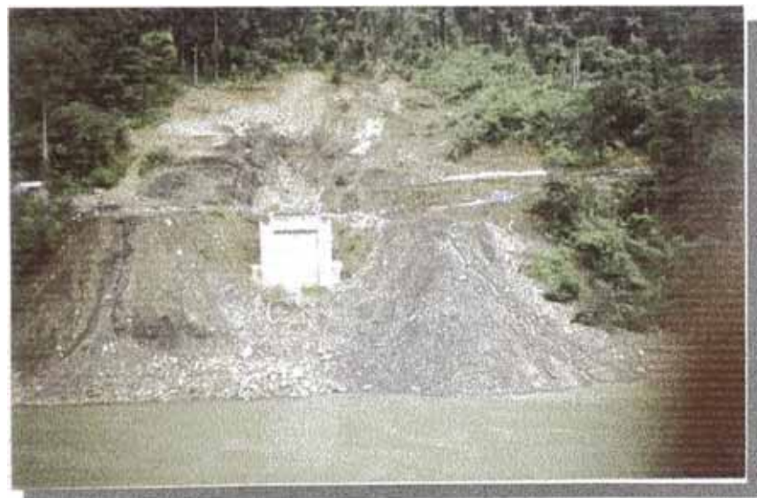
Cámara de anclaje. Puente colgante en Madre de Dios - Perú
