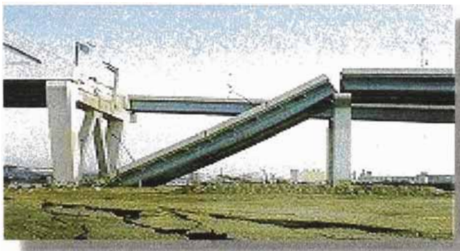
Puente donde ha fallado la cimentación por sismo, provocando el colapso de la superestructura
