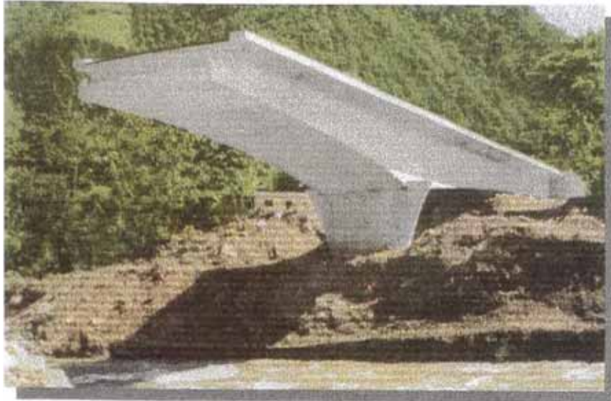
Puente tipo Gerber en voladizo de tres tramos, caissons circulares Puente Cayumba-Perú
