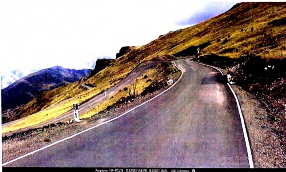
Figura N° 25 Progresiva 164+972- Orografía tipo 2.
