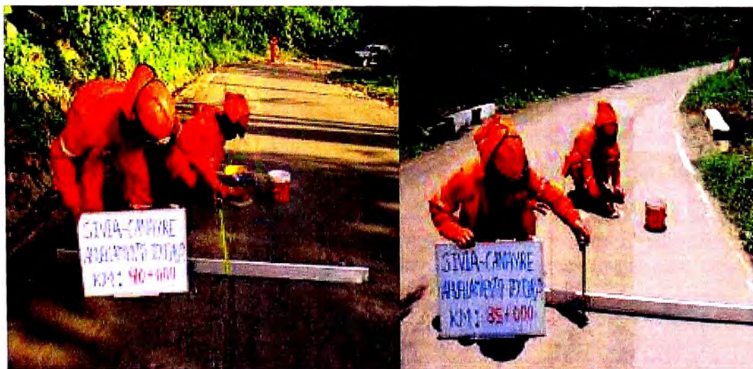
Figura N° 97 Medición de macrotextura con círculo de arena Tramo II.
