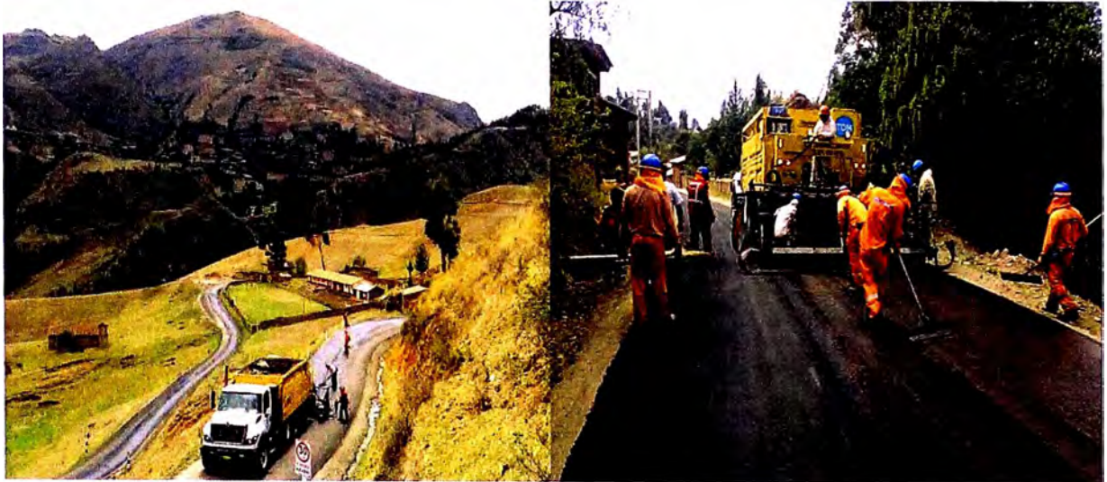
Figura N° 13 Abastecimiento de materiales a camión Micropavimentador.
