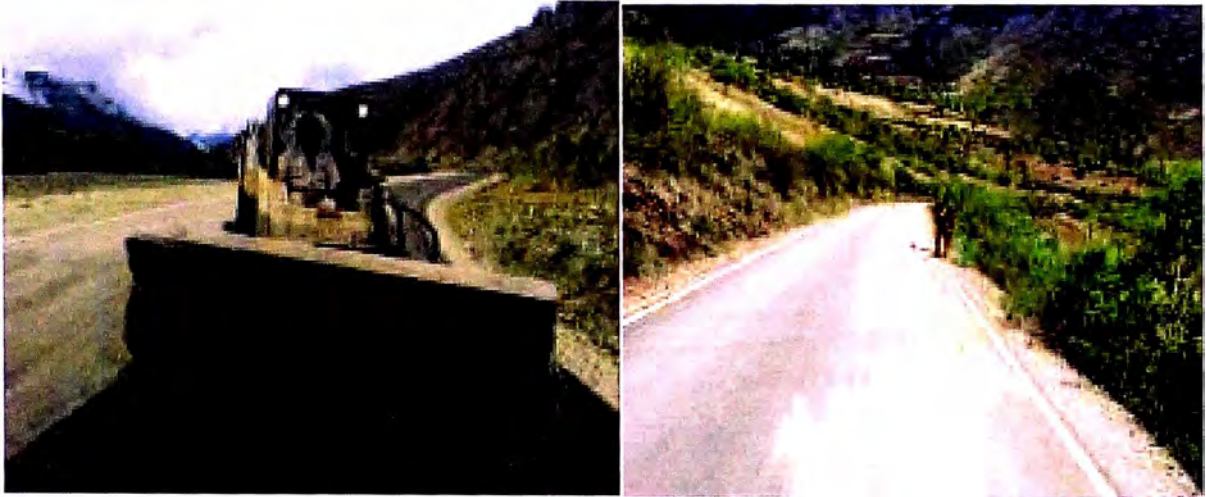
Figura N° 11 Limpieza de plataforma para aplicación de Slurry Seal.
