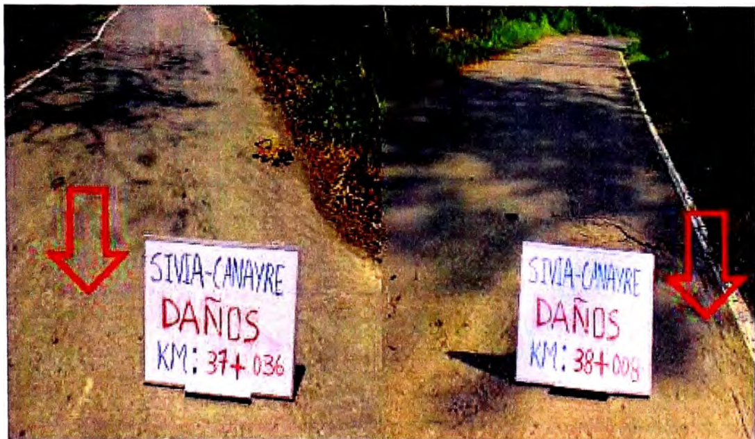
Figura N° 82 Influencia de la falta de subdrenaje.
