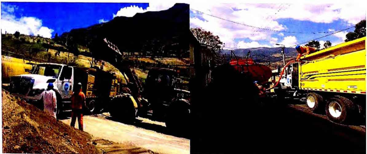
Figura N° 12 Abastecimiento de materiales a camión Micropavimentador.
