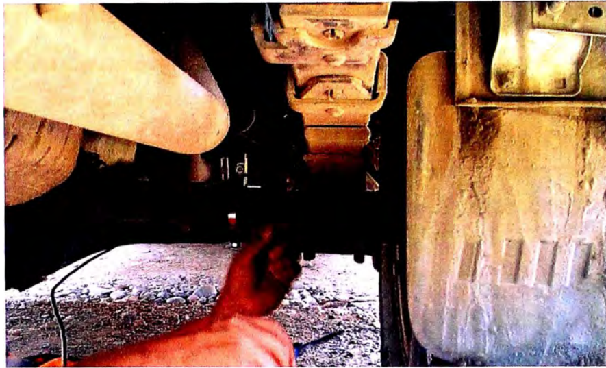
Figura N° 50 Instalación de acelerómetro.
