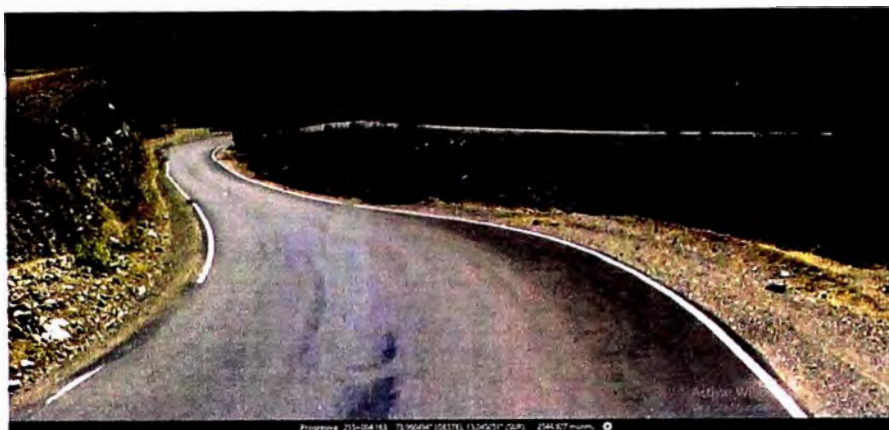
Figura N° 28 Progresiva 215+004- Orografía tipo 2.
