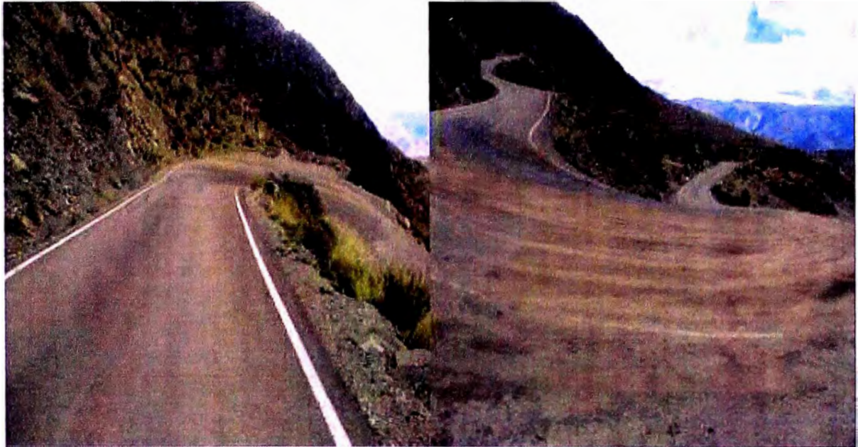
Figura N° 58 Radios Reducido en Curvas Horizontales.
