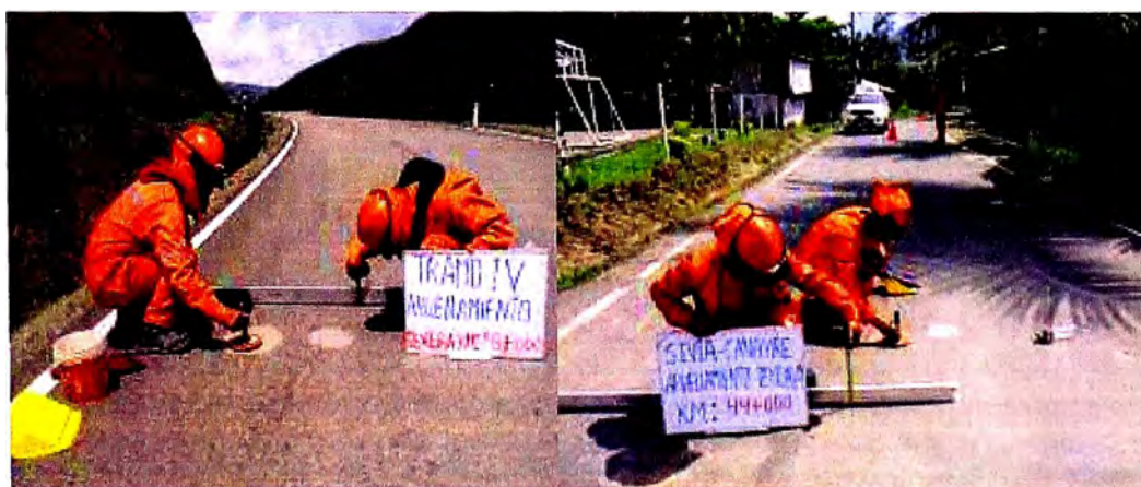
Figura N° 94 Proceso de medición de macrotextura.
