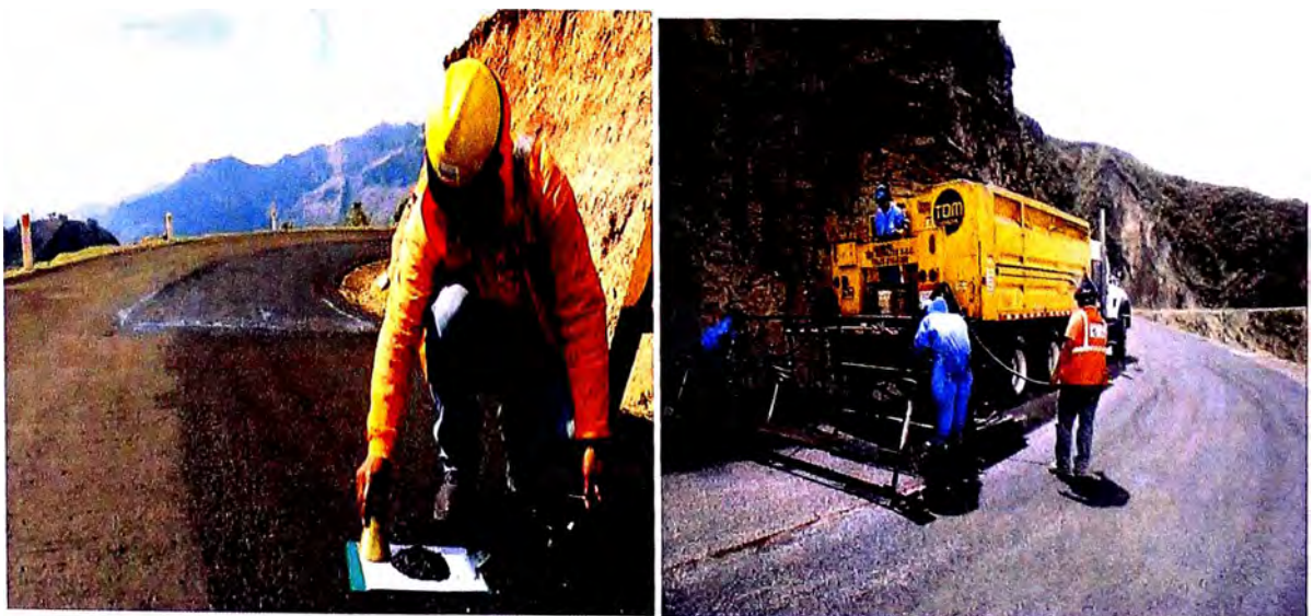
Figura N° 14 Controles de calidad en el Slurry Seal.
