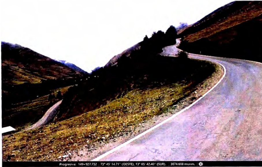
Figura N° 24 Progresiva 149+927- Orografía tipo 2.
