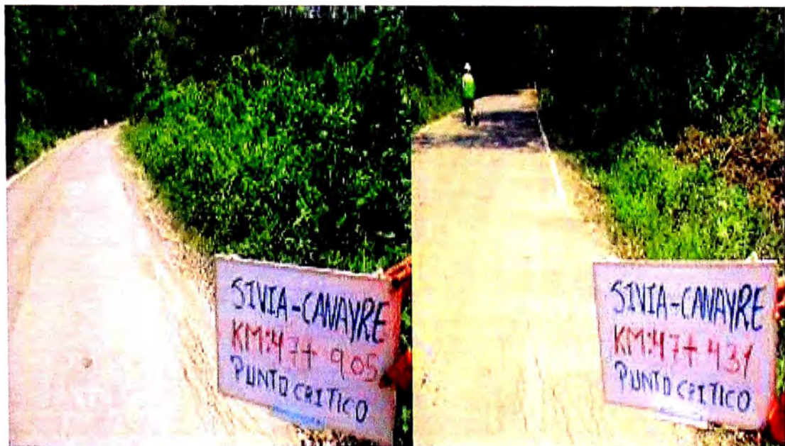
Figura N° 87 Falta de subdrenaje.
