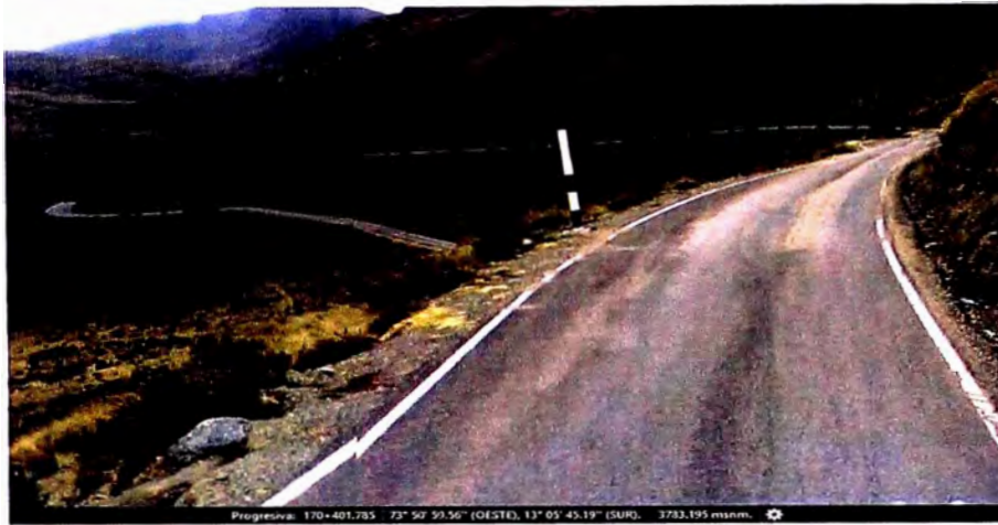
Figura N° 26 Progresiva 170+401- Orografía tipo 3.
