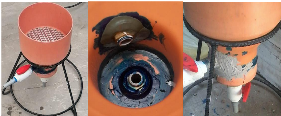
Fotografía 10.9 Impermeabilización de niples de ingreso en reducción 8"x4" y del tapón de 4"
