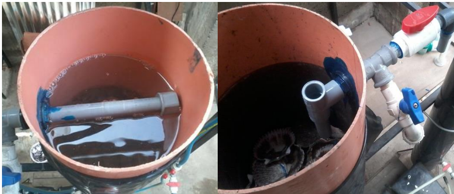
Fotografía 10.8 Cambio de recolector de efluente de los filtros.
