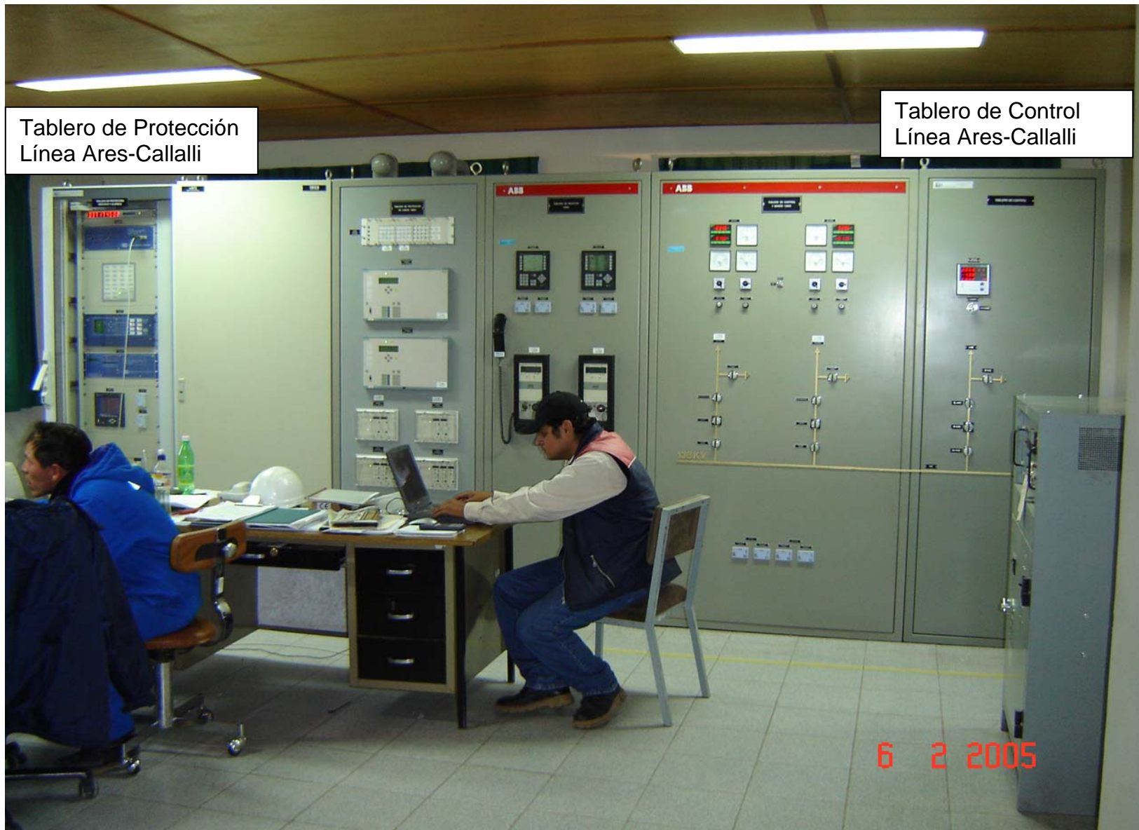
Figura 3.9 Tableros de protección y control subestación Callalli
