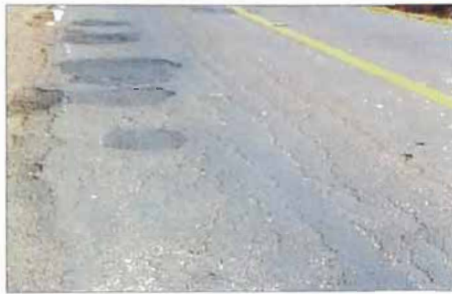
Figura 6.1.- Agrietamiento Longitudinal
