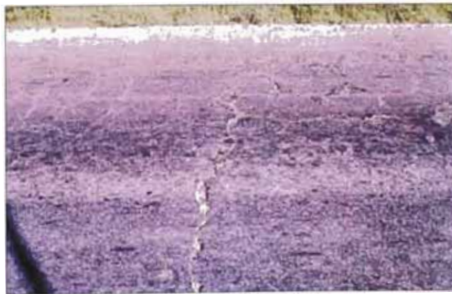
Figura 6.2.- Agrietamiento Transversal
