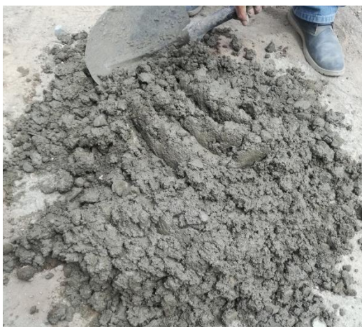
Figura A6.20 Concreto mezclado en terreno natural.
