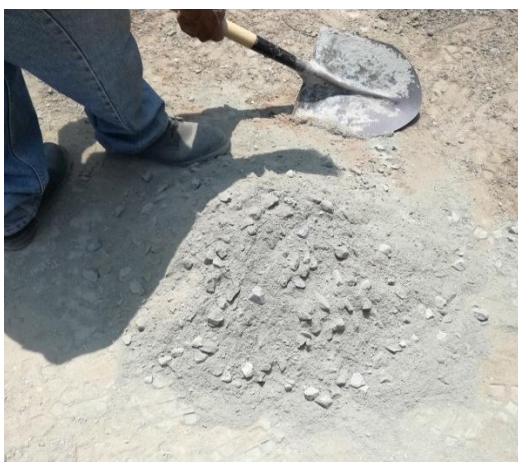
Figura A6.19 Preparación de mezcla en terreno natural.
