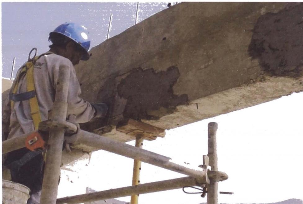
Figura N° 52 Aplicación de segunda capa de mortero de reparación y acabado final.
