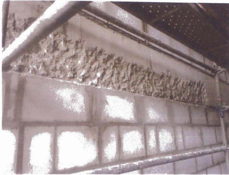
**Picado de superficie desplomada con exceso de recubrimiento presente en viga.**
