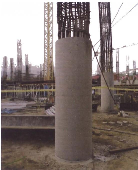
Figura N° 13 Elemento encofrado con molde hermético de una sola unión.
