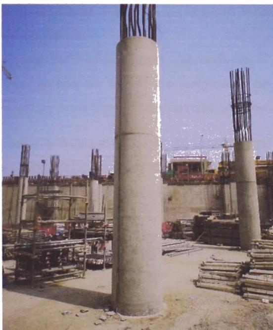
Figura N° 14 Elemento de doble altura encofrado con molde hermético de una sola unión.
