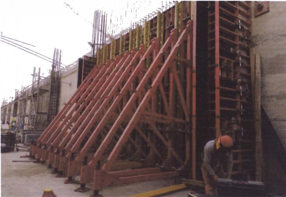
Figura N° 10 Modulación correcta para encofrado de placa contramuro.
