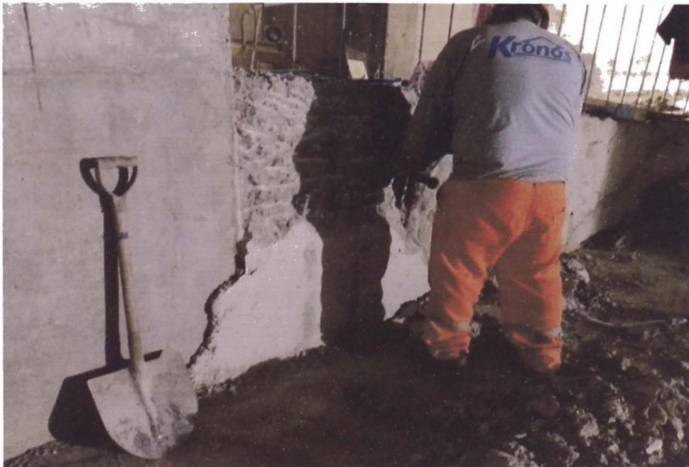
Figura N° 54 Picado de superficie desplomada en muros.
