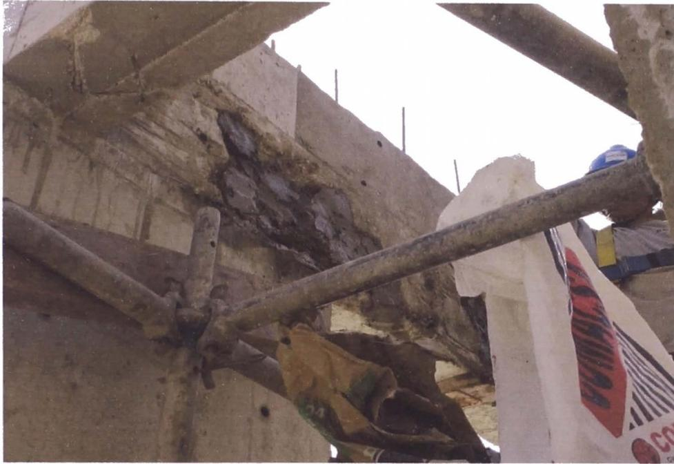
Figura N° 51 Aplicación de primera capa de mortero de reparación en cangrejera de viga.
