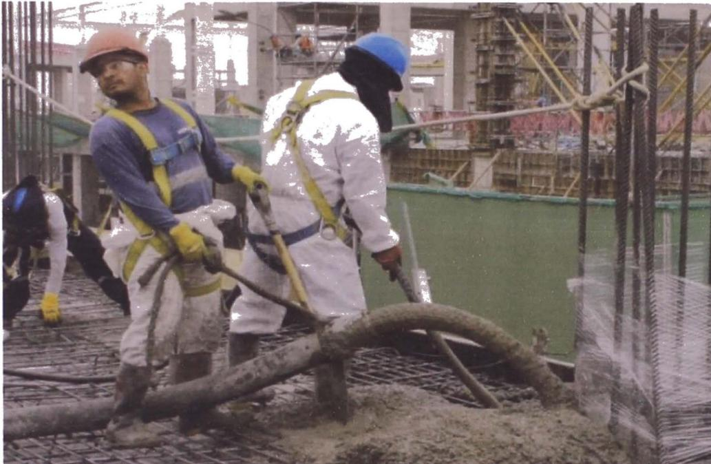
Figura N° 20 Tren de colocación del concreto en una losa.
