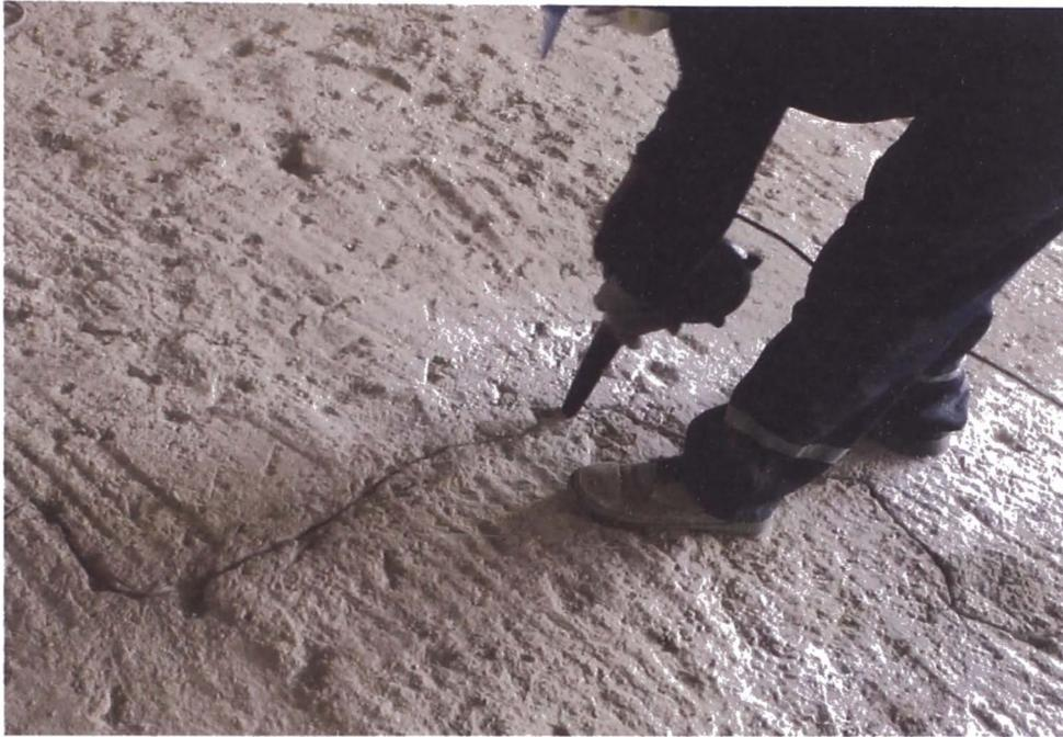
Figura N° 60 Limpieza de fisura perfilada con soplador eléctrico.
