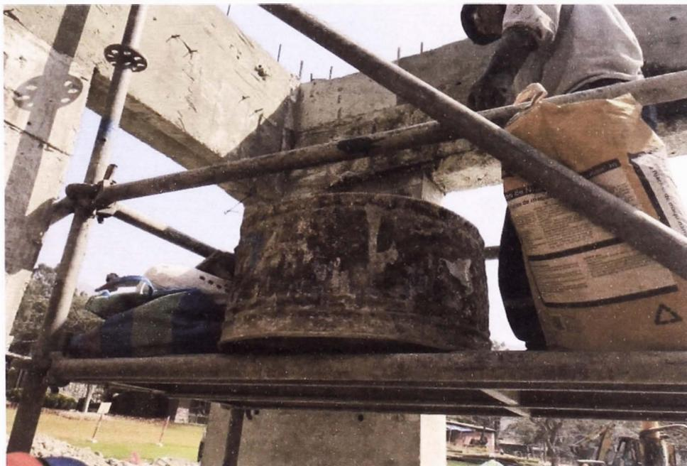
Figura N° 50 Preparación de mortero de reparación.
