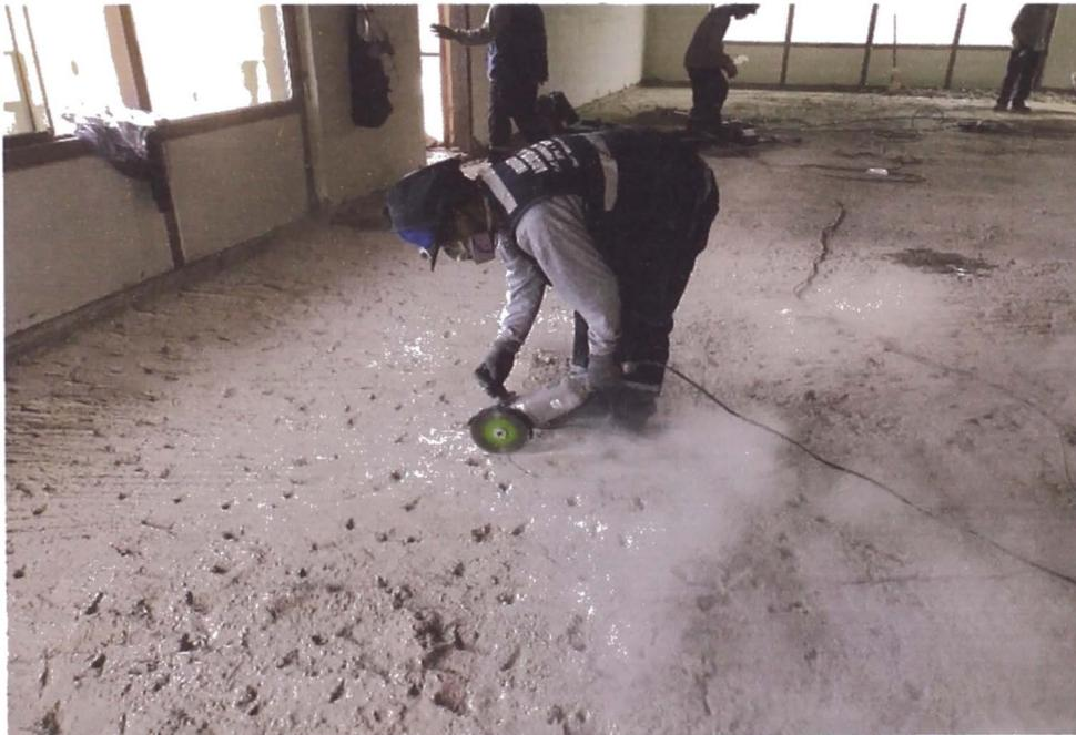
Figura N° 57 Perfilado y apertura de fisura con amoladora.
