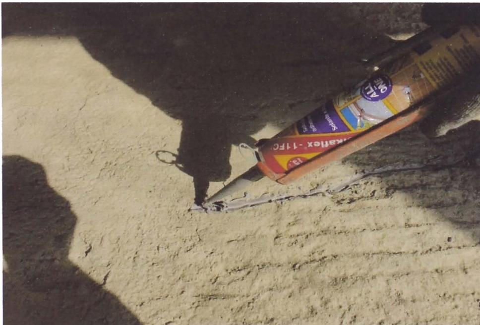
Figura N° 61 Aplicación de Sikaflex 11FC en fisura.
