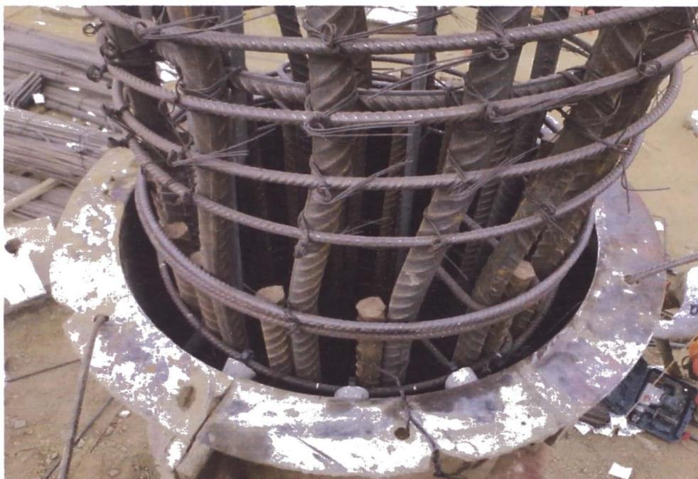
Figura N° 5 Correcto grifado de acero para empalme en columna
