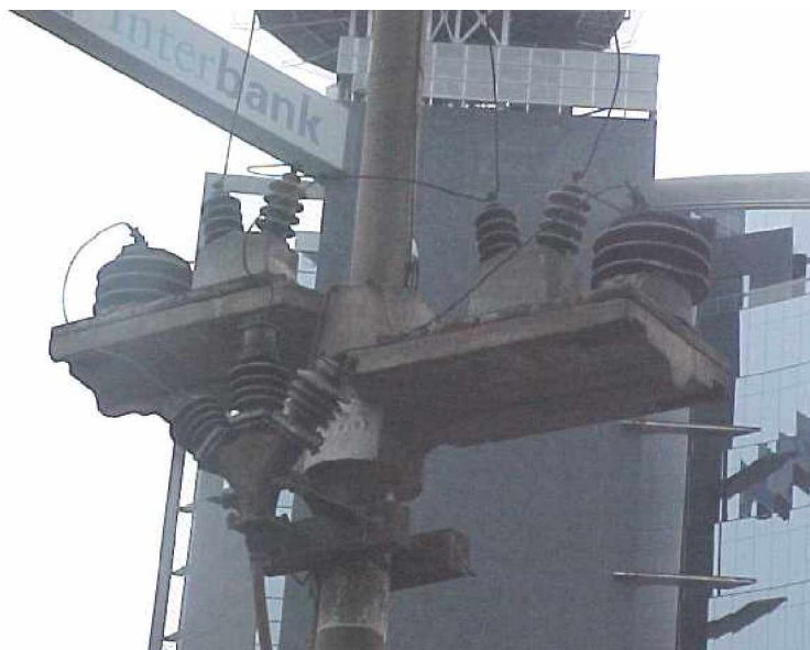
Figura 4.18 Circuito de medición de un cliente, tipo PMI. En ella se observan los TC's y TP's.
