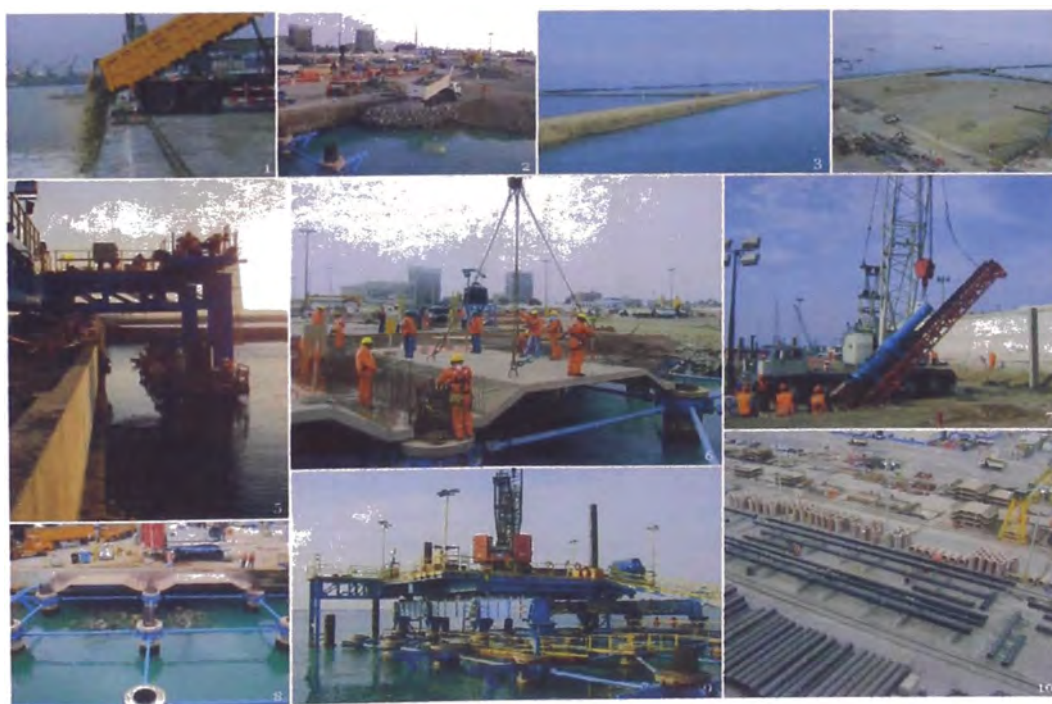
Ilustración 48: Proceso constructivo mediante pilotes de acero hincados. Obra: ampliación del Muelle Sur - Callao.
