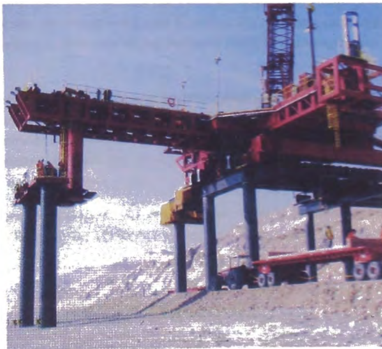
Ilustración 49: Proceso de hincado del pilote.
