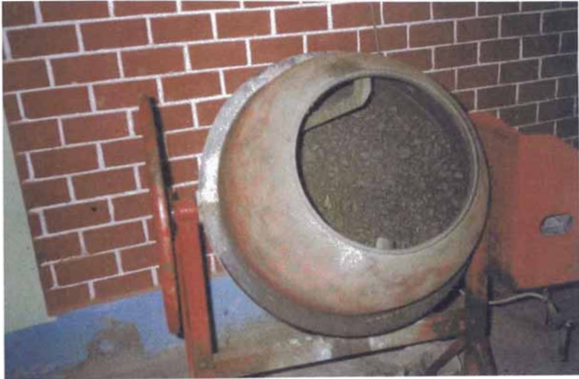
FOTO No 22 FABRICACION DE CONCRETO SIN ADITIVO
