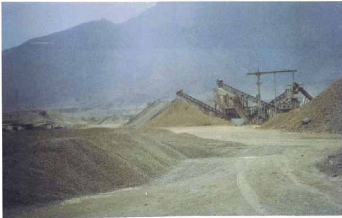
FOTO No 7 CHANCADORA SECUNDARIA Y ALMACENAMIENTO DEL AGREGADO GRUESO CANTERA JICAMARCA – PROPIEDAD DE UNICON
