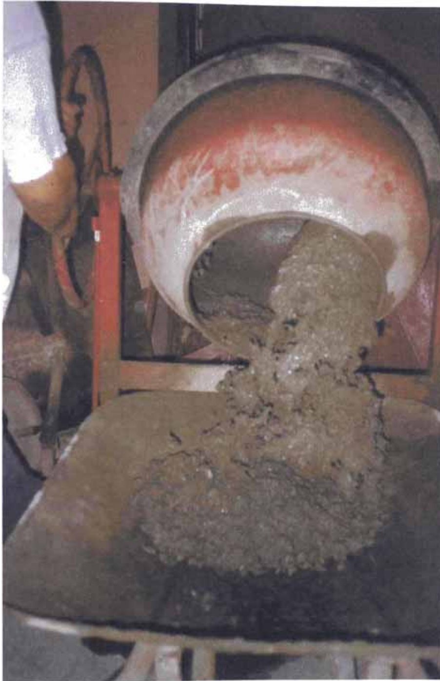
FOTO No 23 FABRICACION DE CONCRETO CON ADITIVO RHEOBUILD 1000
