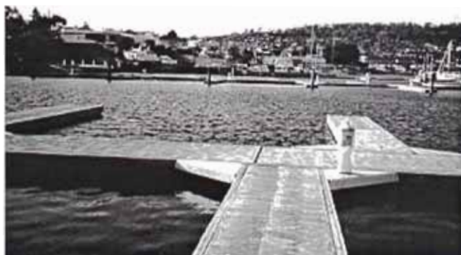
Figura 3.3 Puerto deportivo Lindisfarne Motor Yacht Club (Australia) que tiene un total de 120 atracaderos e incorpora 240 pontones flotantes de concreto prevaciado.
