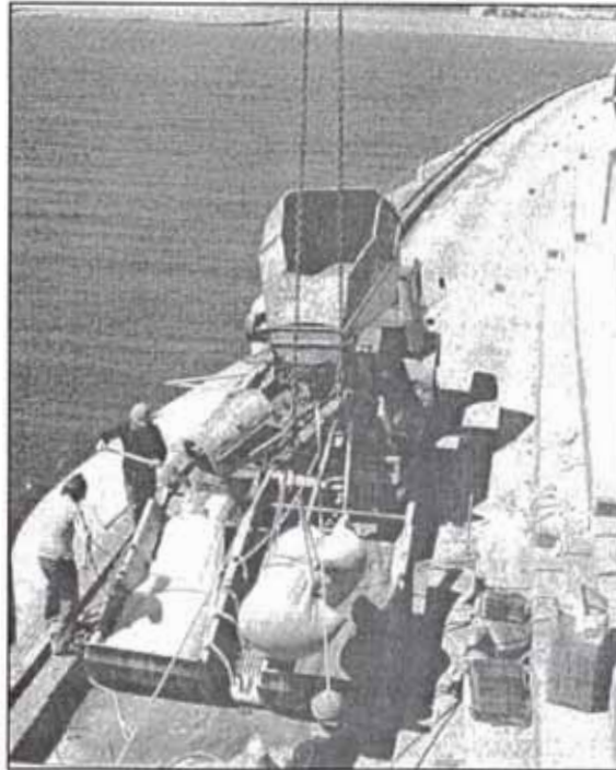
Figura 2.2.- Llenado del bagwork con concreto, usando una mezcladora.
