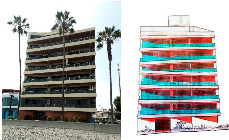
Figura N° 3.4 Vista frontal de la estructura en estudio ubicado a 35m de la orilla del mar, la imagen derecha es del plano arquitectónico del Edificio LP.
