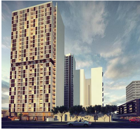
Figura N° 3.9 Fachada del Proyecto Multifamiliar Duplo. Fuente: www. Duplo.pe
