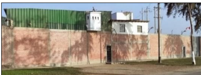
Figura N°6.3 Fábrica de conservas Cynara, Centro Poblado Cerro Alegre
