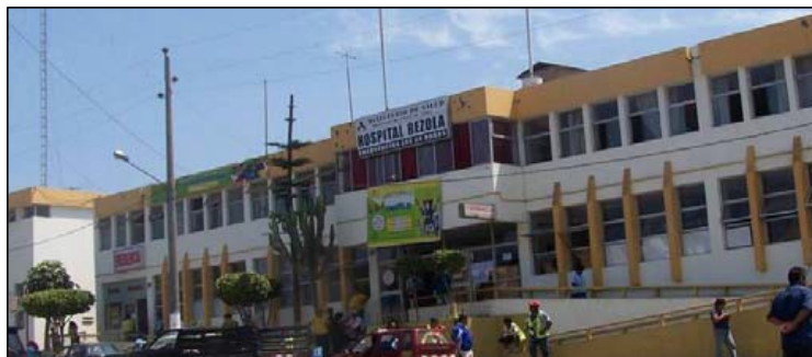
Figura N°6.17 Hospital de Apoyo Rezola, San Vicente de Cañete
