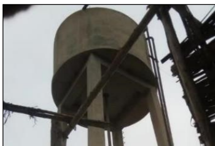
Figura N°6.14 Reservorio N°01 al lado derecho del Río Pócolo, Cerro Alegre
