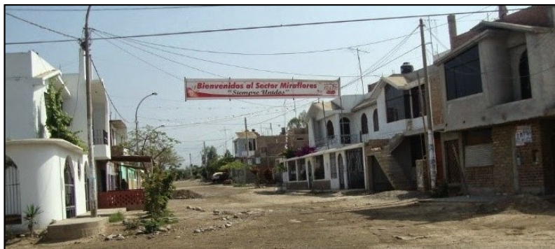
Figura N°9.2 Pasaje sin asfaltar en Cerro Alegre.
