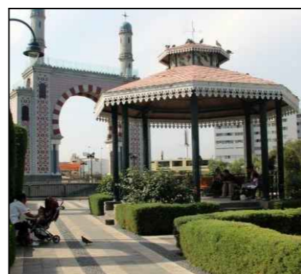
PÉRGOLA DE MADERA
