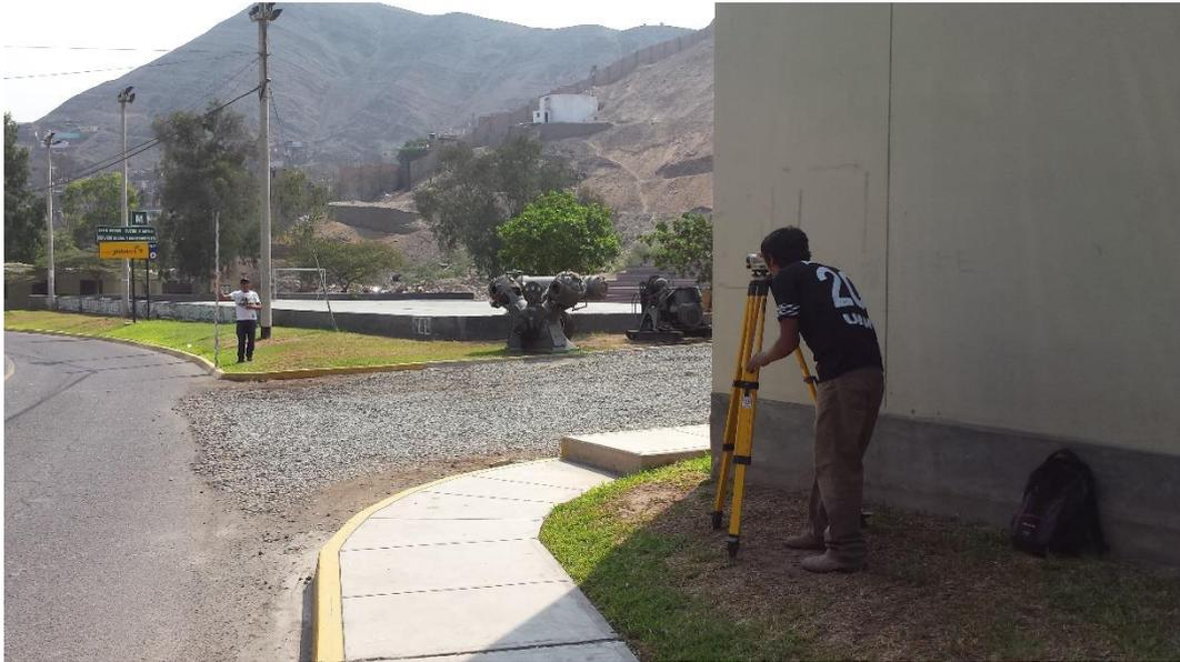
61 Figura 4.4: Proceso de nivelación geométrica, con un Nivel de Ingeniero.
