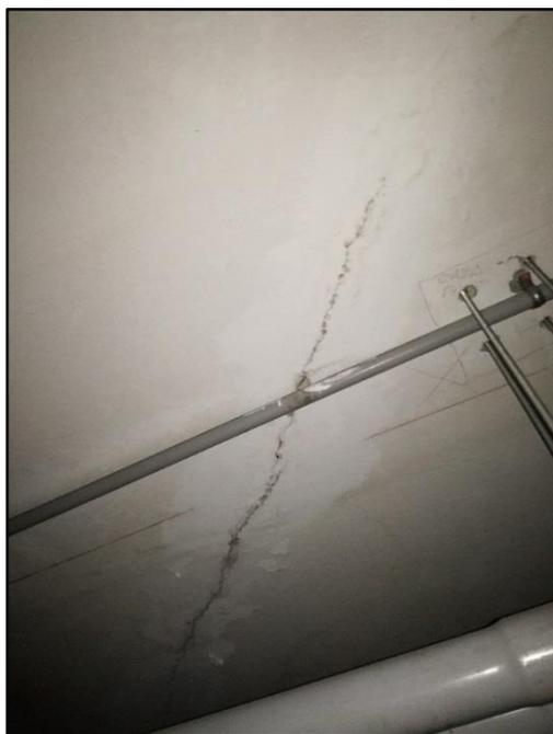
Foto 2-4: Fisura en Losa Aligerada
