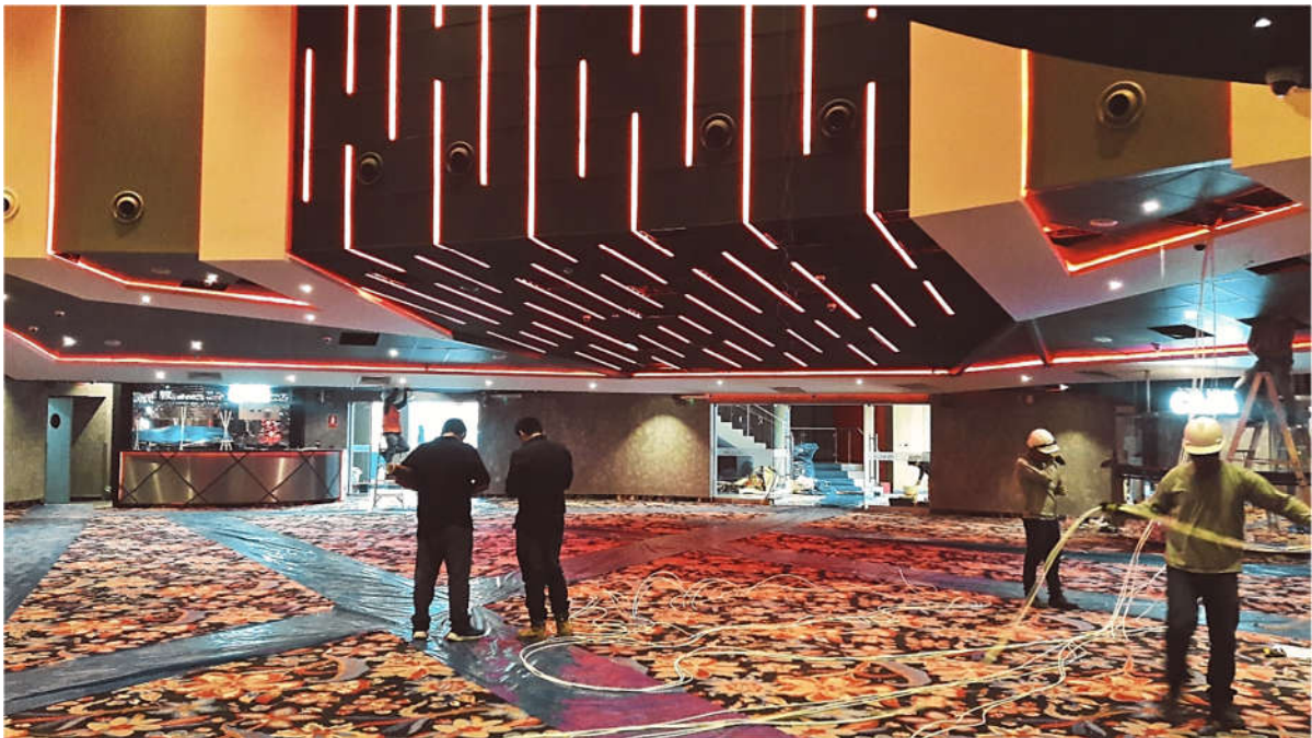
Interior acabado antes de la llegada de las máquinas tragamonedas, donde se puede apreciar la composición cromática y de texturas en toda la envolvente
