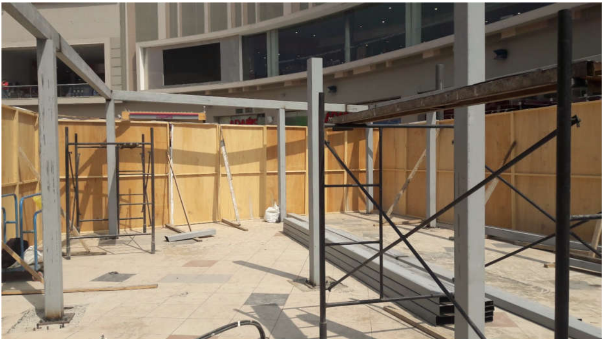
Anclaje de columnas y vigas según trazado
