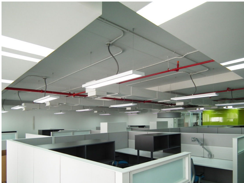
Pool de trabajo con techos expuestos e instalaciones a la vista del usuario
