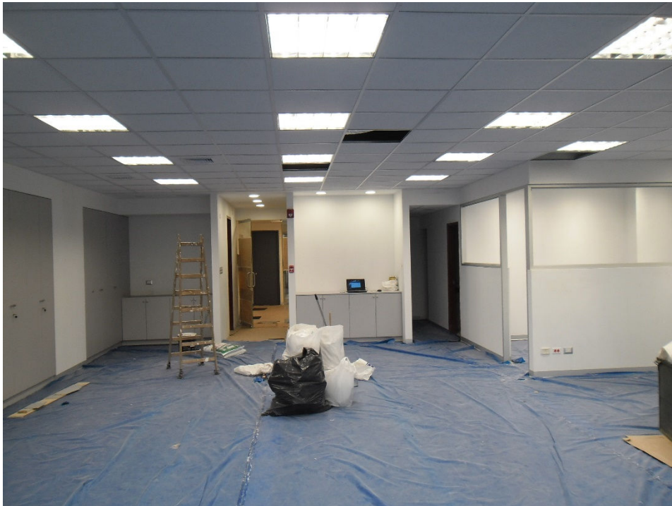
Implementación de acabados antes de la instalación de mobiliario
