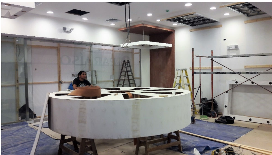
Proceso de instalación de elementos decorativos
