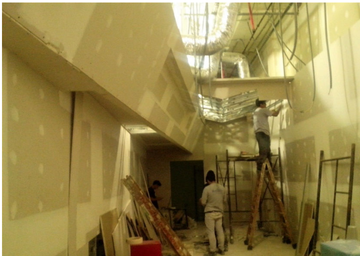
Proceso de armado de volúmenes y planos con sistema drywall
