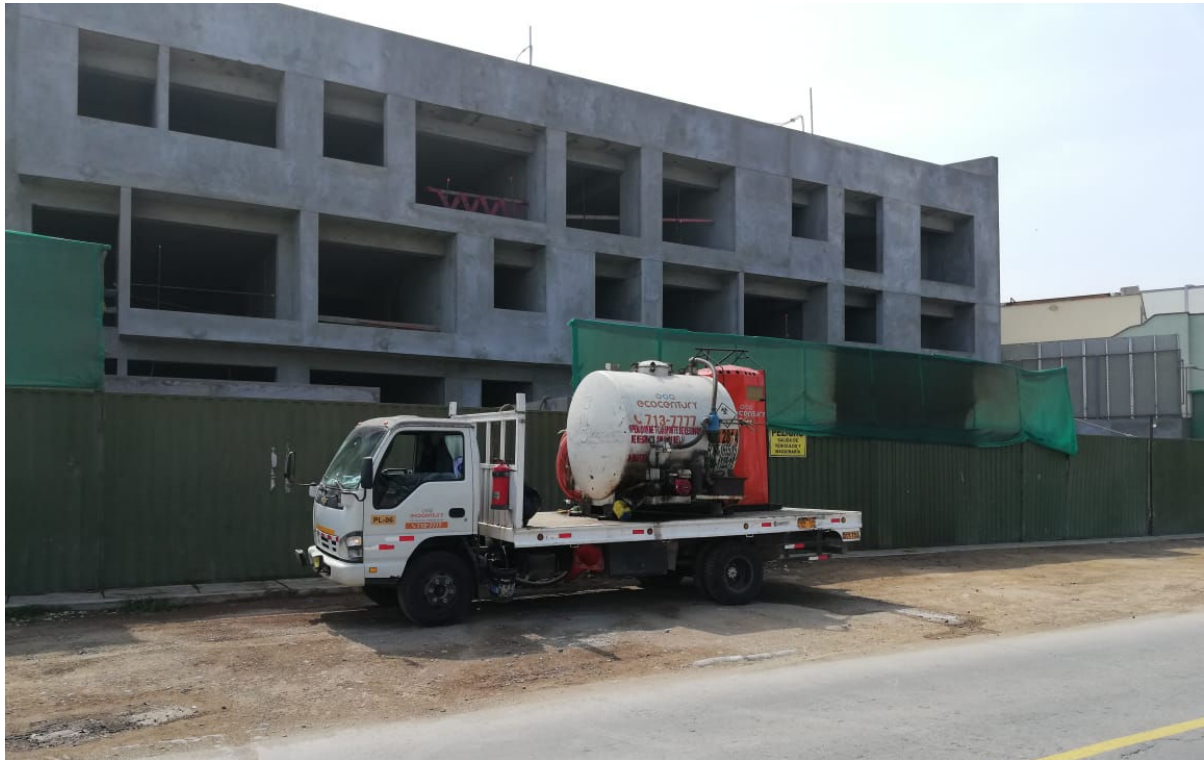
Fachada en construcción hacia la avenida Géminis
