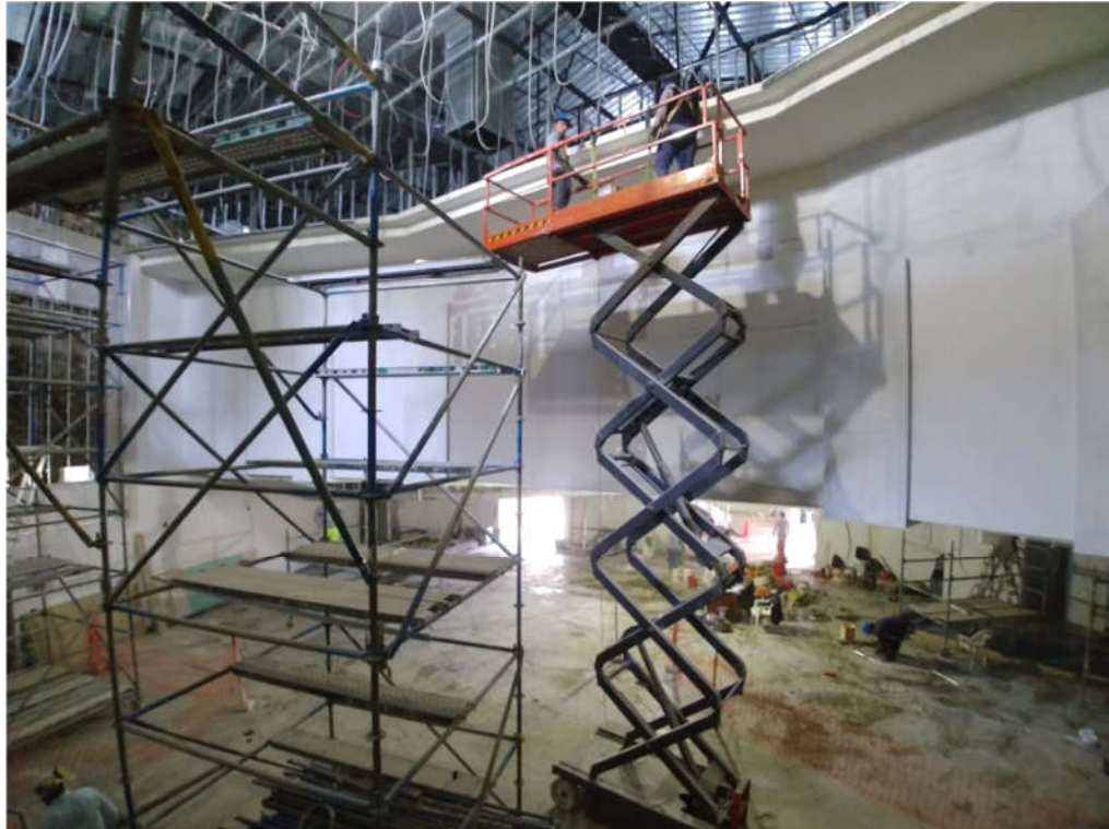
Trabajos de revestimientos de paredes de la sala con sistema drywall
