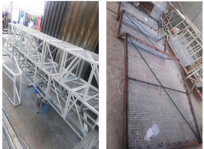
Proceso de armado de estructuras para el mobiliario
