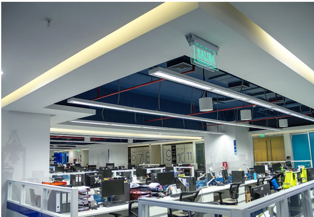
Gran área central de trabajo con instalaciones expuestas e iluminación lineal, que consiguen una armonía unificadora
