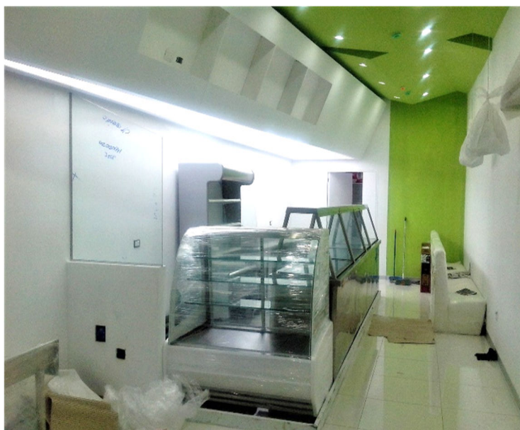
Proceso de implementación de acabados y mobiliario de atención
