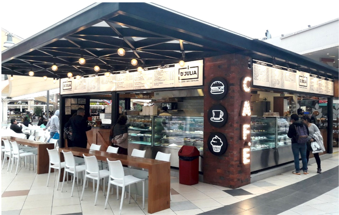
Primer plano de la terraza con estructura metálica proyectada
