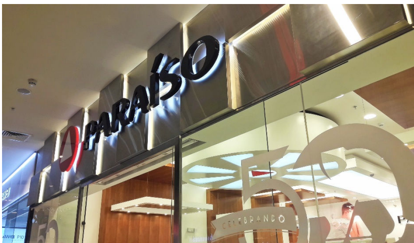
Detalle de la fachada en acero satinado con iluminación indirecta
