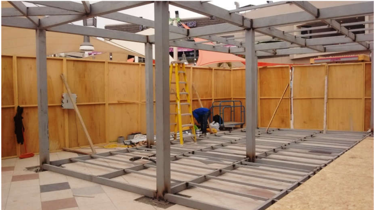
Tejido de estructuras para techo y tarima
