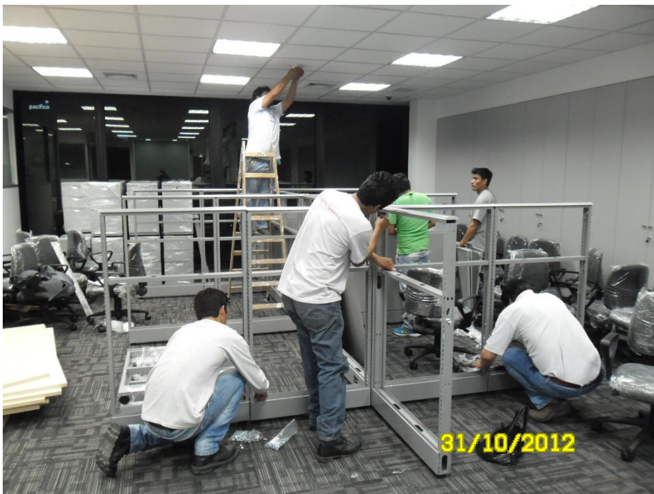
Armado de mobiliario modular para los puestos de trabajo
