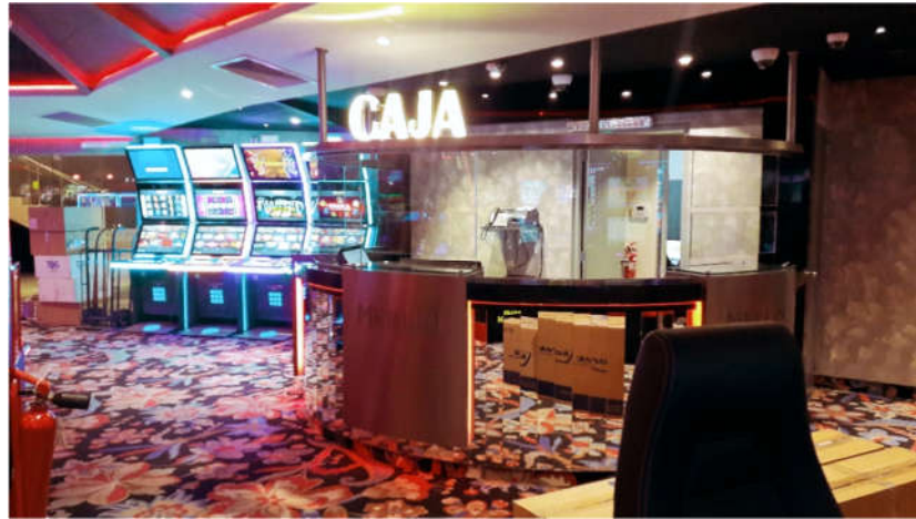
Mueble caja terminado con letras iluminadas en acrílico y carpintería de vidrio y acero
