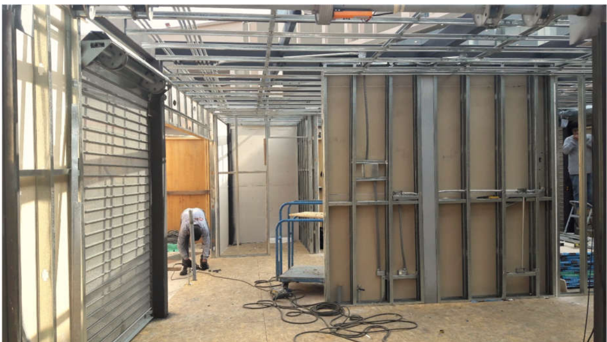
Divisiones de drywall y piso de planchas de OSB
