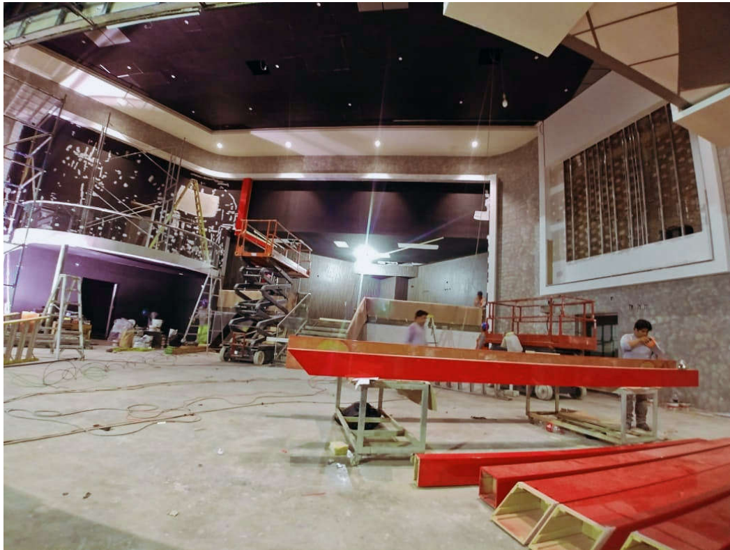
Trabajos de carpintería luego de la instalación del sistema drywall
