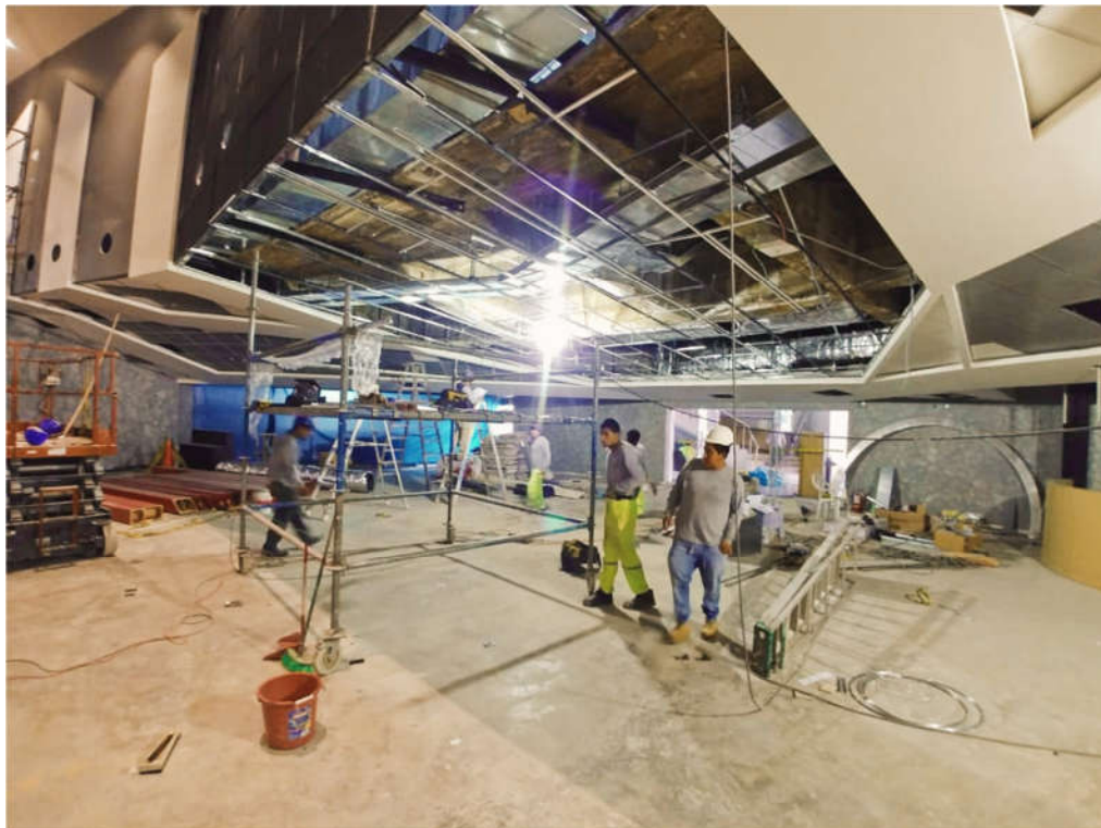
Trabajos de instalación de estructura drywall para el techo bajo de la sala
