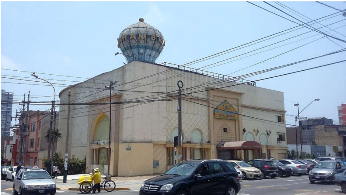
Fachada existente de estilo morisco
