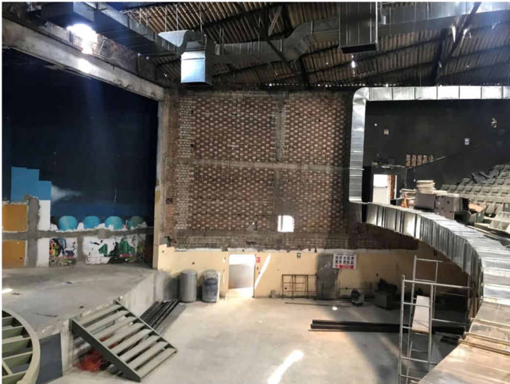
Infraestructura existente, con las graderías o mezanine a la derecha y la futura zona vip a la izquierda
